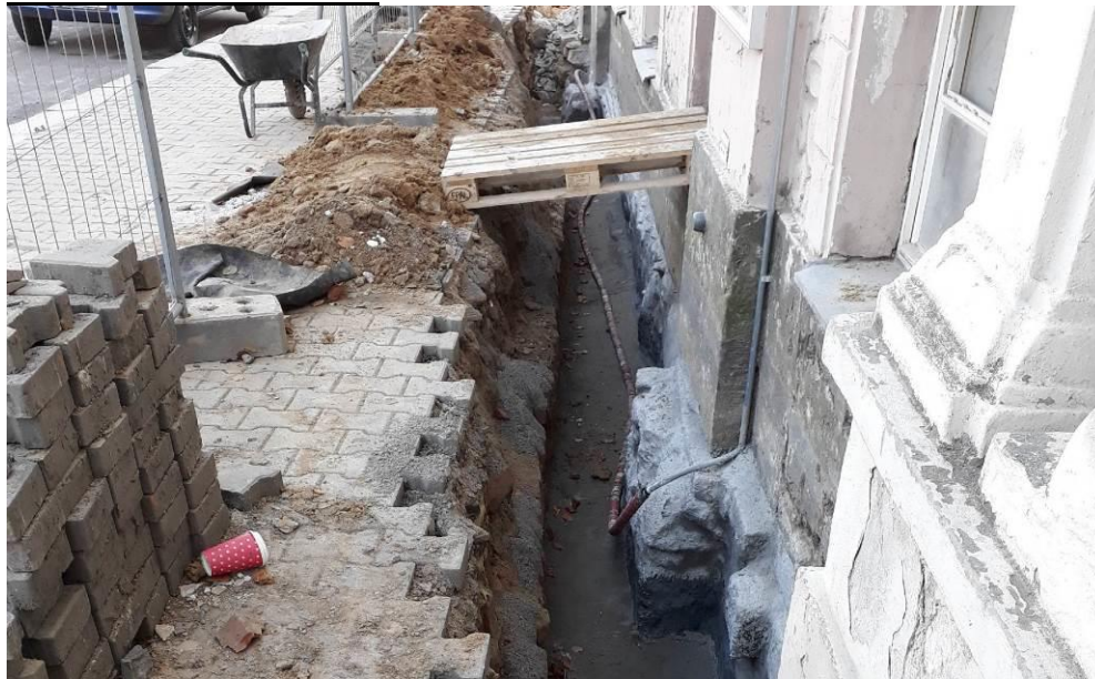
Foto z provádění sanace suterénu a telekomunikační vedení
