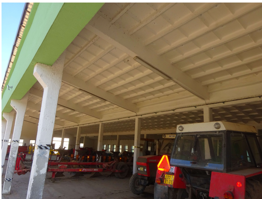
Střešní konstrukce (částečně dřevěný rošt, na který je uložena plechová krytina)
