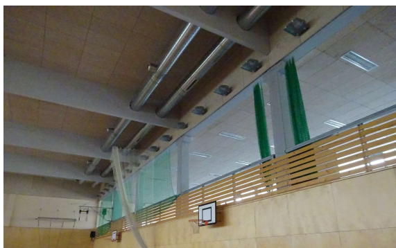
Otvory ve vaznících pro vstup vzduchotechniky
