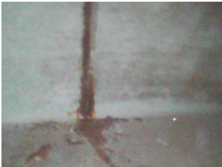
Obr. 15: Prorezlá smyková výztuž uvnitř nosníku KA - 73
