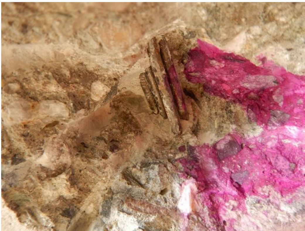
Obr. 13: Karbonatace betonu na spodním líci nosníku KA-73
