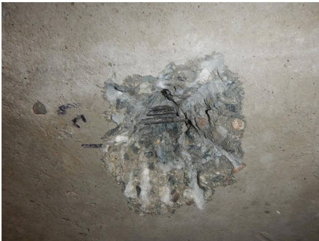
Obr. 12: Sonda k výztuži, předpínací dráty v kabelu
