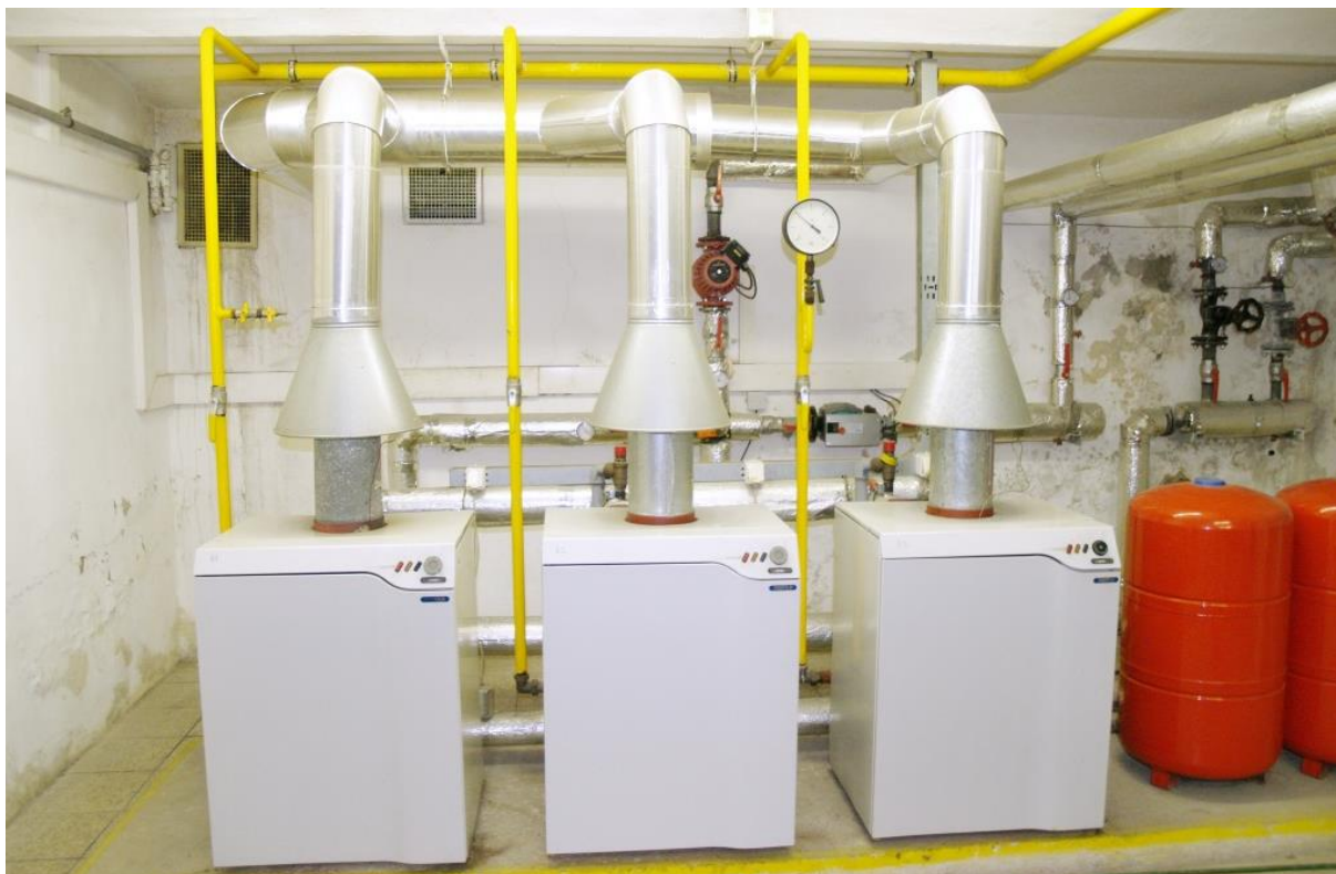
11 Tepelný zdroj pro starou budovu v suterénu, tři plynové kotle Destila DPL 50 A z roku 2001, vpravo dvě expanzní nádoby o objemu 140 l, vzadu na stěně čtyřcestný ventil s regulátorem a oběhovými čerpadly
