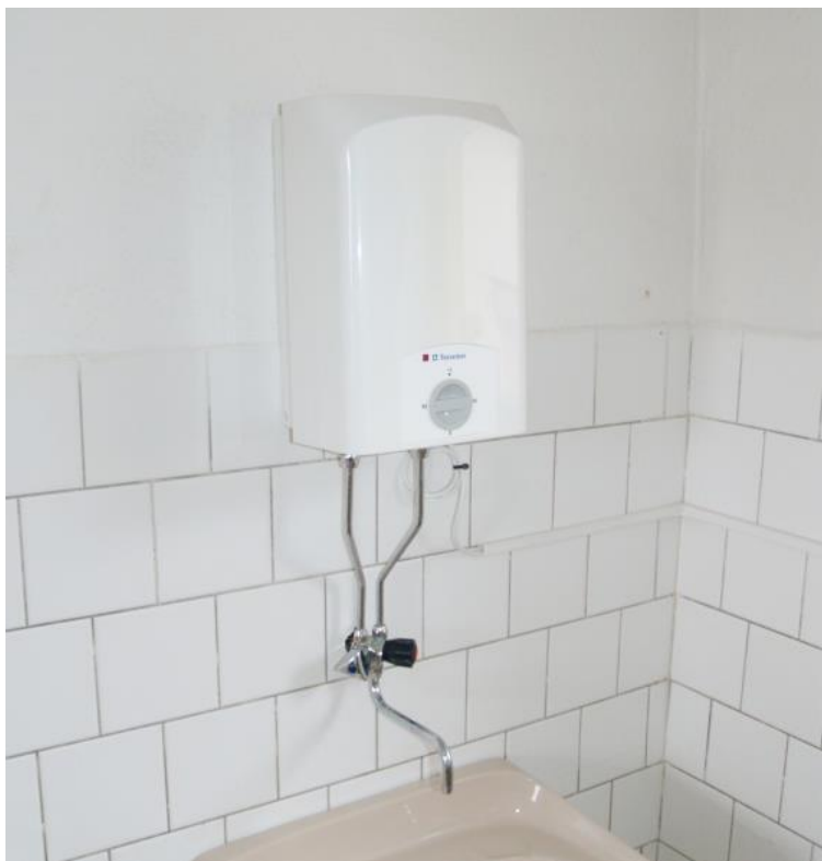
15 Elektrický ohřívač teplé vody Tatramat EO5 N v umýárně staré budovy
