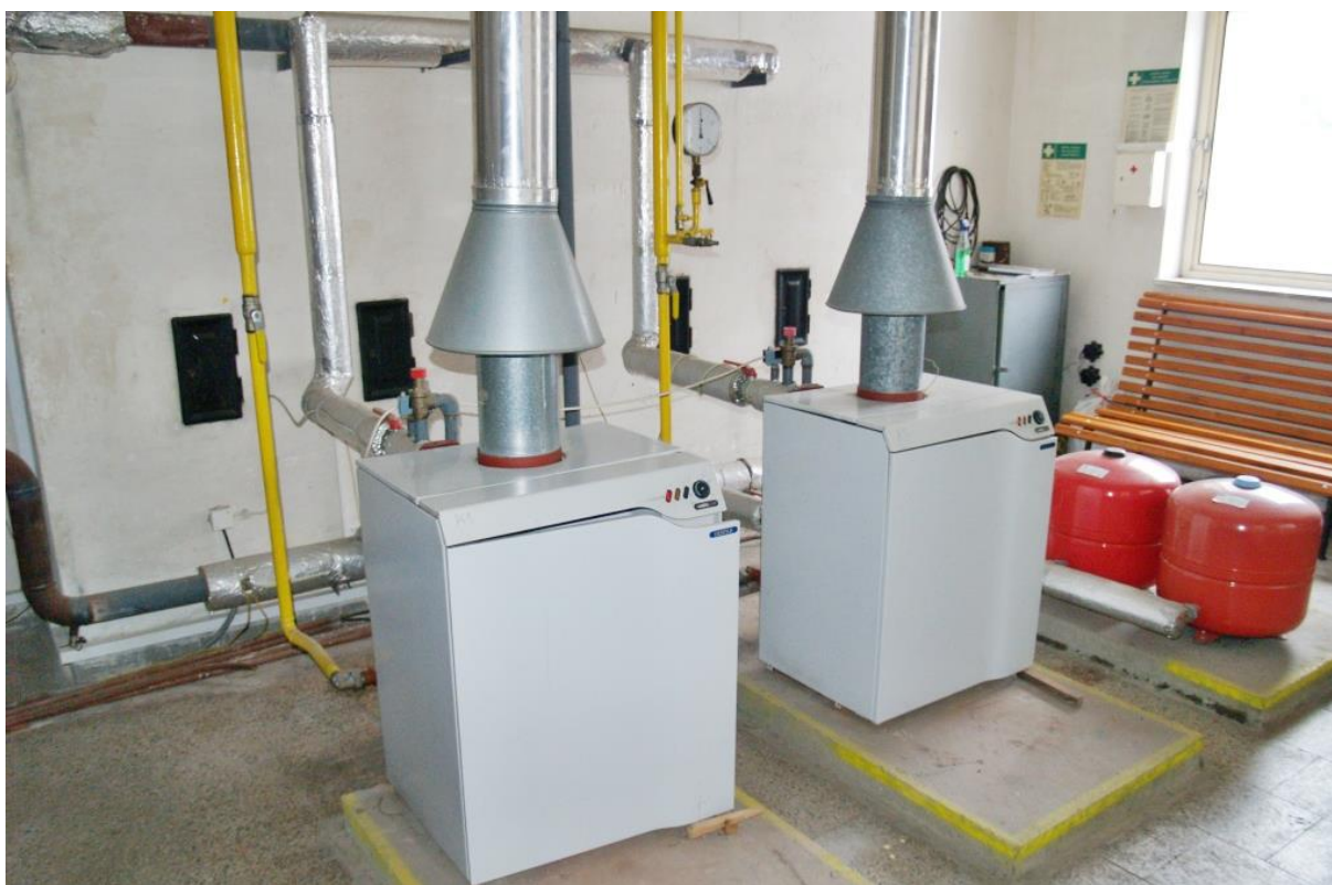
12 Tepelný zdroj pro novou budovu v kotelně, dva plynové kotle Destila DPL 50 A z roku 2001, vpravo dvě expanzní nádoby o objemu 80 l
