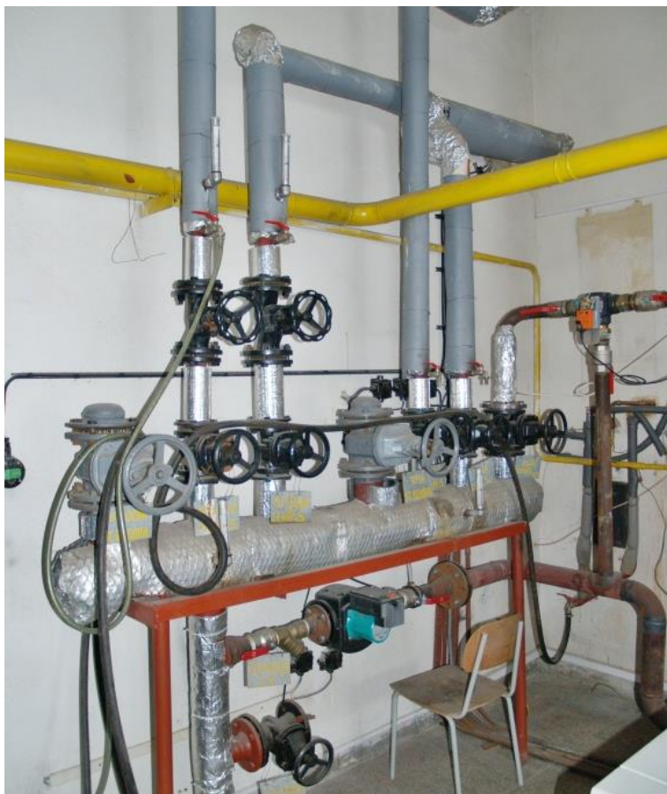
13 Rozdělovač a sběrač a kotlový okruh v kotelně nové budovy, trojcestný ventil s regulátorem, oběhové čerpadlo, z rozdělovače vedou dvě otopné větve
