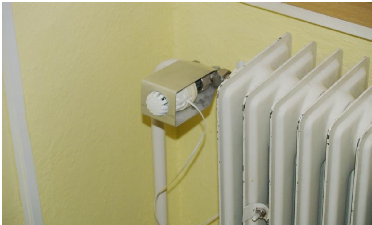
14 Detail ocelového článkového otopného tělesa s termostatickým ventilem a hlavicí s ochranou proti poškození
