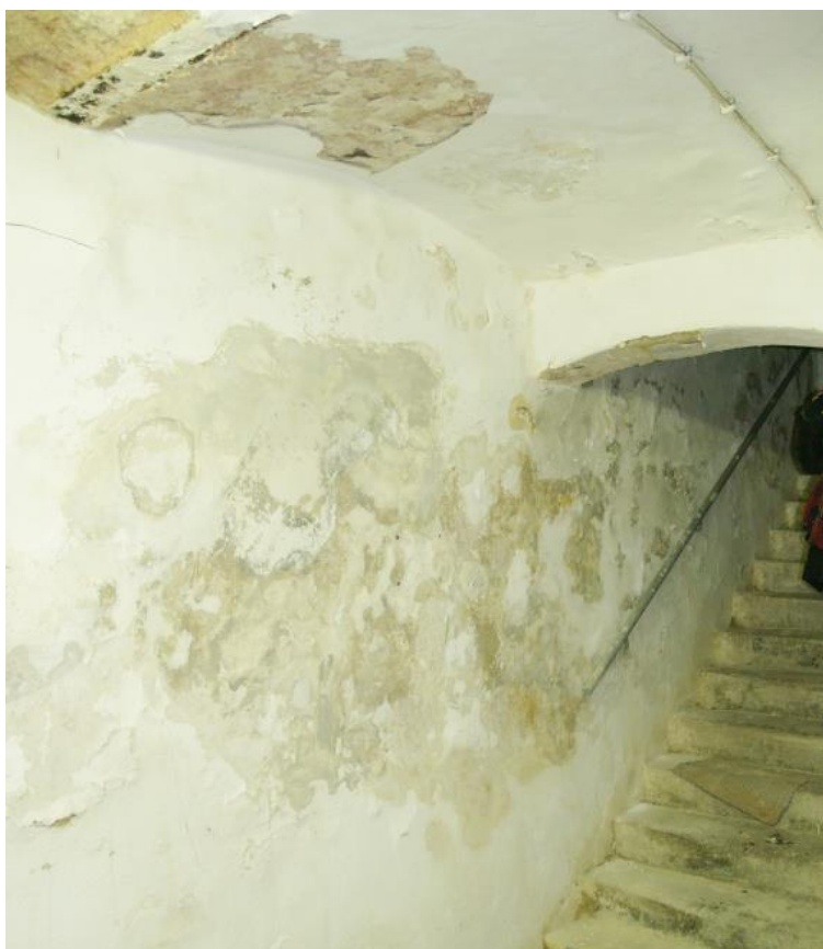
10 Suterén staré budovy s patrným poškozením způsobeným nadměrnou vlhkostí v konstrukci
