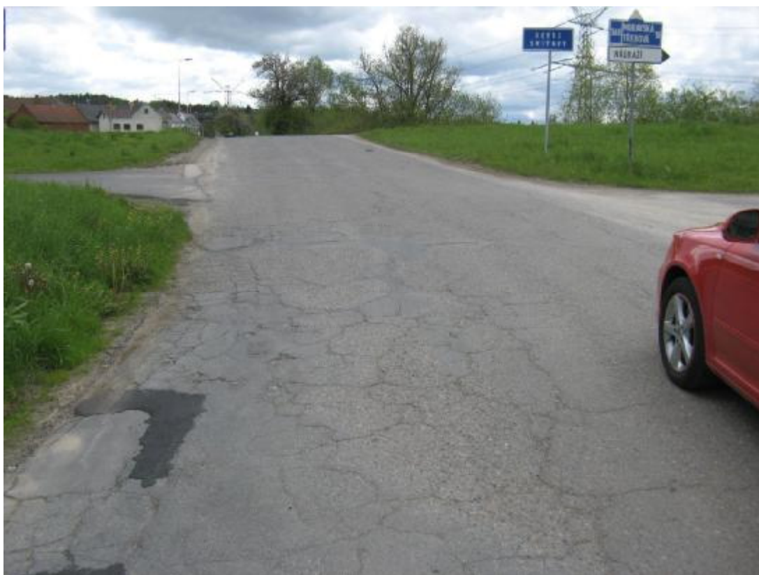
F97, km 1,910+ Celoplošné mozaikové nebo síťové trhliny.
