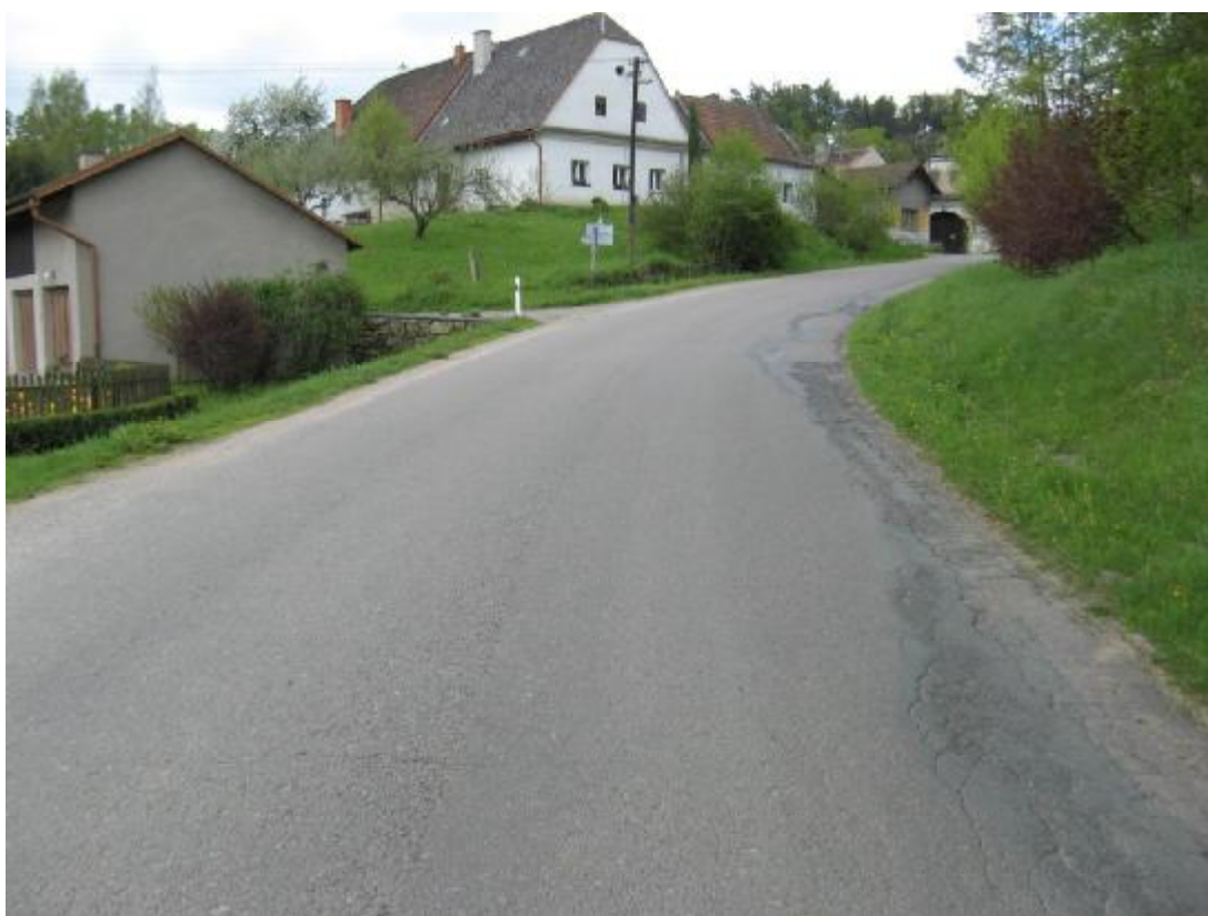
F04, km 0,110+ Síťové trhliny vpravo.
