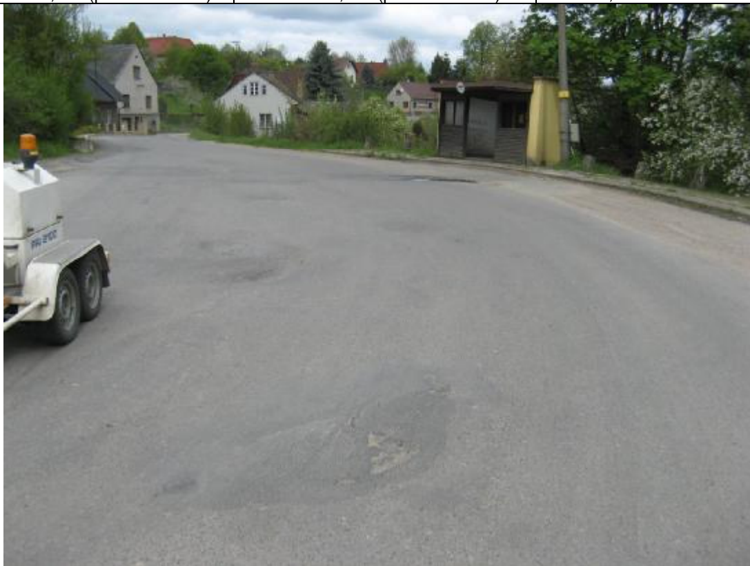
F92, km 1,700- Výrazné plošné deformace.
