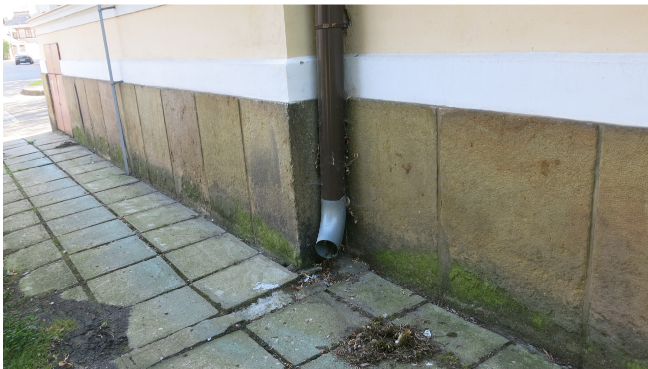
Nevhodně svedené dešťové vody – řešeno v přiložené projektové dokumentaci
