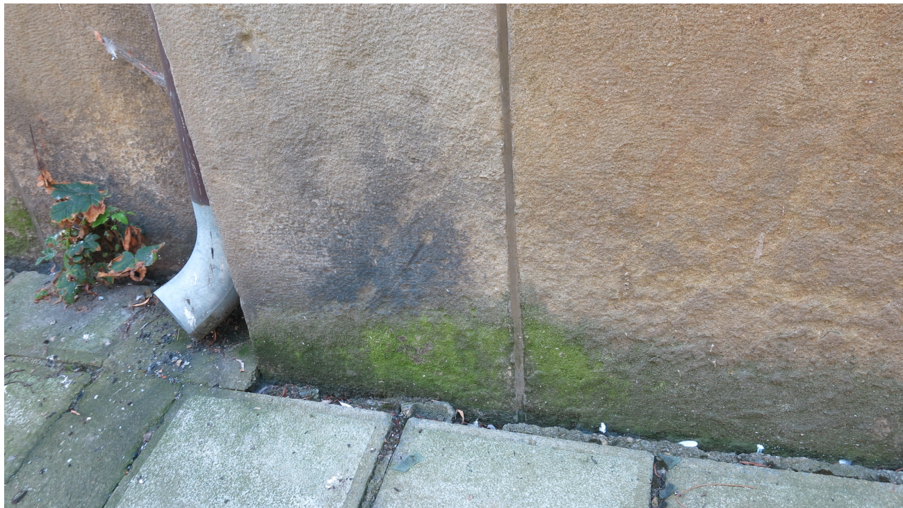
Nevhodně svedené dešťové vody – řešeno v příložené projektové dokumentaci
