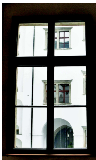
Fotografie stávajícího stavu
