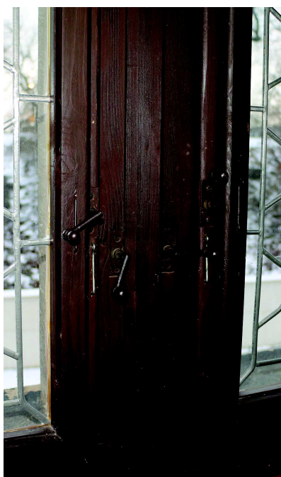
Fotografie stávajícího stavu
