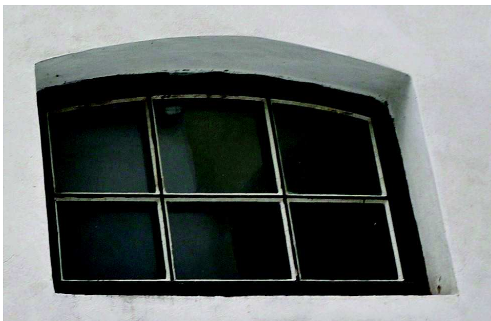
Fotografie stávajícího stavu
