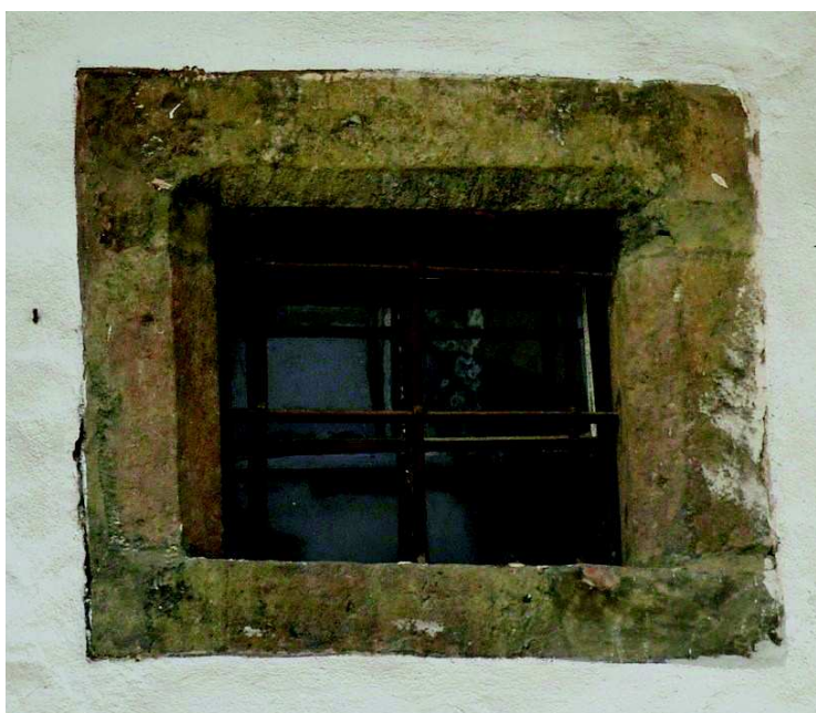
Fotografie stávajícího stavu
