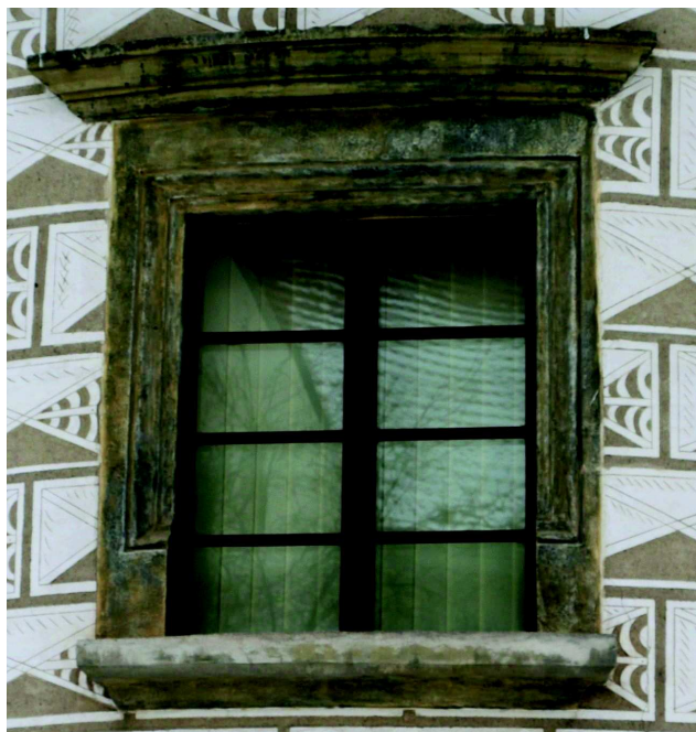
Fotografie stávajícího stavu
