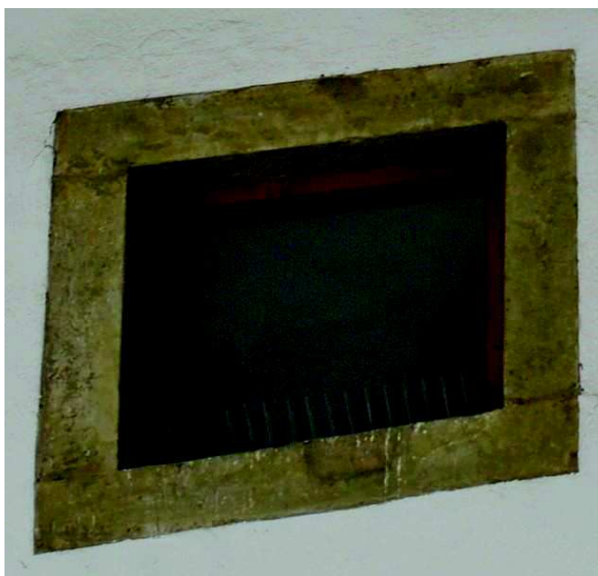
Fotografie stávajícího stavu
