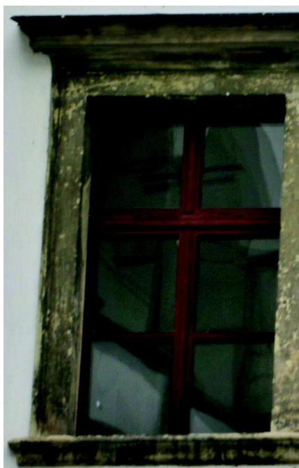
Fotografie stávajícího stavu
