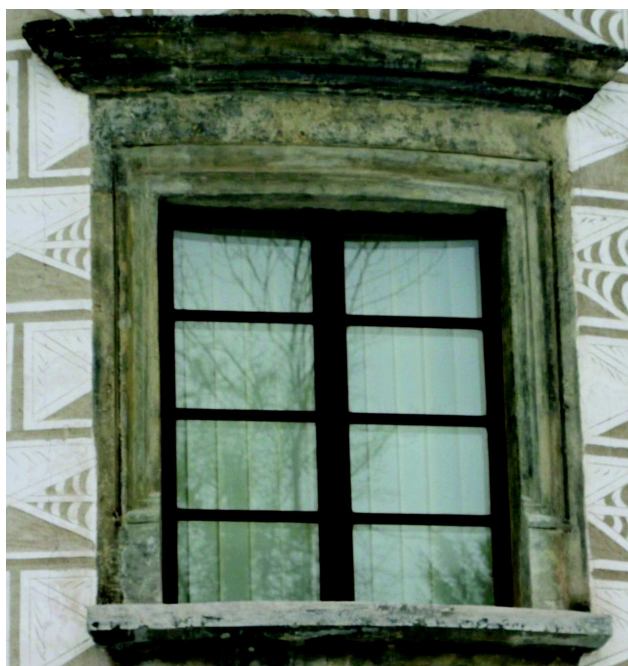
Fotografie stávajícího stavu
