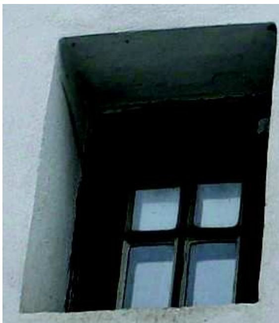
Fotografie stávajícího stavu
