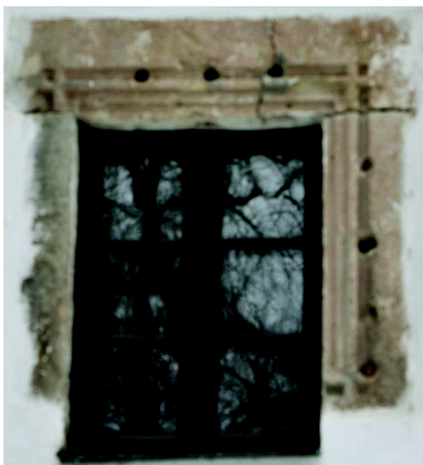
Fotografie stávajícího stavu
