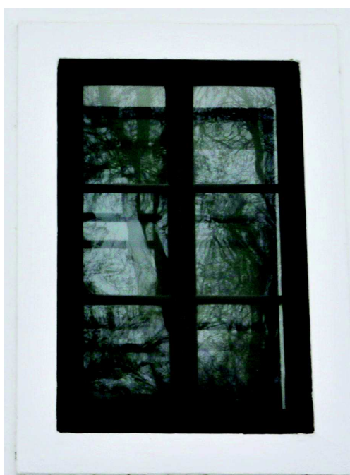
Fotografie stávajícího stavu
