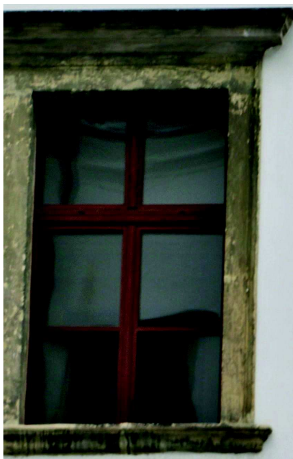
Fotografie stávajícího stavu
