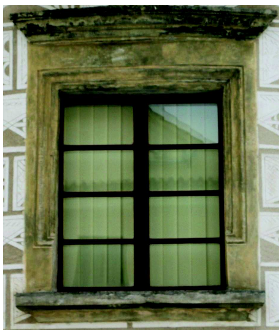
Fotografie stávajícího stavu
