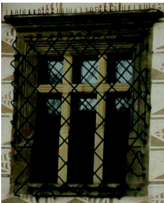
Fotografie stávajícího stavu
