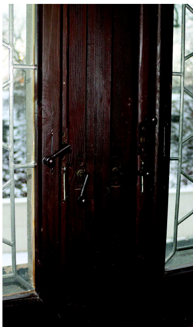
Fotografie stávajícího stavu
