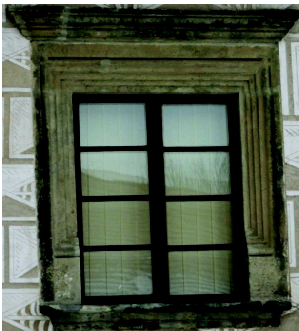
Fotografie stávajícího stavu
