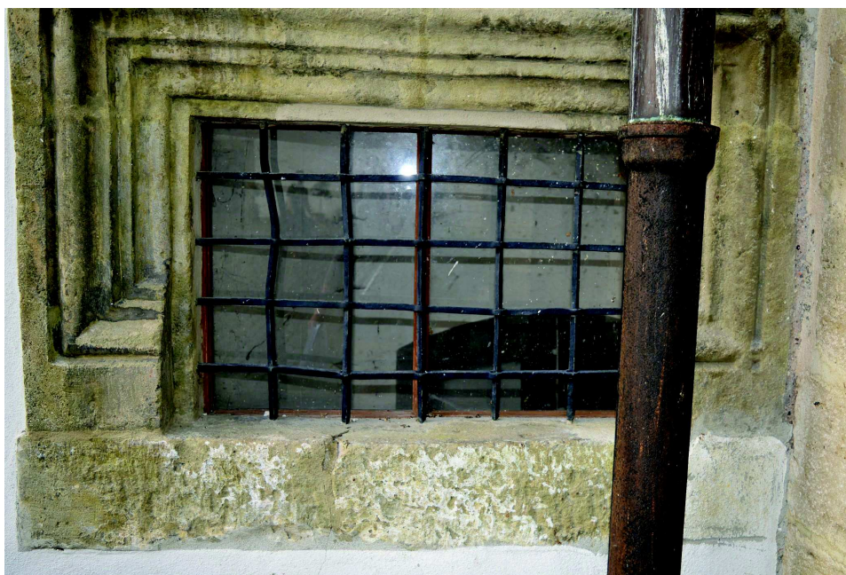
Fotografie stávajícího stavu
