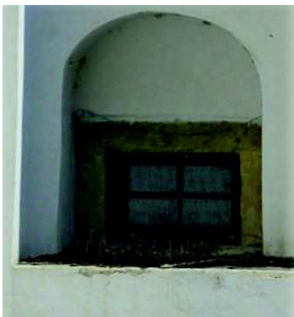
Fotografie stávajícího stavu
