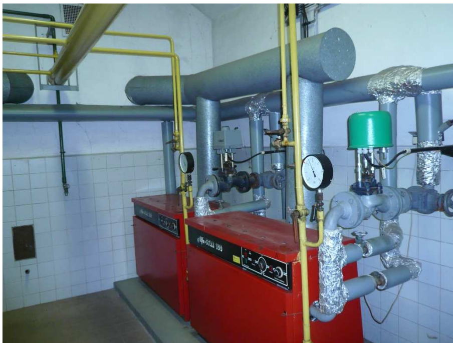
Obr.: Původní kotle ALFA-STAR 100
