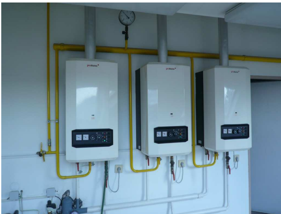
Obr.: Kotle PROTHERM 24 KT, instalované v kotelně v 4. NP
