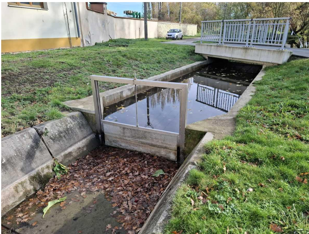
Pohled na stávající náhon a stavidlový uzávěr na vtoku do náhonu
