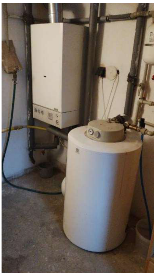
Obrázek 8: Zdroj tepla 1 – kotel na zemní plyn v suterénu.
