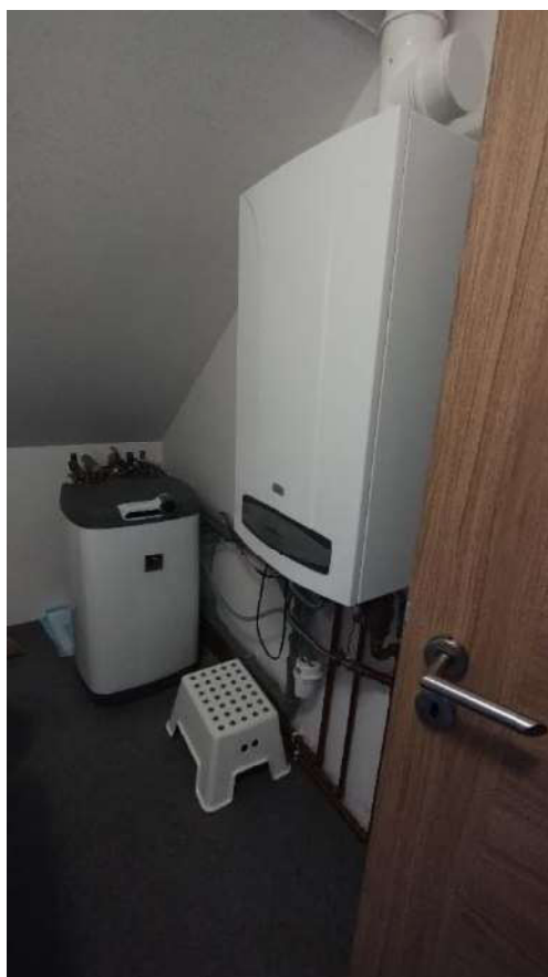
Obrázek 9: Zdroj tepla 2 – kotel na zemní plyn v suterénu.
