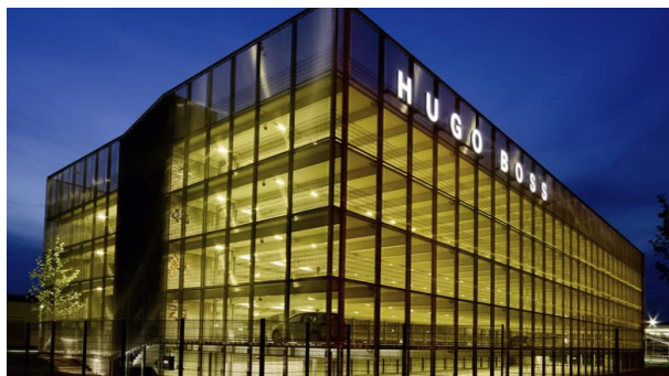
Obr. 4.7: Příklad parkovacího domu (Metzingen)
