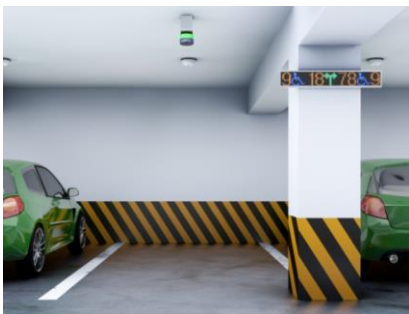
Obr. 4.8: Příklad signalizace obsazenosti míst pomocí ultrazvuku (včetně navádění do směrů)
