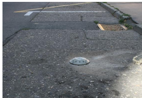
Obr. 4.9: Příklad instalace povrchového magnetometrického detektoru
