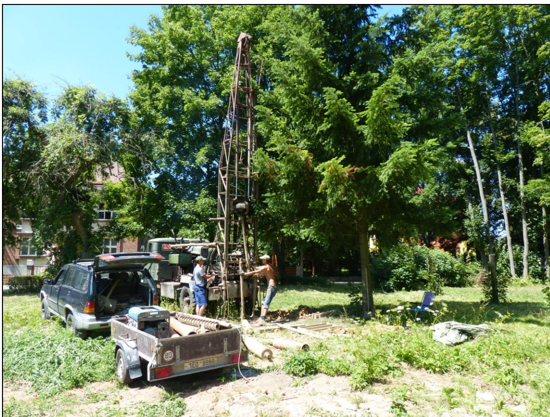
Foto č. 11-12 : Hloubení průzkumných jádrových vrtů V-3 a V-4 rotační vrtnou soupravou UGB 50 M (průměr vrtů 197-137 mm, konečná hloubka 12,00 m (V-3 i V-4) (foto 29.06. a 03.07. 2018)
