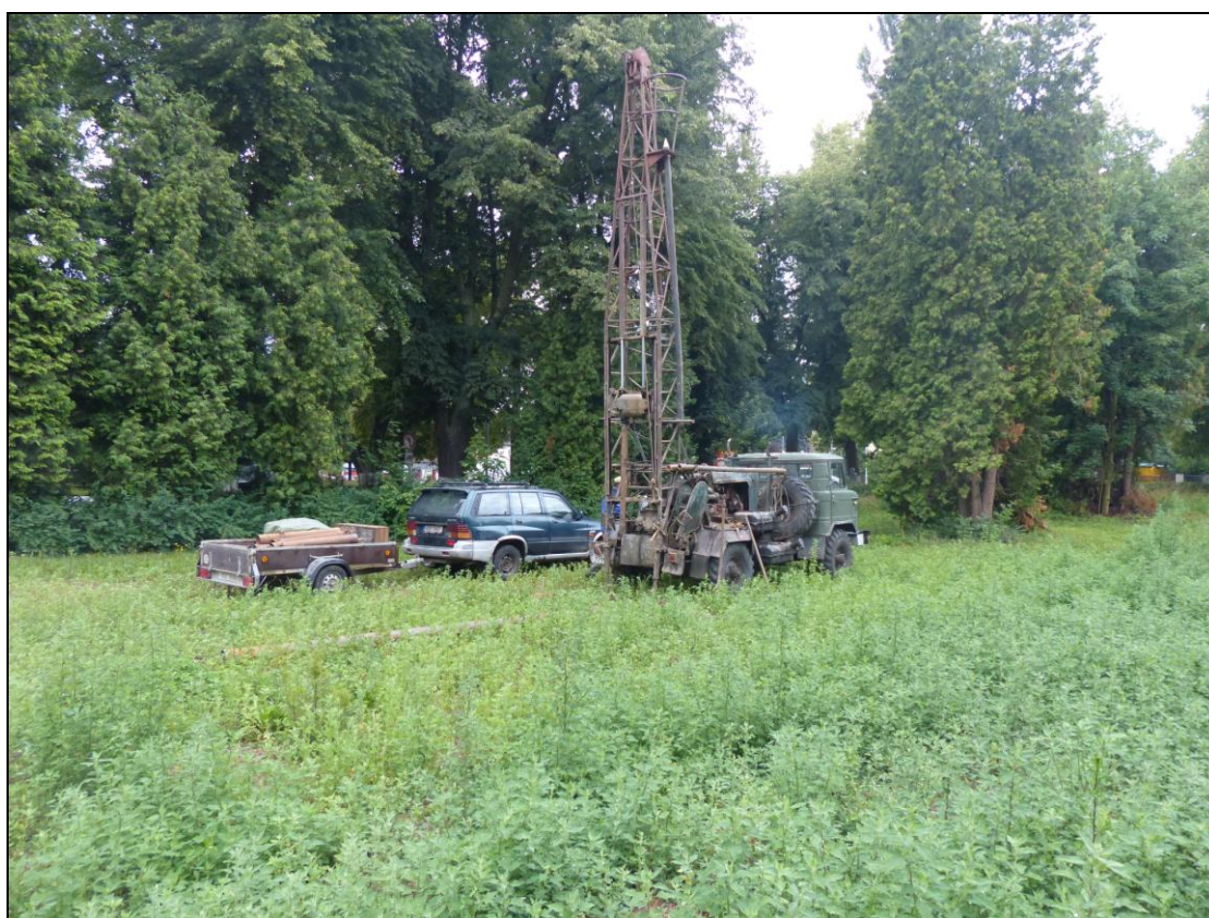
Foto č. 9-10 : Hloubení průzkumných jádrových vrtů V-1 a V-2 rotační vrtnou soupravou UGB 50 M (průměr vrtů 197-137 mm, konečná hloubka 10,00 m (V-1), resp. 12,00 m (V-2) – foto 28. a 29.06. 2018)
