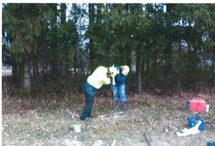
Foto č. 5: Hloubení průzkumné geologické sondy GS-3.
