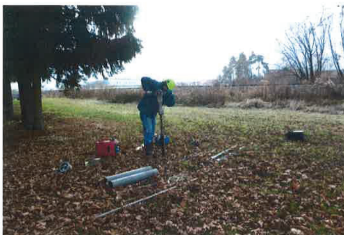
Foto č. 1: Hloubení průzkumné geologické sondy GS-1.
