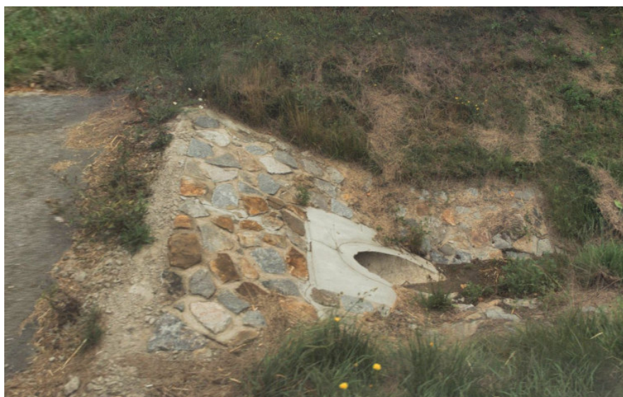
Praktický příklad realizace šikmých čel propustků směrem na Choceň - detail
