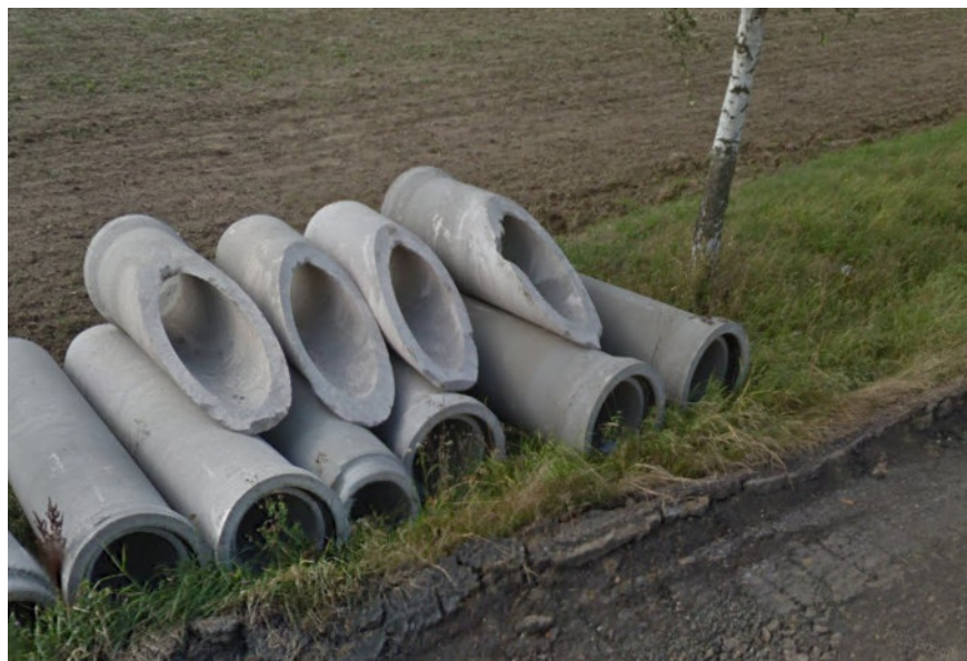
Praktický příklad realizace šikmých čel propustků, je nutné zachovat co nejpozvolnější sklon minimálně 1:2
