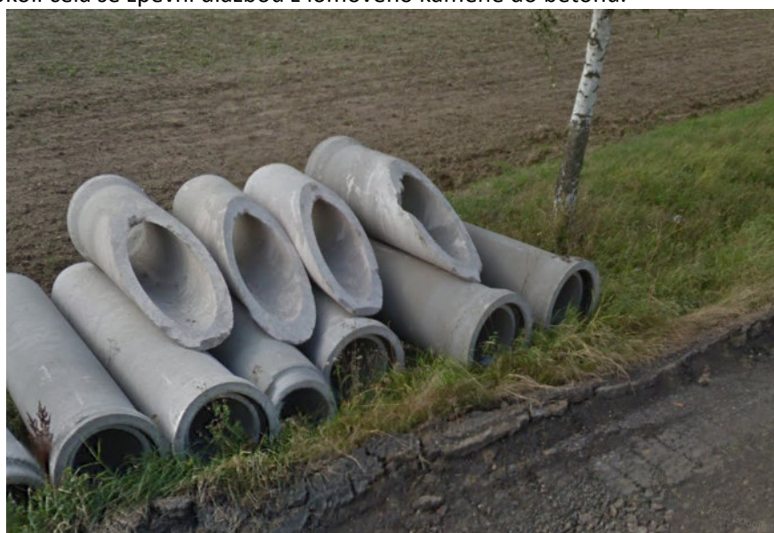
Praktický příklad realizace šikmých čel propustků, je nutné zachovat co nejpozvolnější sklon minimálně 1:2
