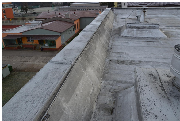
Detail vyvýšeného okraje střechy na budově DM4, pod sešikmenou částí jsou dutiny obývané netopýry.
