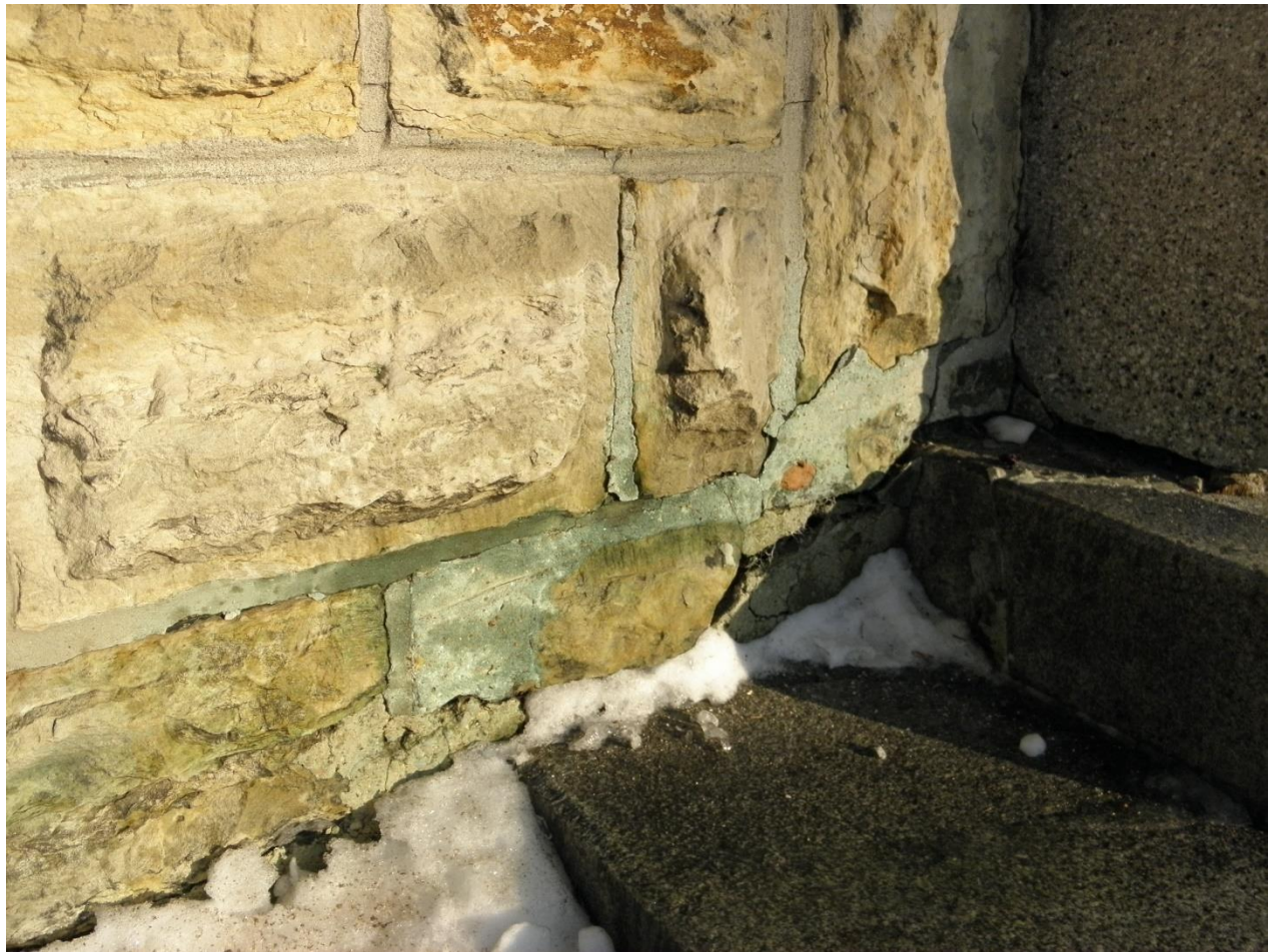
Úsek A – zvlhčení spodních partií, nevhodné opravy
