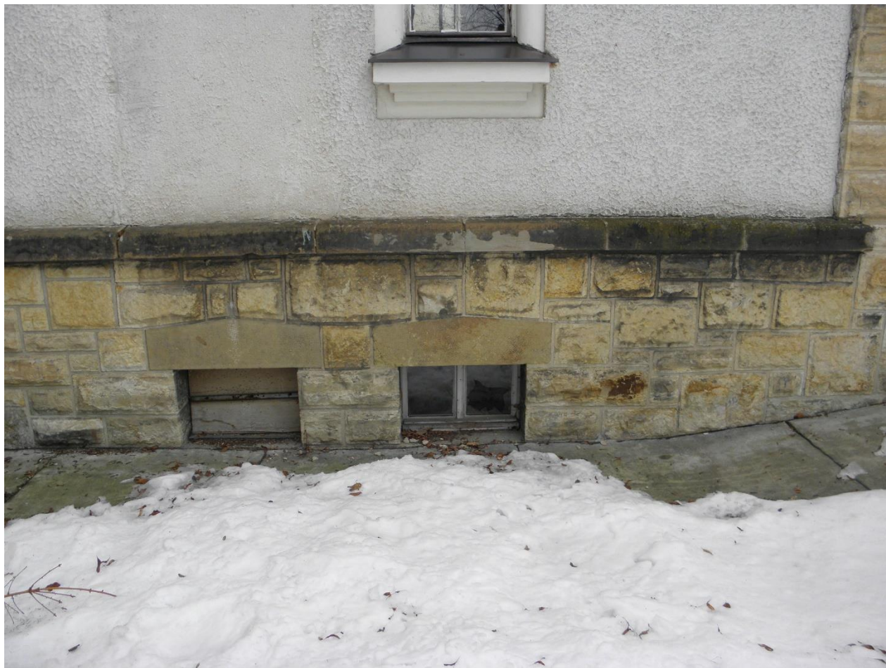
Úsek L - římsa výrazně ztmavlá, na spodní ploše krusty s korodující horninou přecházející na zdivo, na povrchu lišejník, spáry uvolněné, uprostřed výrazná nepěkná vysprávka
