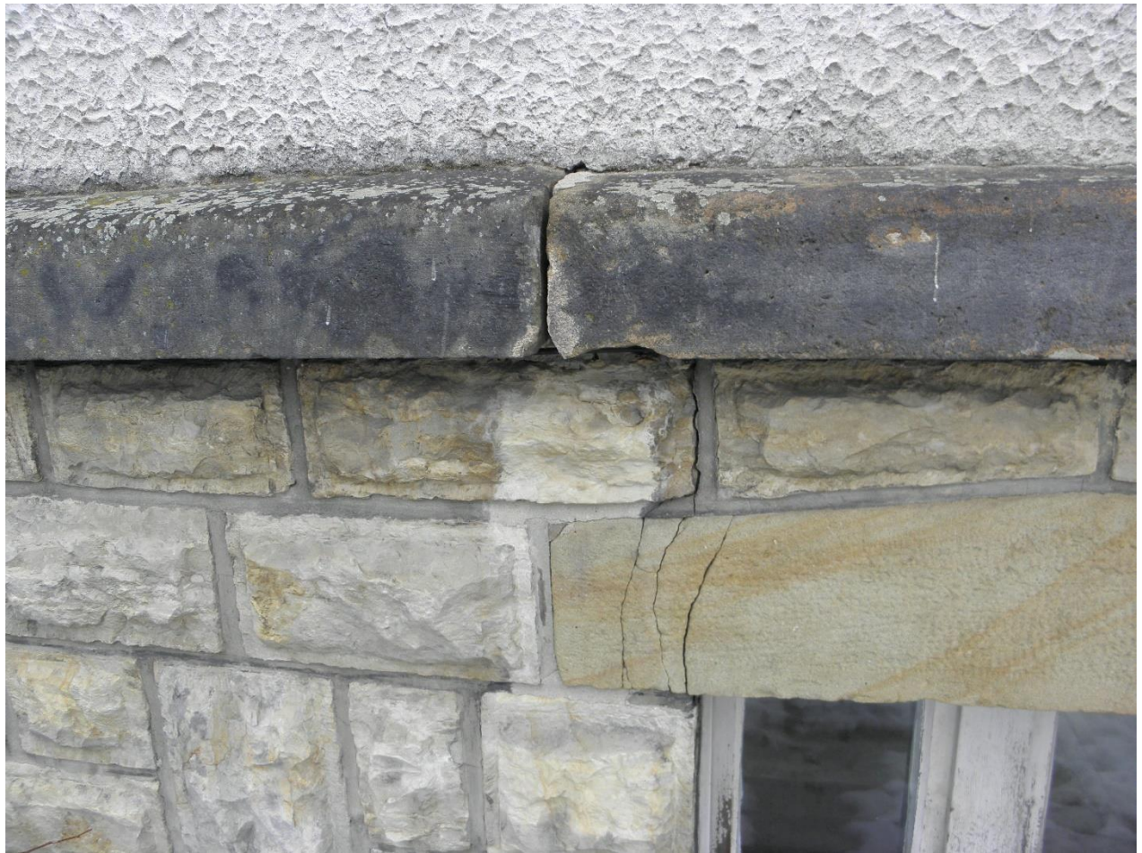
Úsek P – další detail více vlevo; překlad okna součástí tektonické trhliny
