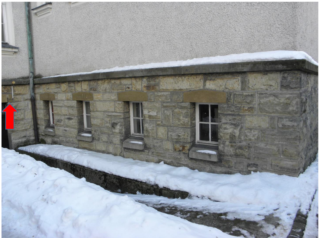
Úsek E – lokálně vrstevnatě erodující opuka zdiva; překlady oken stabilní; římsa znečištěná, nekvalitní vysrávky; lokálně opukové bloky zdiva nahrazeny kompozitními, ➡ poškození elektroinstalací
