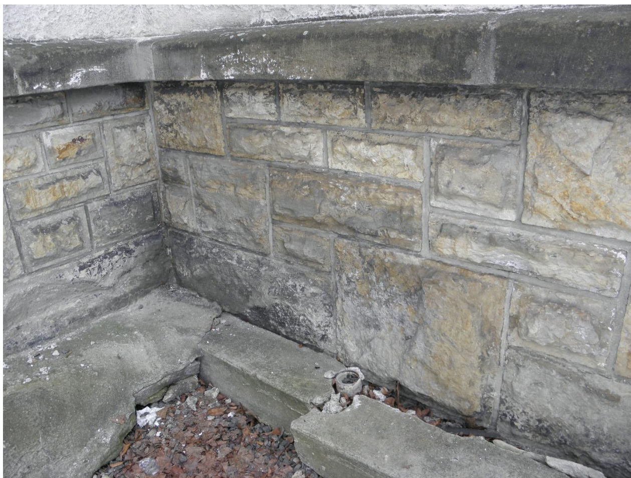
Úsek J – detail, patrné tmavé povlaky a krusty, na zemi nekvalitní obetonávka
