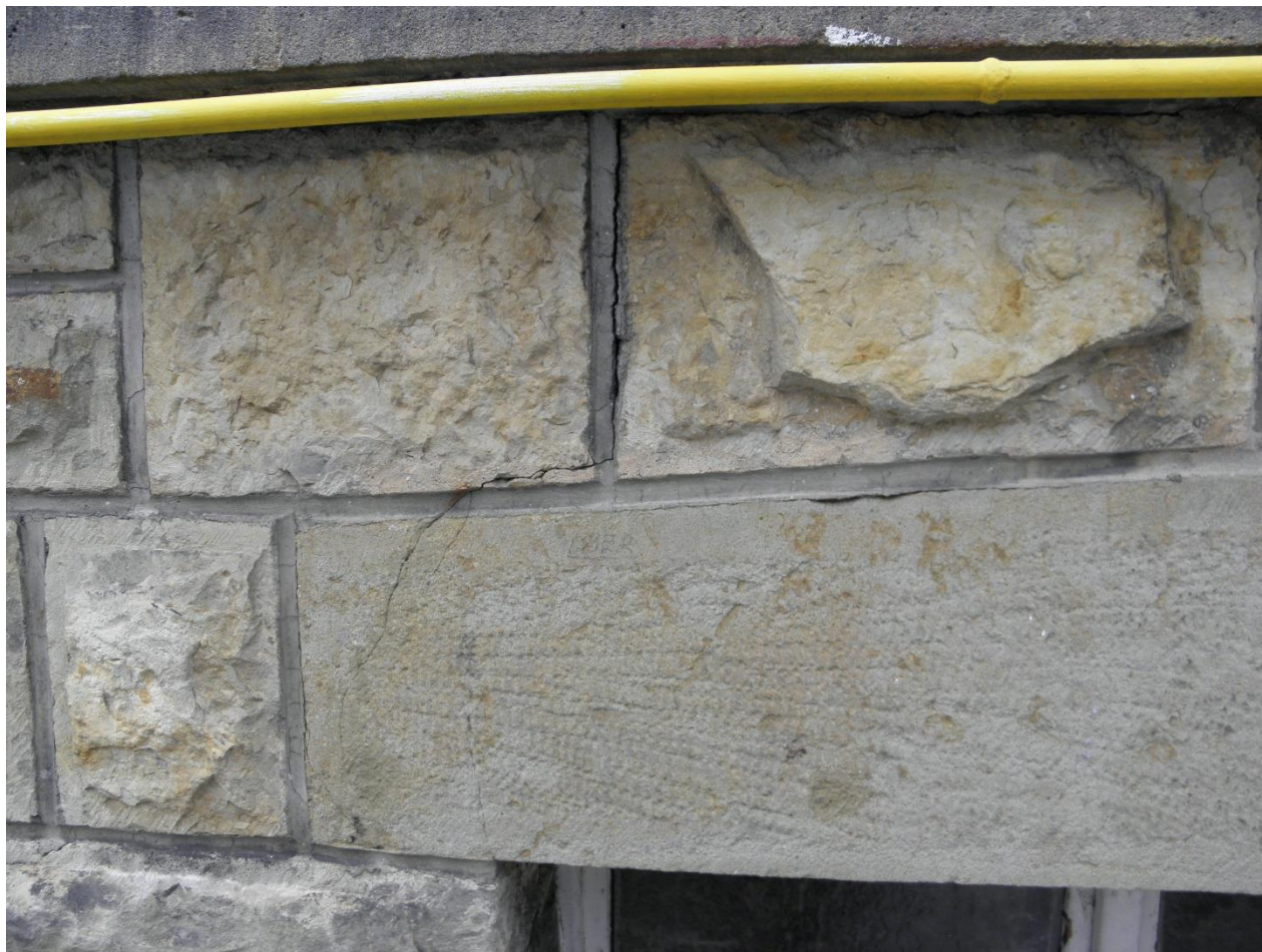
Úsek N – detail zachycující tektonickou trhlinu navazující na destrukci ve zdivu
