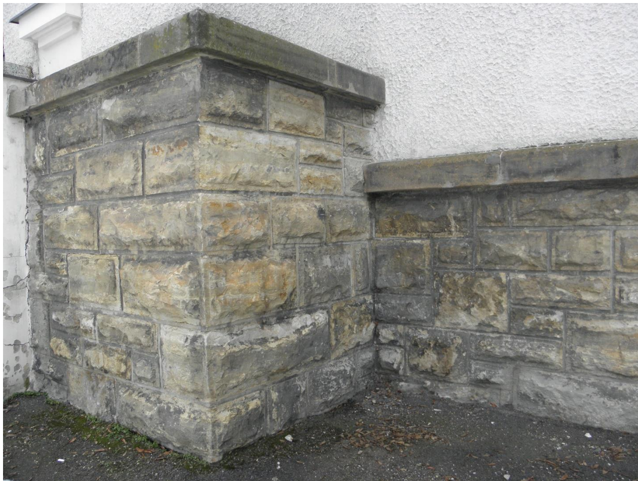
Úsek K – římsa lokálně ztmavlá, zališejníkováná, s nekvalitními vysprávkami; zdivo s tmavým povlakem
