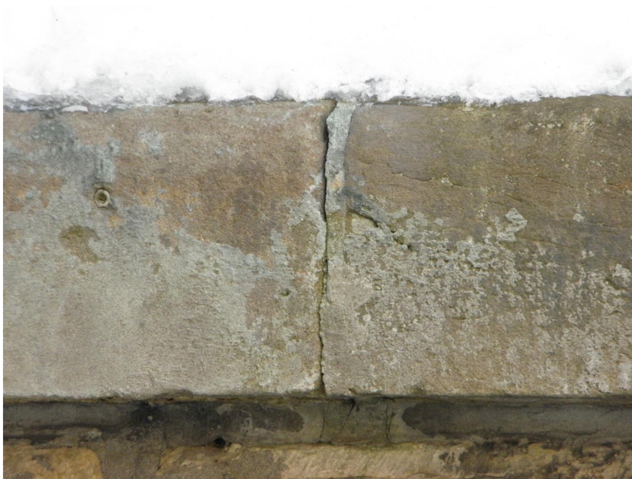
Úsek E – detail na římso, povrchově znehodnocená maltovinami, uvolněné spáry římso i zdiva
