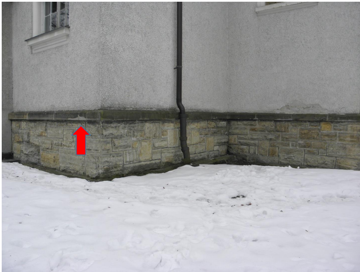
Úsek I – římsa ztmavlá a porostlá řasou a lišejníkem, více nekvalitních vyžilých vysprávek, ➡ lokalizace detailu níže
