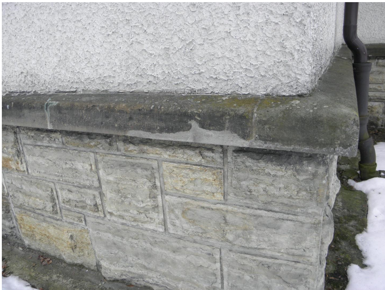
Úsek I – detail obrázku výše, depozity a vysprávky znehodnocující povrch římsy
