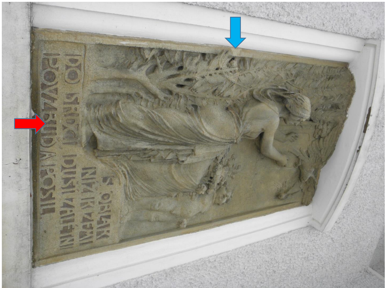
Reliéf na průčelí tělocvičny vlevo – celoplošná eroze v diferencovaném stadiu podle exponovanosti lokality, ➡ dělicí spára, ➡ barevná úprava – viz přílohy
