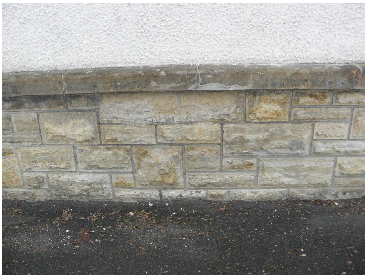
Úsek K – římsa potřísněná maltovinami, nekvalitní vysprávk; zdivo ve srážkovém stínu tmavé, uprostřed obrázku pod římsou dva kvádry nahrazené kompozitní imitací
