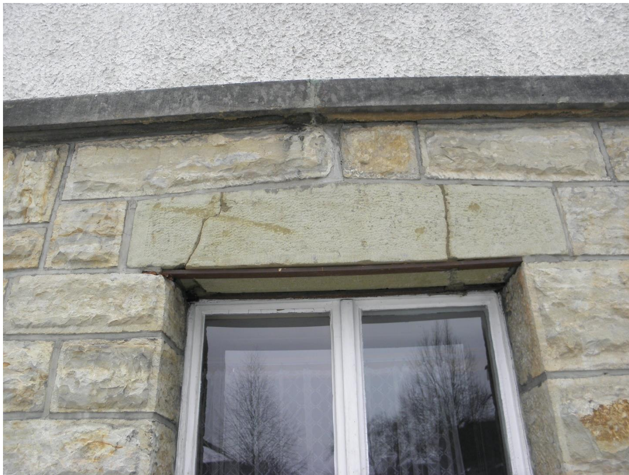
Úsek N – detail, viz výše, římsa vespodu eroduje; nadvakrát prasklý okenní překlad provizorně zajištěn
