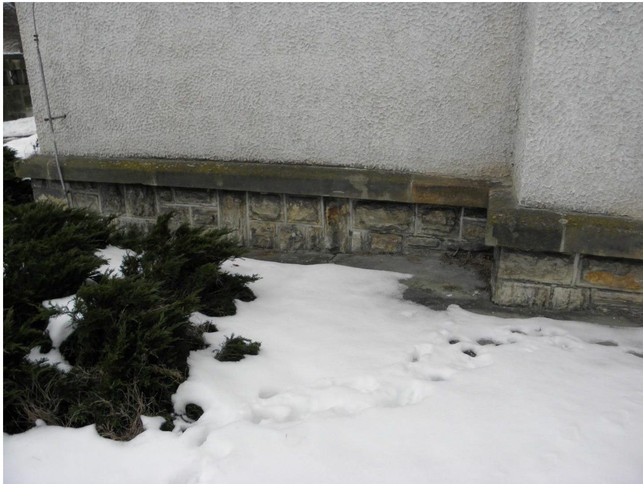
Úsek O – římsa zde výrazněji ztmavlá až k tvorbě krust, ty jsou i na spodní straně a na opuce, na římsě lišejník; opukové zdivo místy bílé výkvěty
