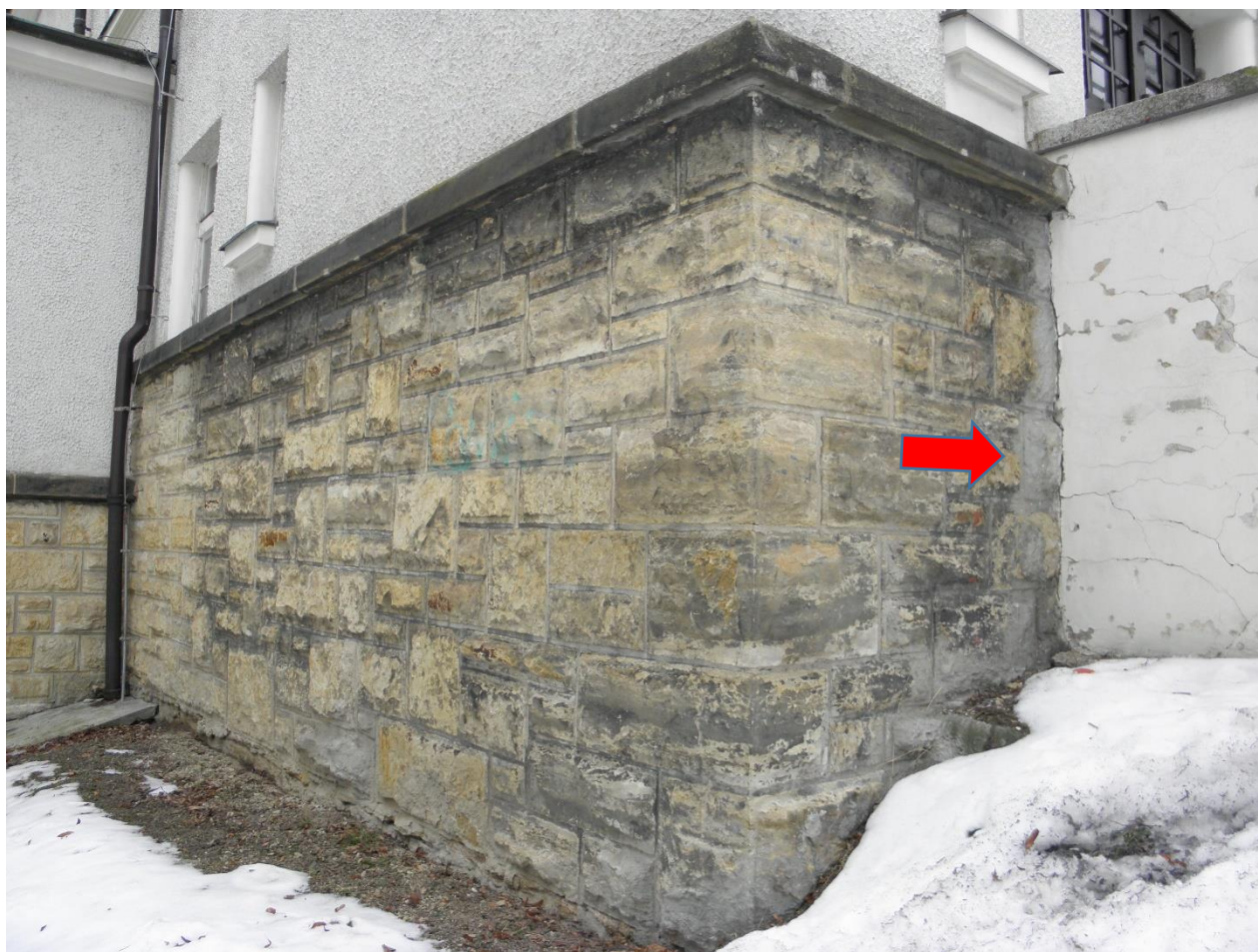
Úsek L – římsa výrazně ztmavlá, na spodní ploše krusty s korodující horninou přecházející na zdivo. To lokálně výrazně ztmavlé, místy vrstevnatá eroze a bílé výkvěty, ➡ povlaky maltovin
