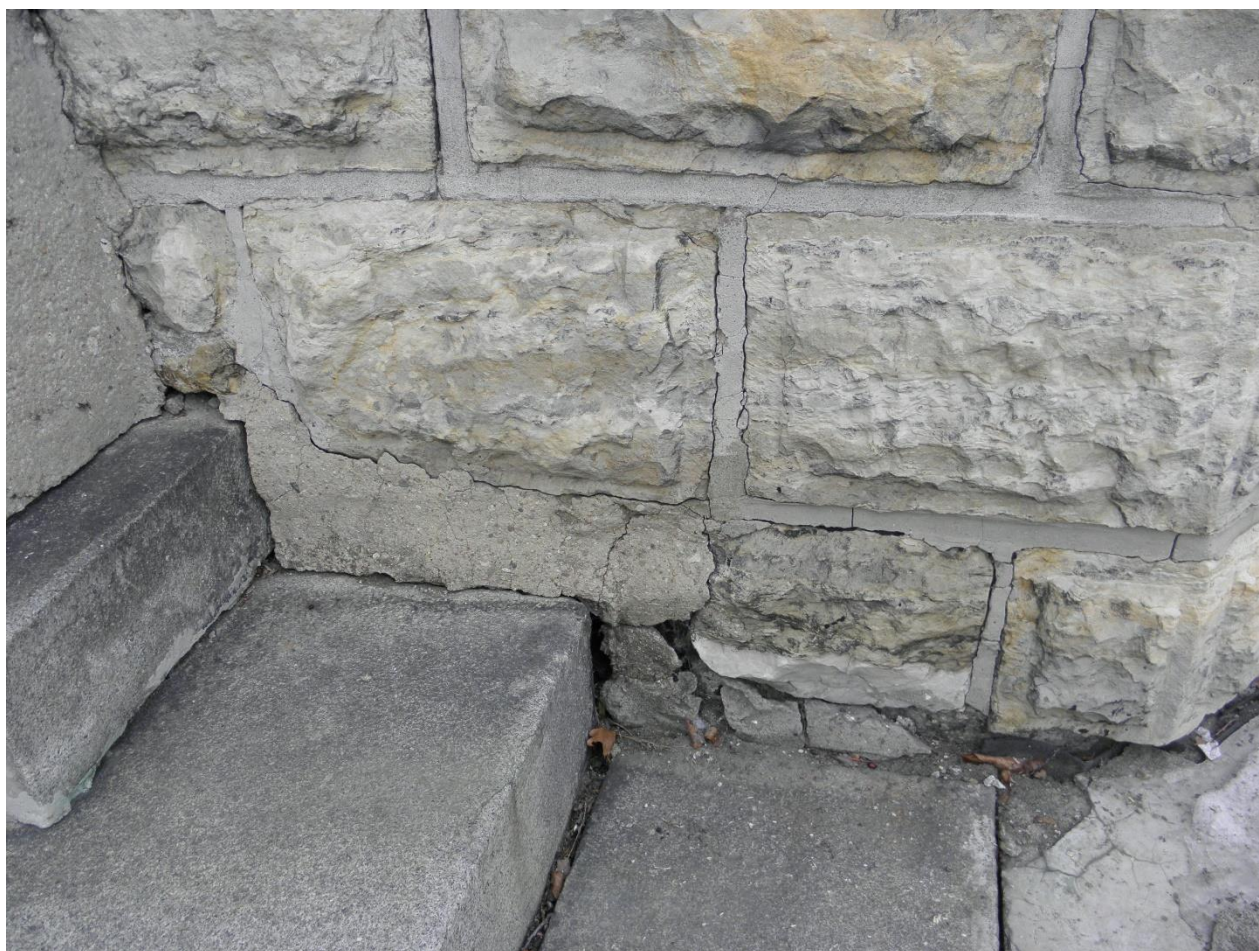
Úsek R - detail soklu u hl. vchodu; mírně se rozestupující zdivo, nevhodné vysprávky; uvolněné spáry schodiště
