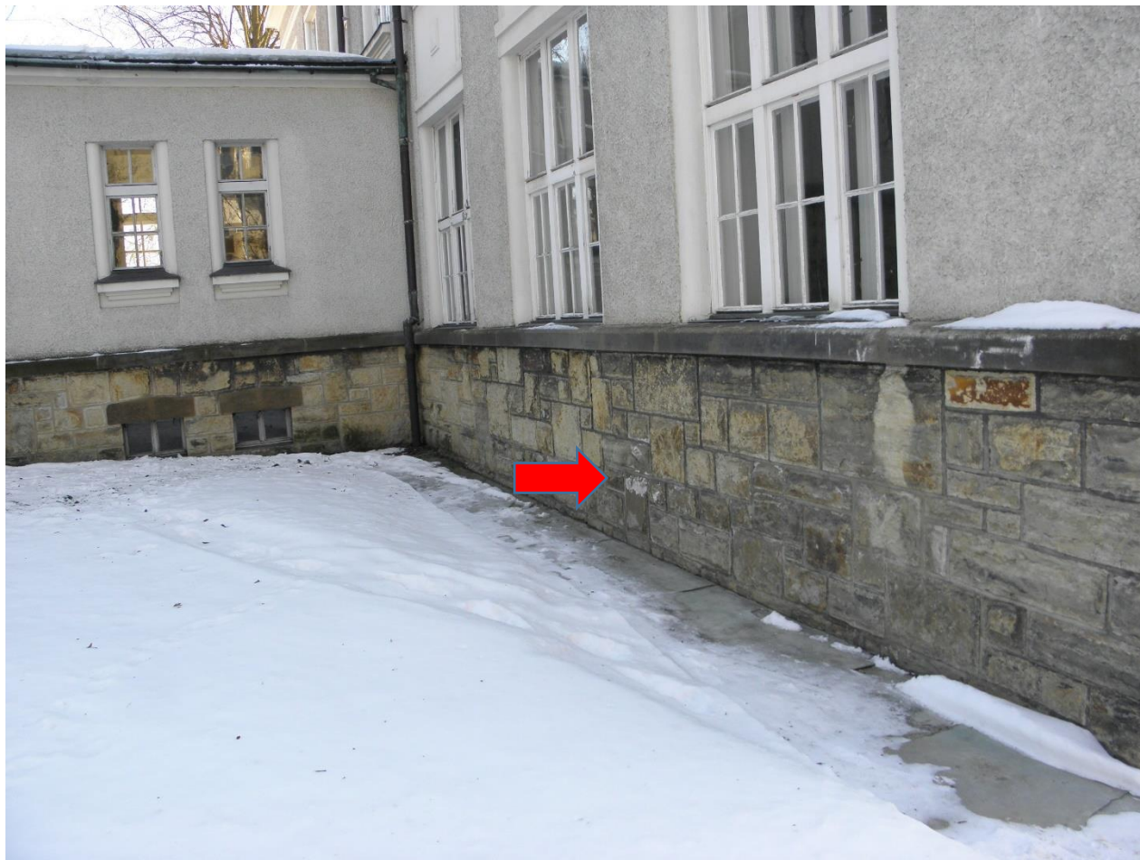
Úsek G – římsa mírně napadená řasou, silně tmavé povlaky, uvolněné spáry; opuka pod římsou výrazně ztmavlá, některé kvádry opuky vrstevnatě erodují, ➡ výrazné bílé výkvěty, viz detail níže
