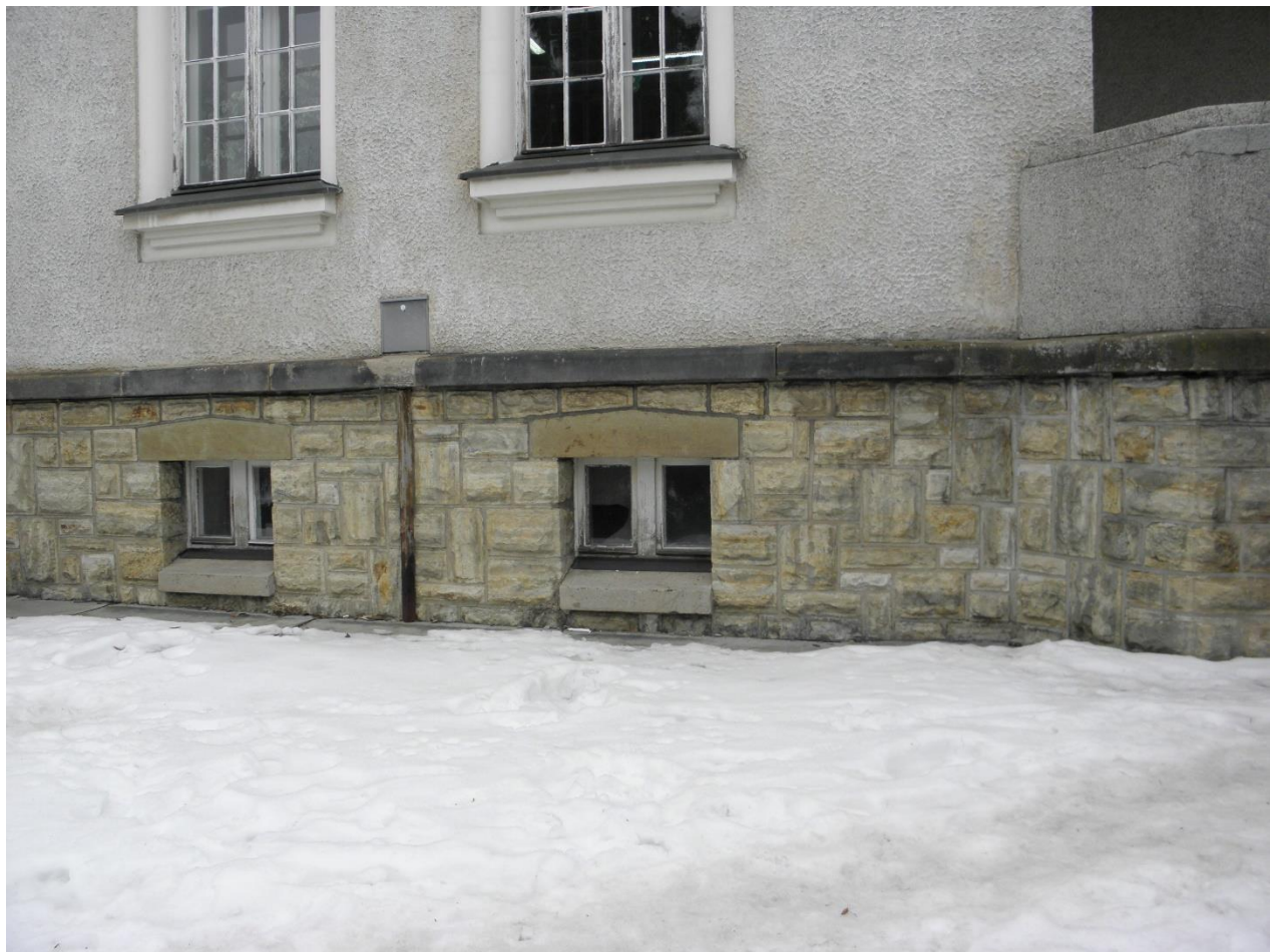
Úsek P – na římsce tmavé depozity, lokálně lišejník s řasou, místy praskliny, nevhodné vysprávkky, eroze s výraznějšími úbytky horniny, uvolněné spáry; opukové zdivo místy erodované, rozestupující se
