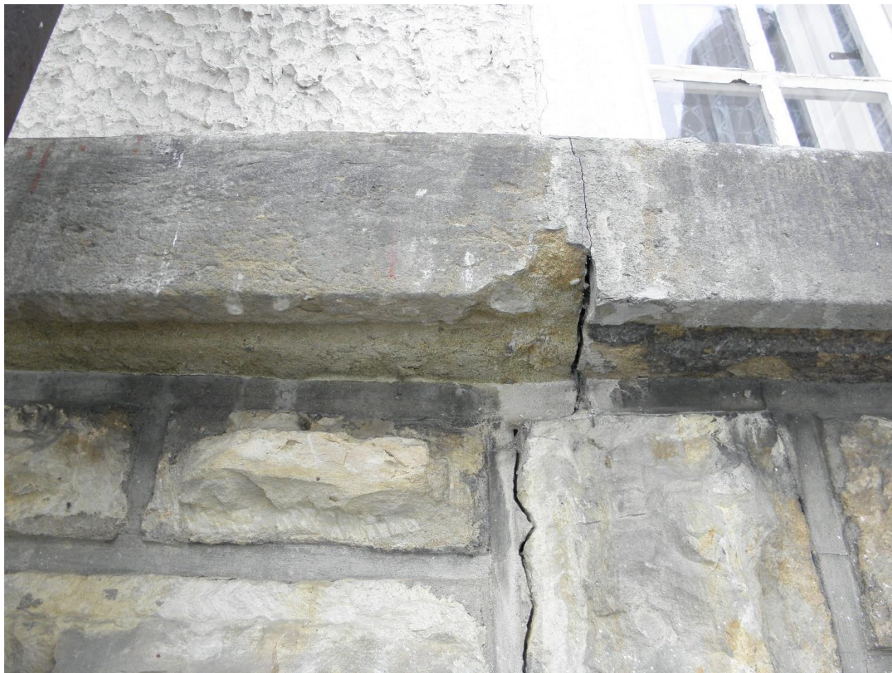
Úsek O – detail obrázku výše, zde tektonická prasklina skrz všechny prvky, uprostřed erodovaný povrch okapnice s výrazným úbytkem horniny, vpravo tmavá křusta
