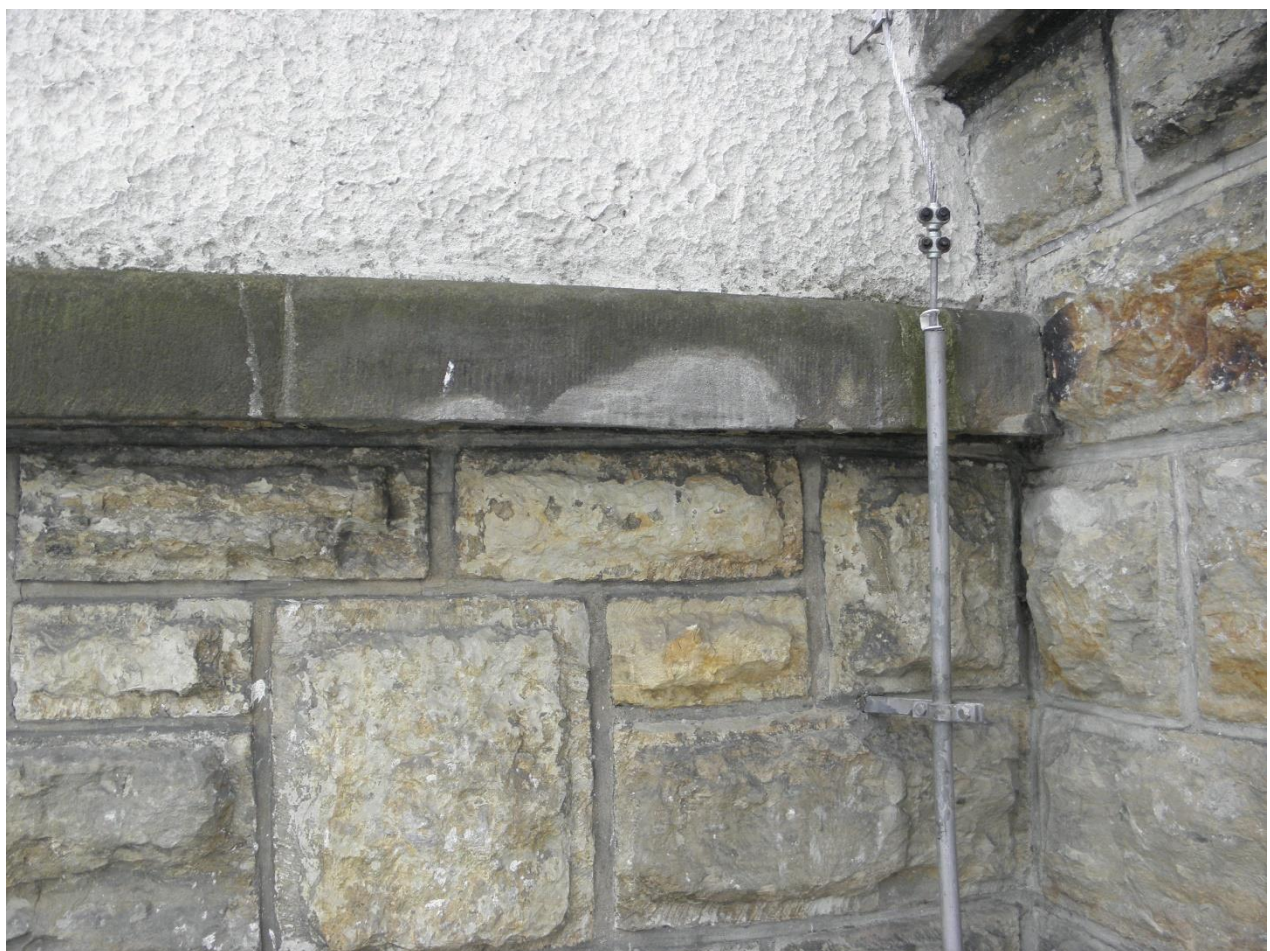
Úsek H – detail obrázku výše, na římse nekvalitní vysprávky
