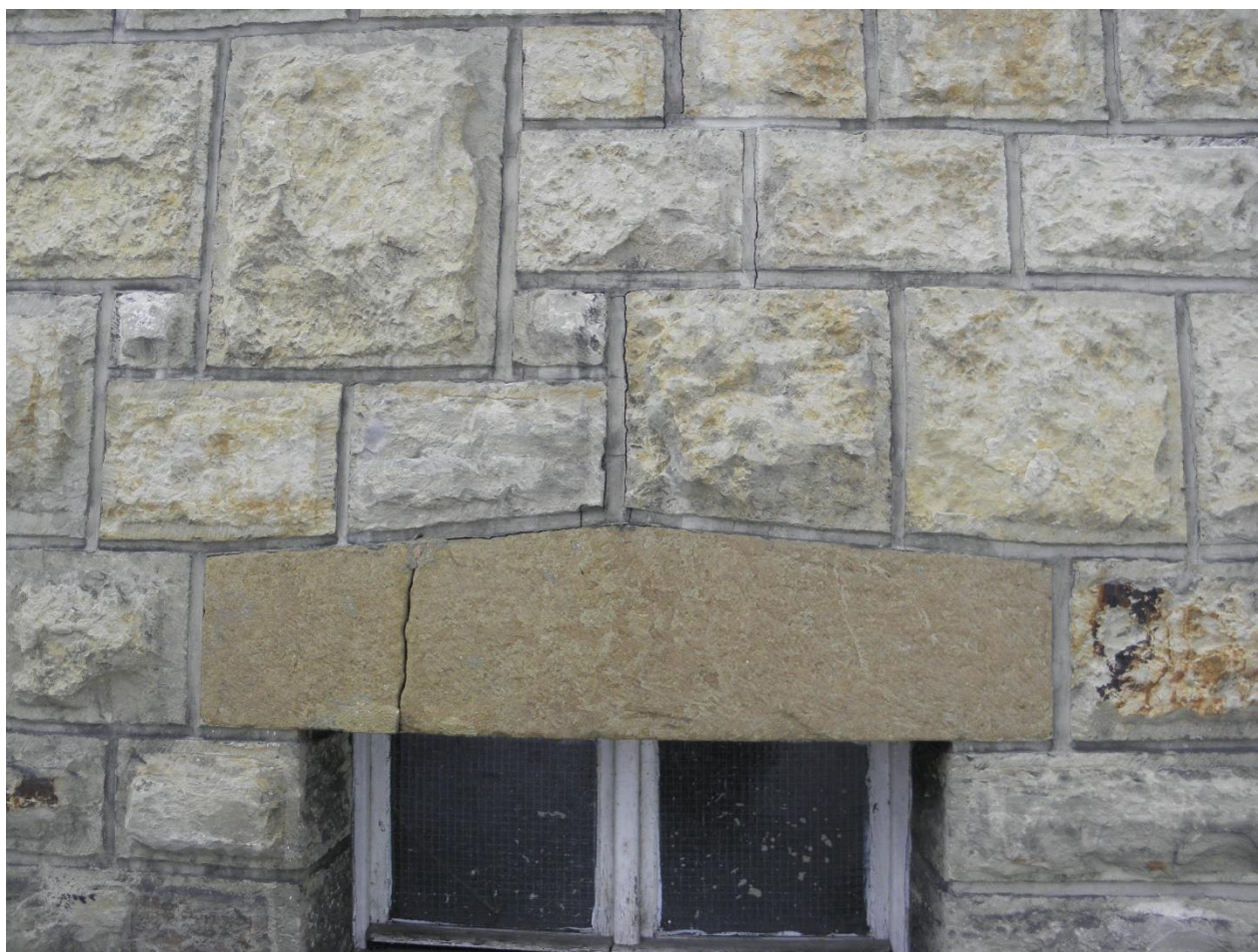
Úsek M – detail obrázku výše, tektonická trhlinka navazující na destrukci ve zdivu
