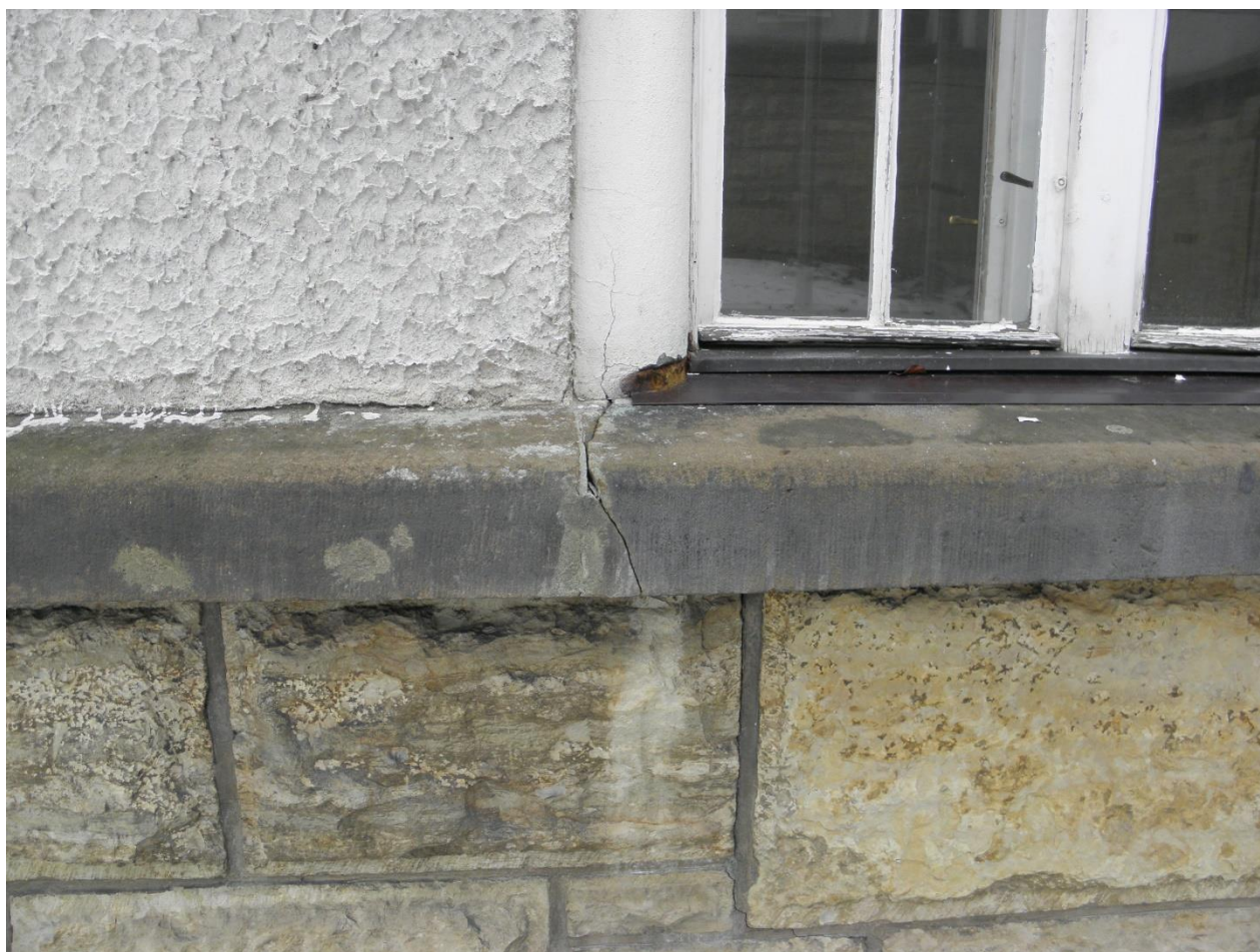
Úsek M – detail římsy na fasádě budovy přiléhající ke spojovacímu krčku, výrazná prasklina, již zatéká do zdi, souvisí s pohyby stavby
