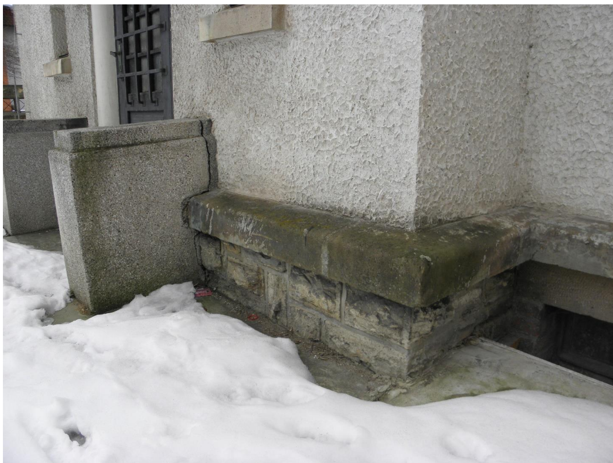
Úsek O – na ploše římsy maltoviny a řasy s lišejníky, nevhodné vysprávkky; opuka znečištěná a ztmavlá; parapetní zeď vchodu uvolněná
