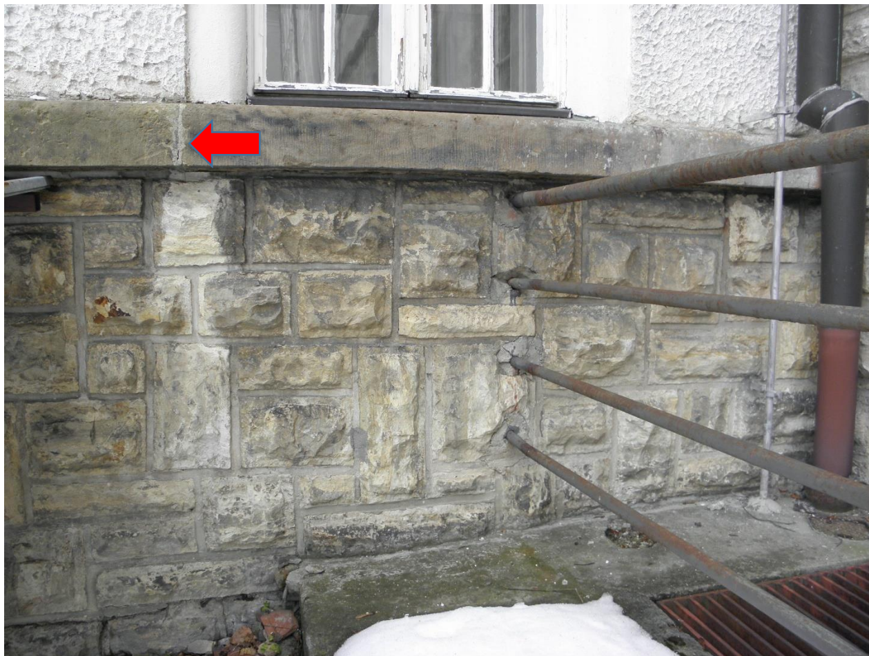
Úsek O – vpravo, ➡ uvolněné spáry jimiž zatéká do zdi, na povrchu opuky tmavé depozity, nevhodně zapravené otvory u trubek zábradlí
