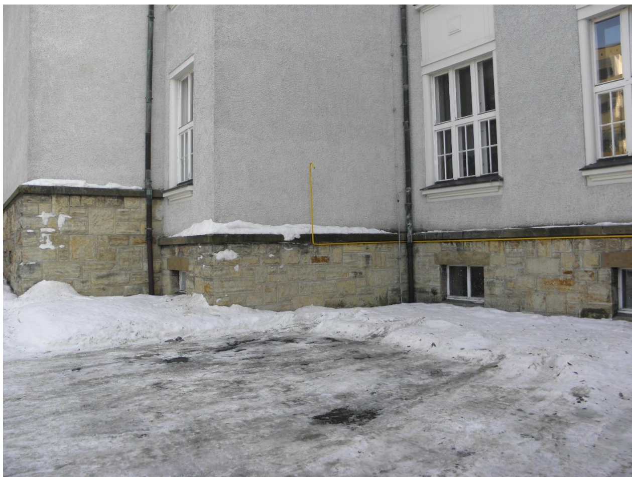
Úsek F - lokálně vrstevnatě erodující opuka zdiva; překlady oken stabilní; římsa znečištěná, nekvalitní vysrávky, uvolněné spáry; lokálně opukové bloky zdiva nahrazeny kompozitními
