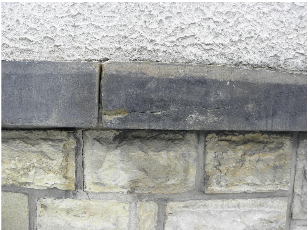
Úsek P – detail obrázku výše vlevo; tektonická trhlina s uvolněnou spárou, římsa prasklá, patrná začínající destrukce
