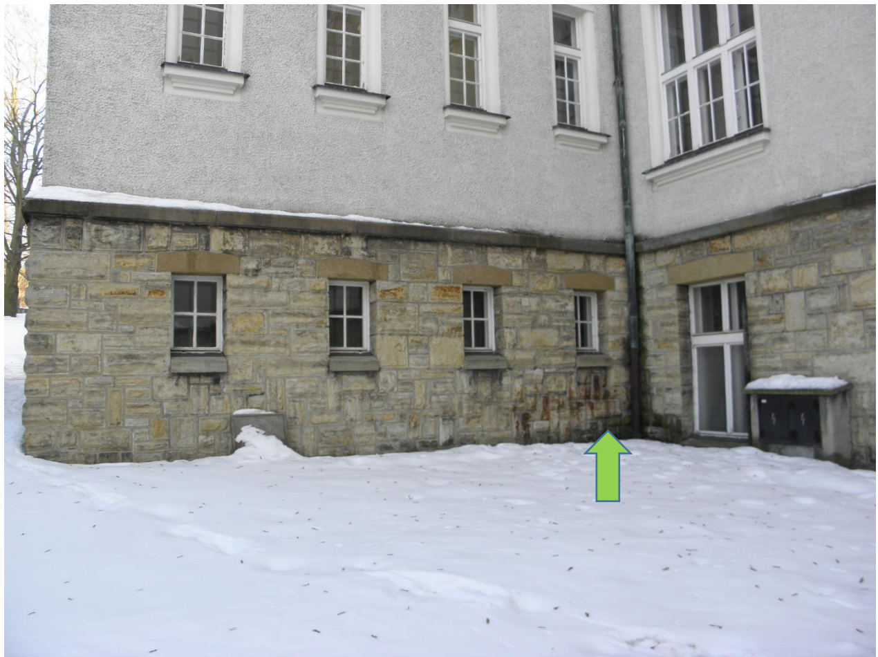
Úsek D - ➡ na opuce zdiva výrazné železité skvrny, roh za okapem zavlhlý, napadený řasou; římsa ve zvýšené míře porostlá biologickým porostem, praskliny, chybějící spáry; praskliny na překladech zacelené
