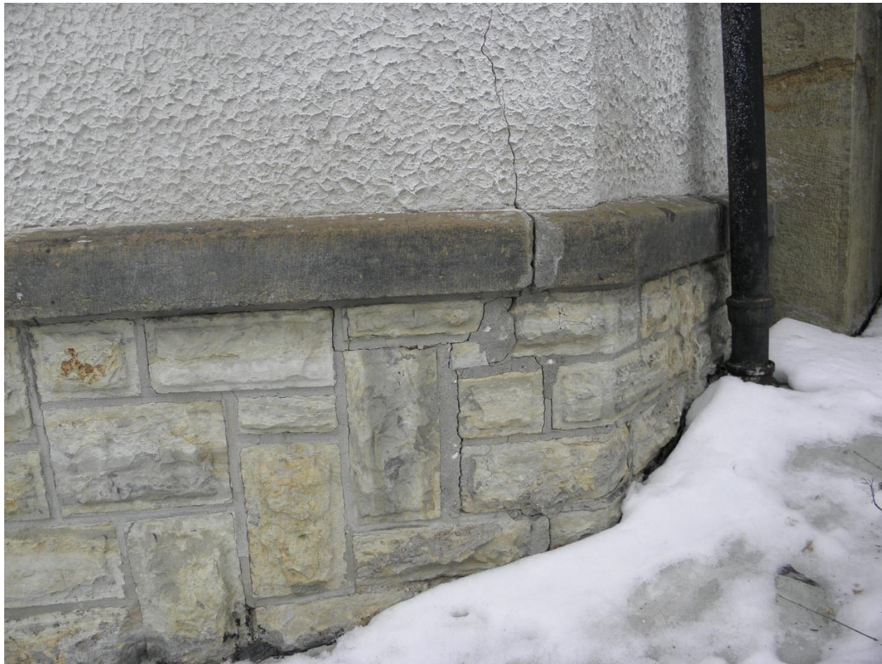
Úsek R – detail soklu u hl. vchodu; mírně se rozestupující zdivo
