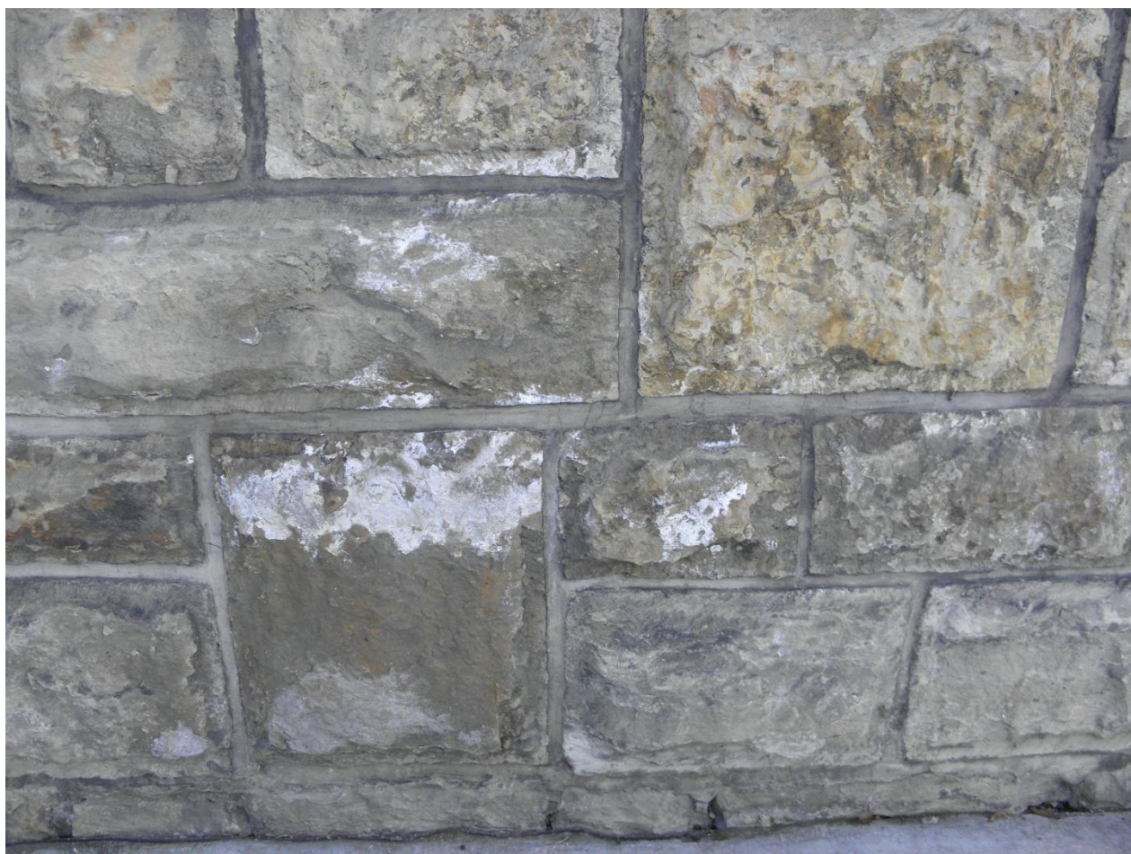
Úsek G – detail zdiva s viditelnými výraznými výkvěty
