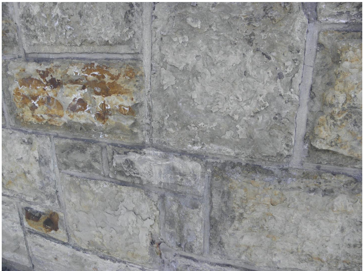
Úsek F – detail zdiva, bílé výkvěty, vrstevnatá eroze
