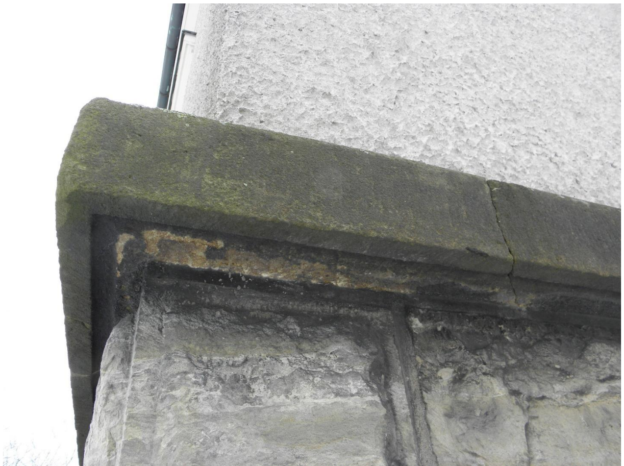
Úsek G – detail nároží tělocvičny, je vidět celoplošné napadení řasou, prasklina v bloku horniny a mechanická poškození, ve srážkovém stínu krusta přecházející na zdivo, přerušovaná erodovanými povrchy
