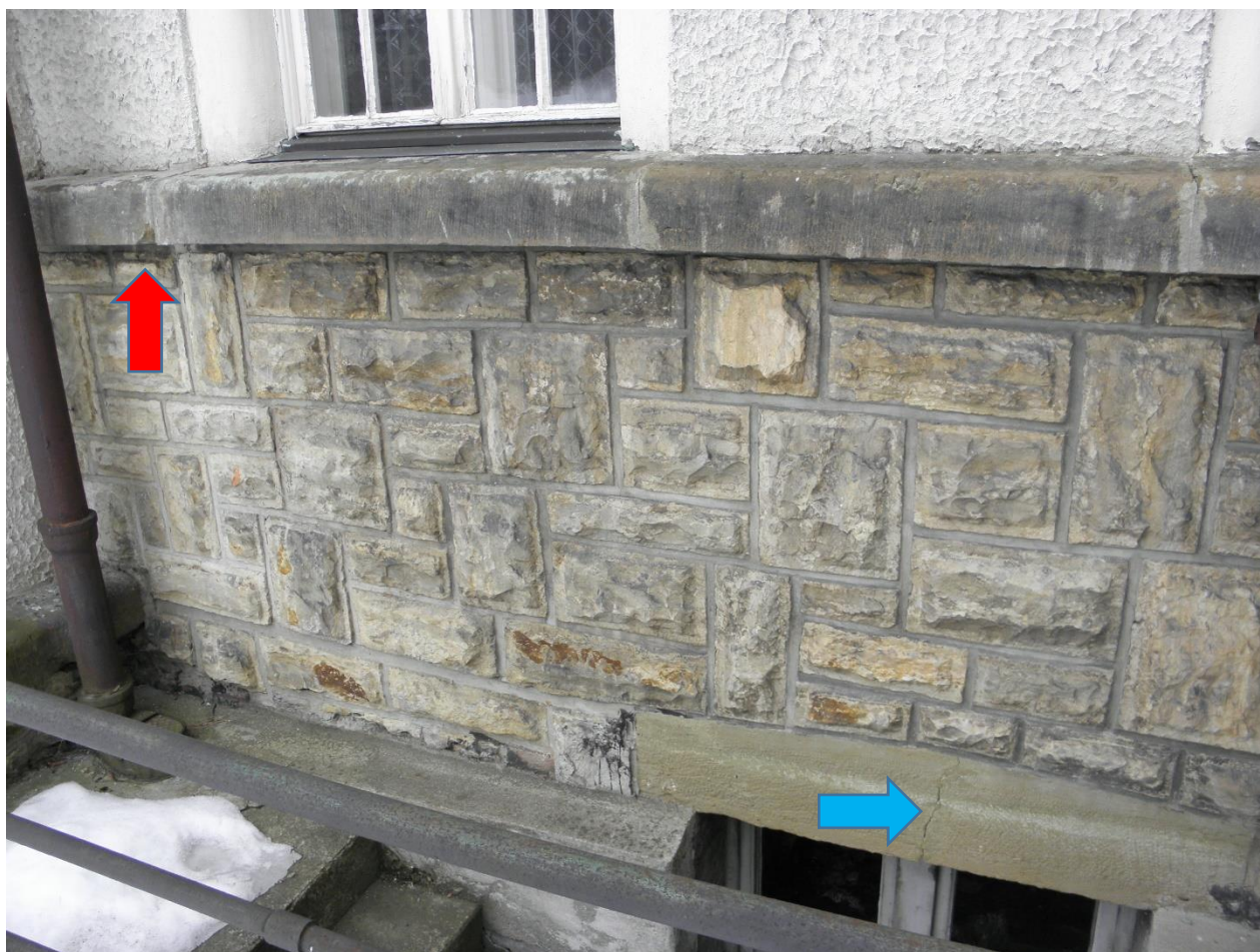
Úsek O - ➡ lokalizace detailu níže, na římsě tmavé depozity, uvolněné spáry, nevhodné vysprávky; praskliny ve spárách zdiva, ➡ překlád okna prasklý
