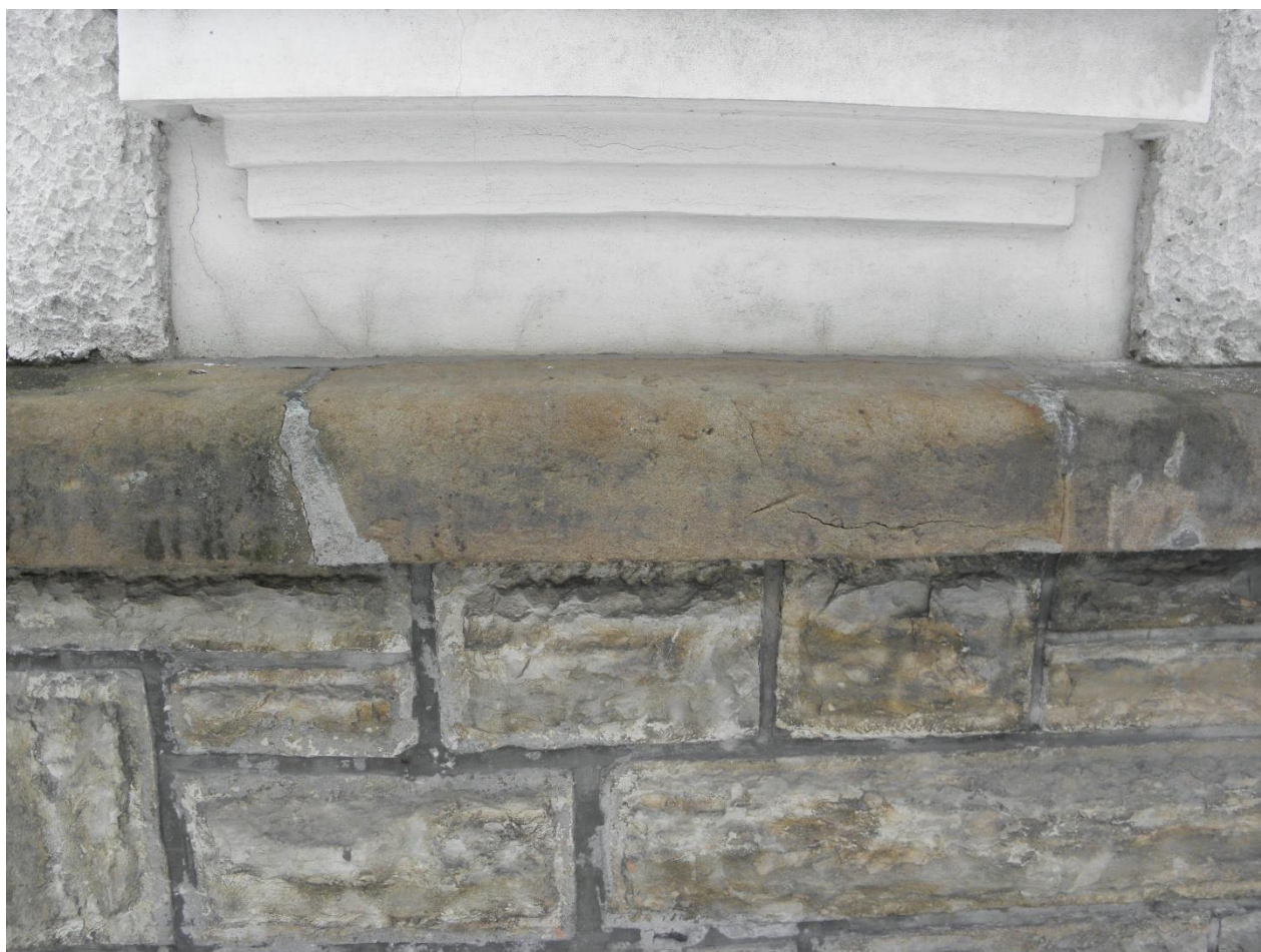
Úsek H – detail obrázku výše, erodovaný a popraskaný povrch římsy, nekvalitní vysprávky tektonických trhlin
