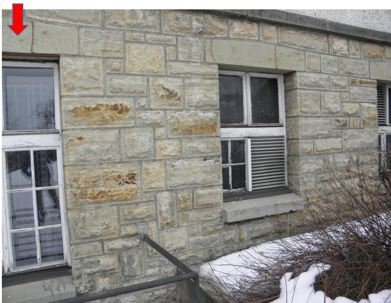
Úsek N – tento úsek není příliš napaden biologickými porosty, suchý; na překladech oken opravené praskliny; na římse uvolněné spáry, ➡ lokalizace detailu níže
