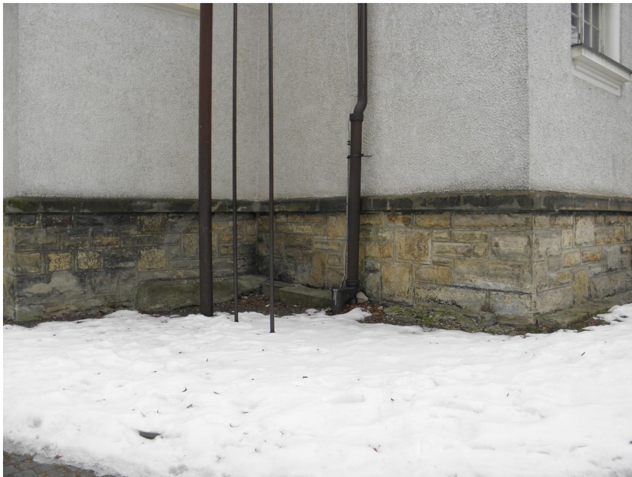
Úsek J - římsa ztmavlá a porostlá řasou a lišejníkem, více nekvalitních vyžilých vysprávek, lokálně tmavé povlaky a krusty, opukové zdivo ve zvýšené míře potřísněné maltovinami
