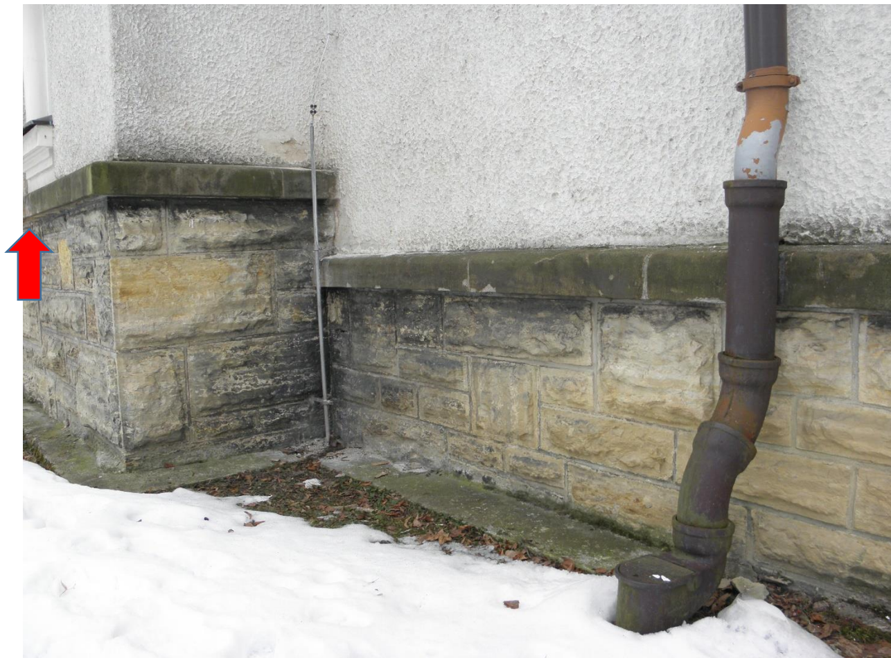
Úsek H – na obrázku jasně patrné tmavé plochy s povlaky v dešťových stínech, ➡ lokalizace detailu níže
