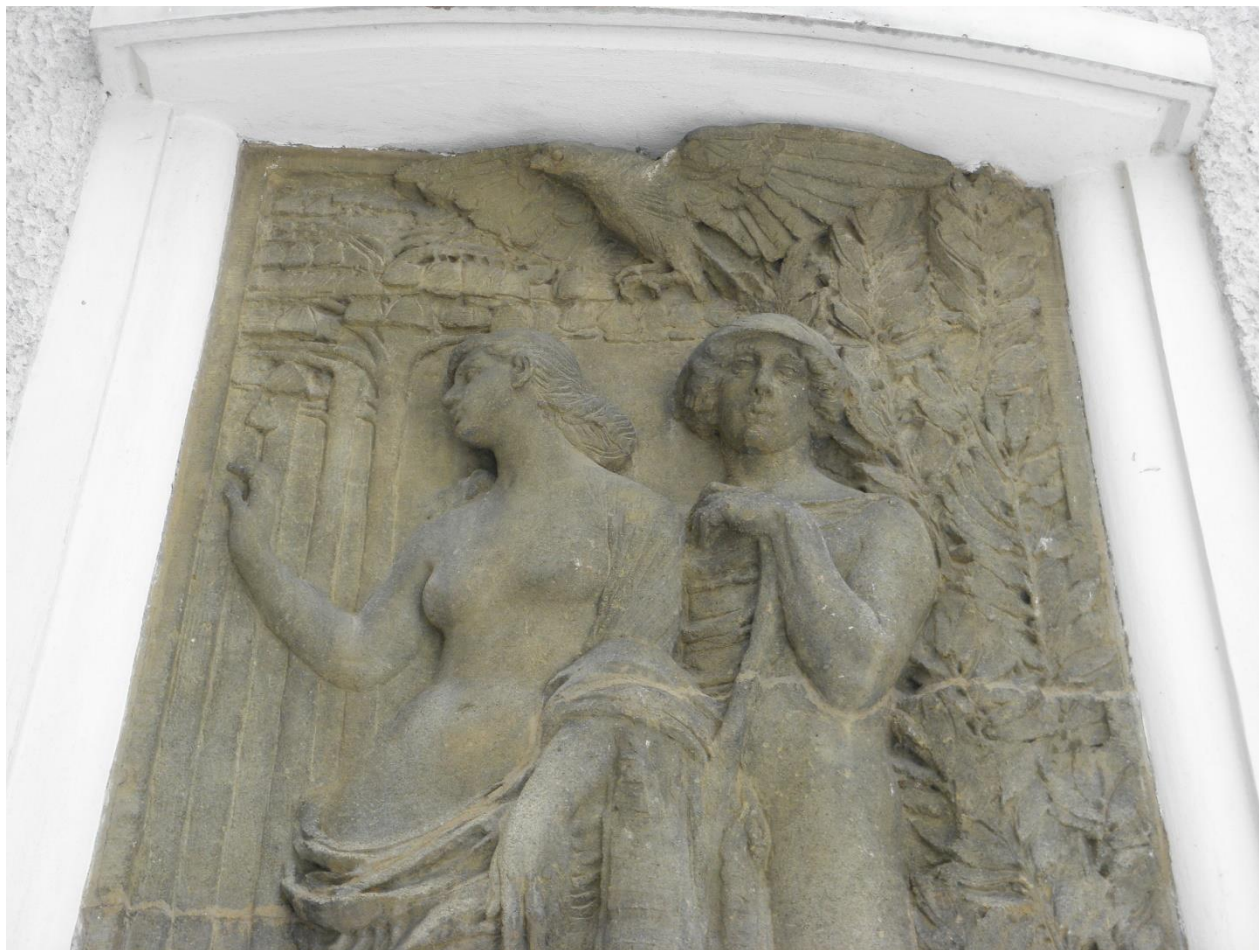
Reliéf na průčelí tělocvičny vpravo – horní část, okrový nátěr je již téměř zaniklý, na exponovaných plochách je erodovaná hladká povrchová vrstva na značné ploše reliéfu již vystupuje struktura plniva
