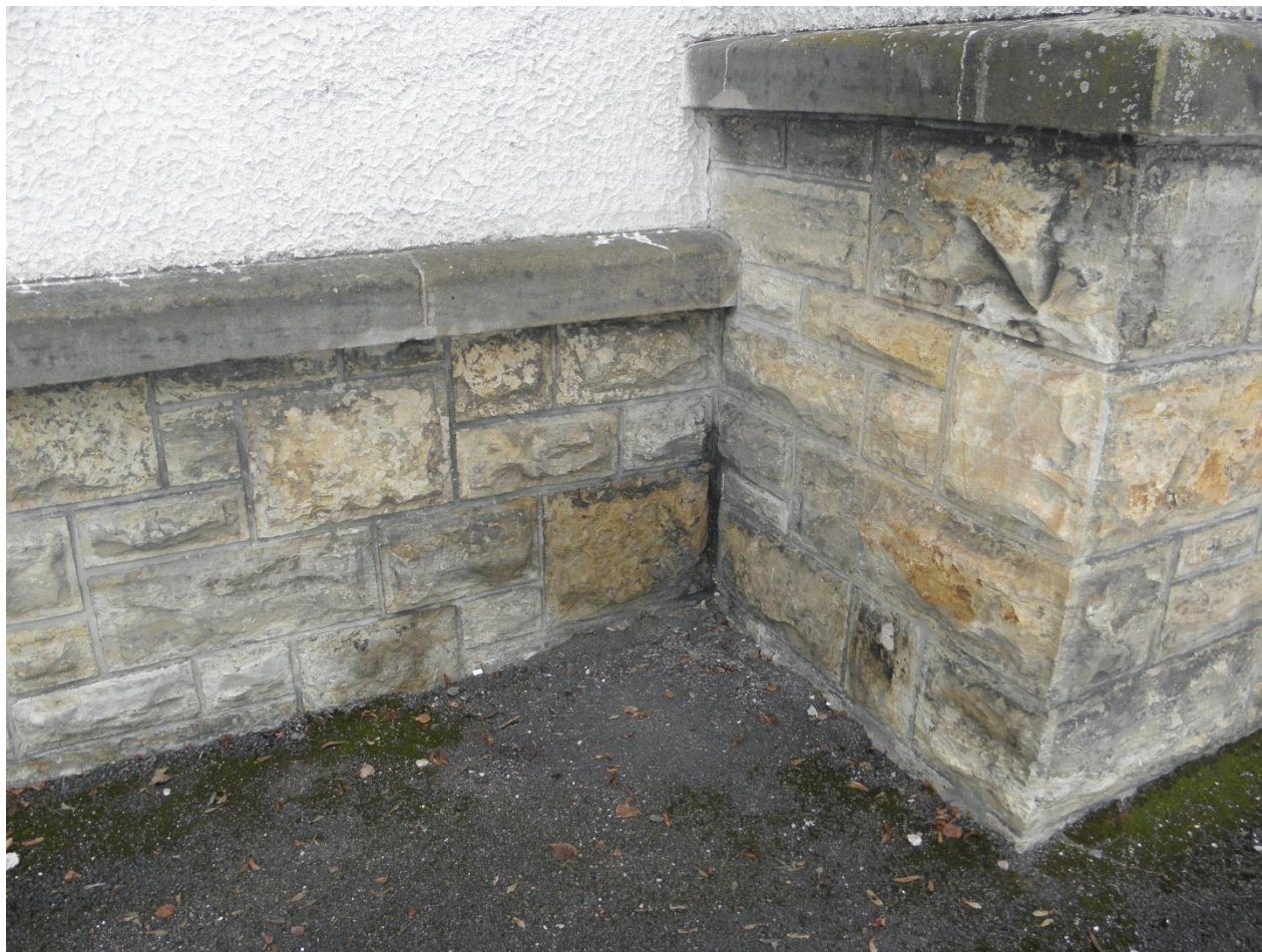
Úsek K – římsa zde v relativně lepším stavu s lokálně se vyskytujícími typickými poškozeními, zdivo v koutě výrazně provlhlé
