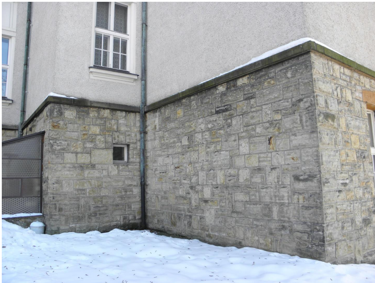
Úsek B - římsa výrazně ztmavlá, výskyt řas snížený, postupující eroze, uvolněné spáry, opuka u země zavlhčená, lokálně výrazněji znečištěná
