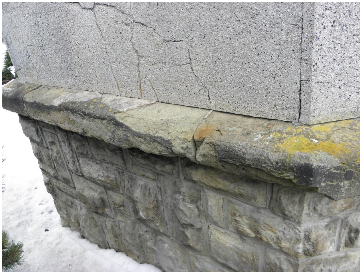
Úsek P – detail balkonu, římsa zde destruovaná kombinací poškození, povrch porostlý lišejníkem; parapetní zeď balkonu se rozpadá, celý blok balkonu se rozestupuje, výrazné praskliny ve zdivu, eroze a výkvěty
