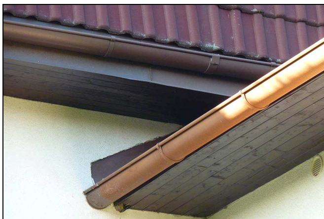
Klempířské prvky a podbití na spojení obou částí budov.
