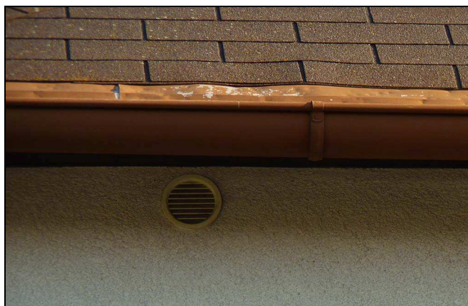
Vvyústění větracích šachet je kryto plas- tovými mřížkami.
