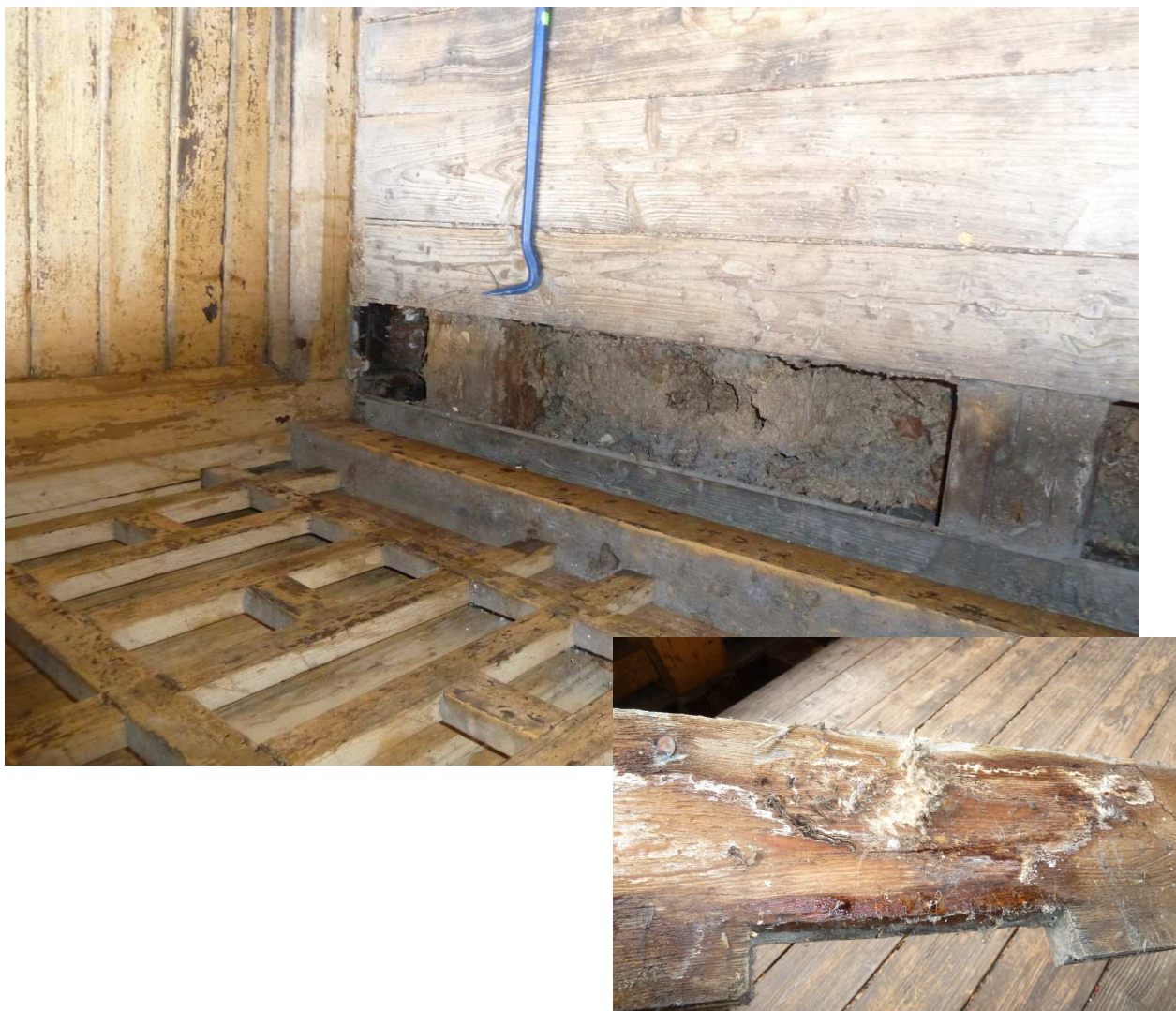
Pozice 6 a 7 – podlaha interiérů leháren - dřevokazný hmyz a povrchové mycelium dřevokazné houby
