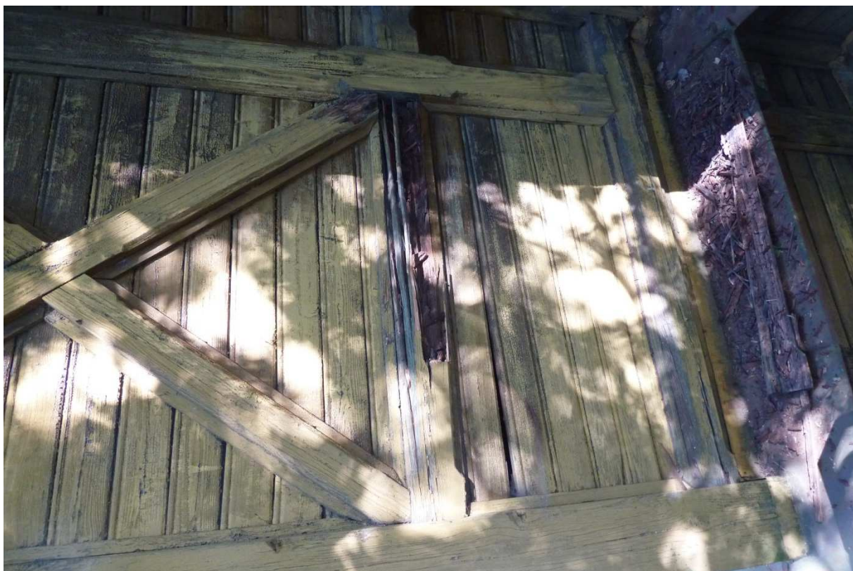
Pozice 8 – hnědou hnilobou napadený vnější sloupek
