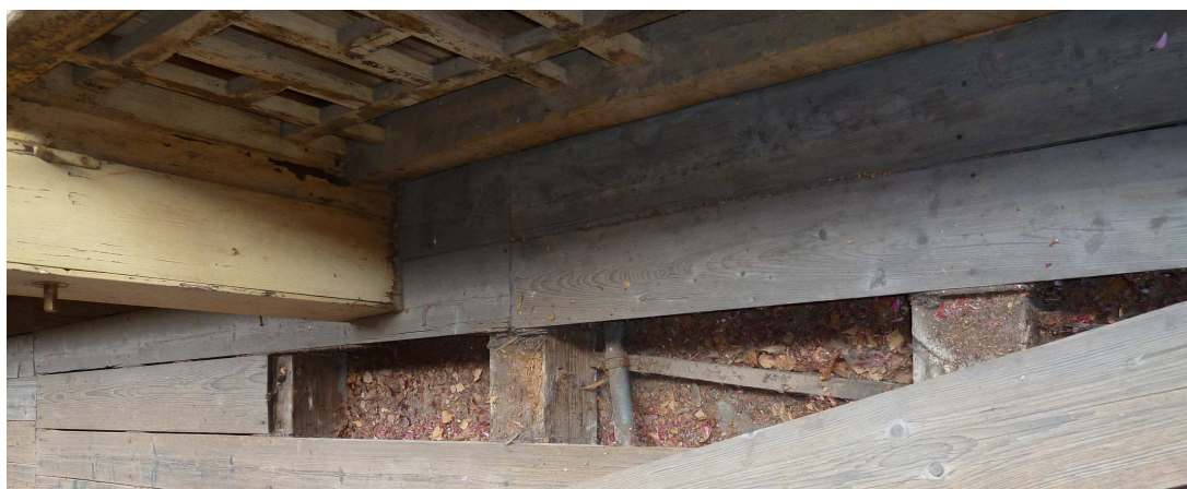
Pozice 3 – dřevokazný hmyz ve stropnici ve věžičky 4.NP
