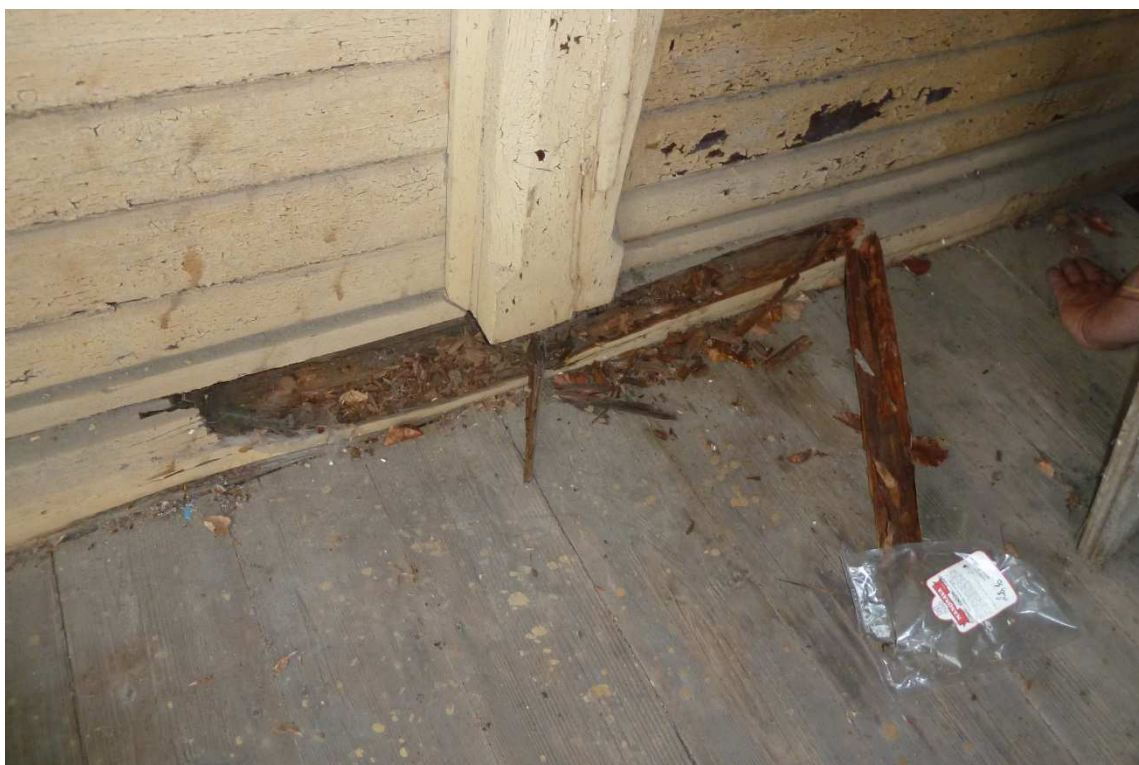
Pozice 5 – Sloupek s podlahovým trámem v interiéru leháren (hnědá hniloba)
