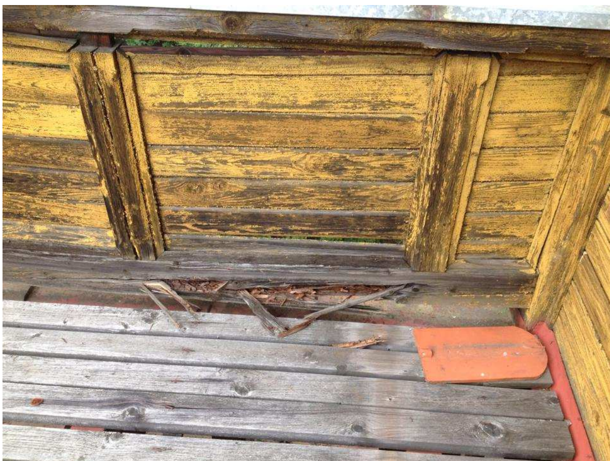
Pozice 1 (viz tabulka 3) – hnědou hnilobou poškozené podlahové trámy terasy 4.NP
