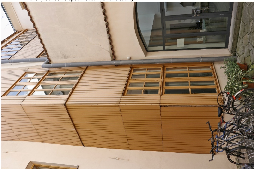
2. Dřevěný obklad na spodní části výtahové šachty
