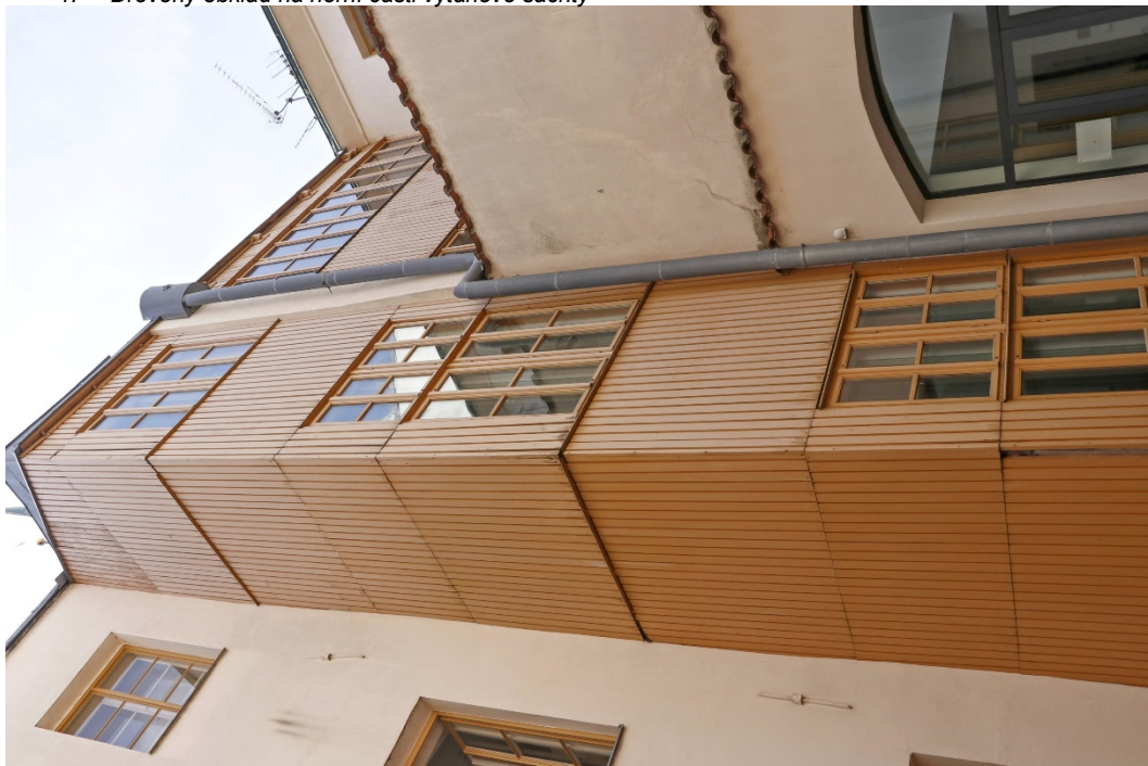
1. Dřevěný obklad na horní části výtahové šachty
