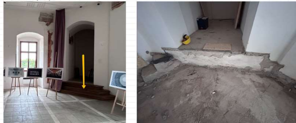
Pol.4 Bourání schodišťových stupňů
