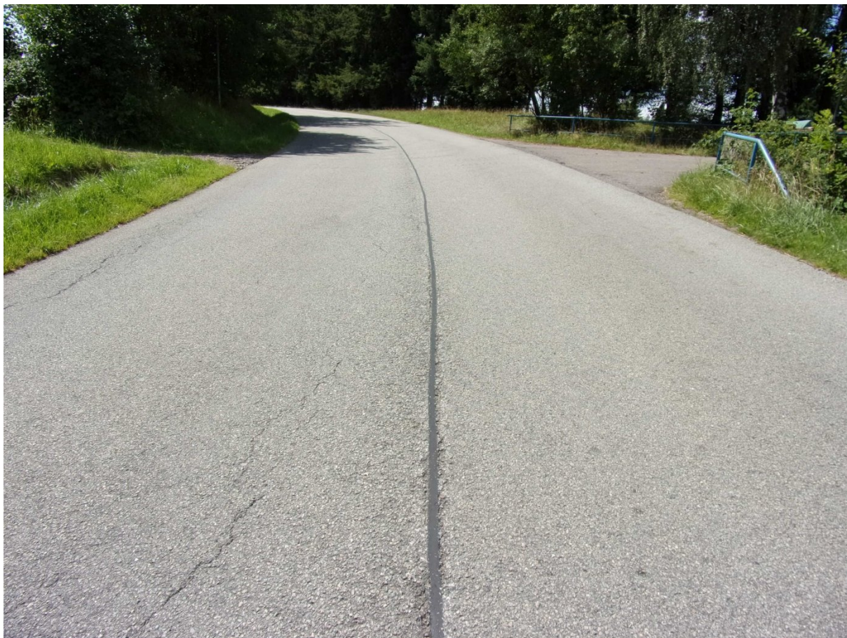
km 48,150+ Podélné rozvětvené trhliny, ztráta asfaltového tmelu, hloubková koroze; intravilán Těchonín.
