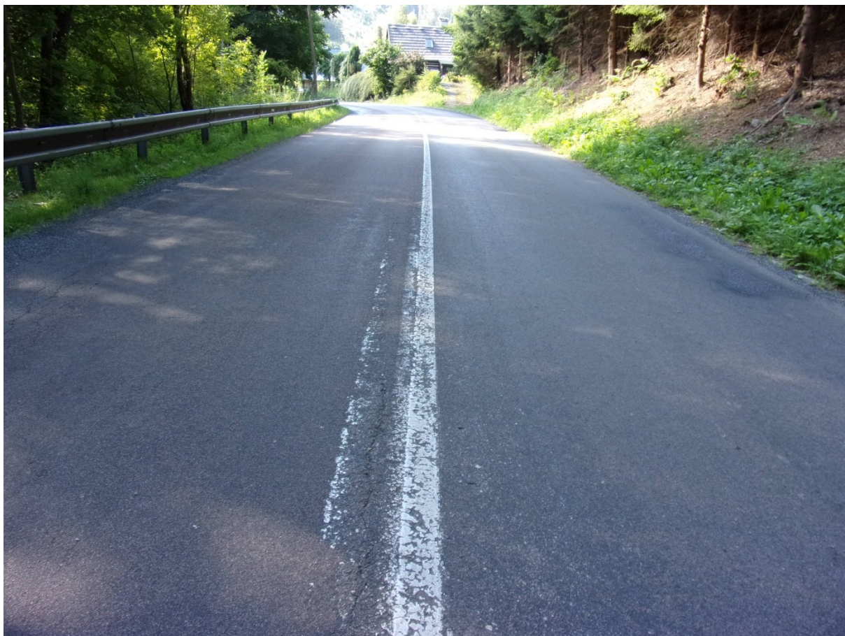
km 46,110+ Podélná trhлина ve středu vozovky, síťové trhliny a vysprávkky tryskovou metodou podél okrajů, zvýšená nezpevněná krajnice, zanesení příkopů.
