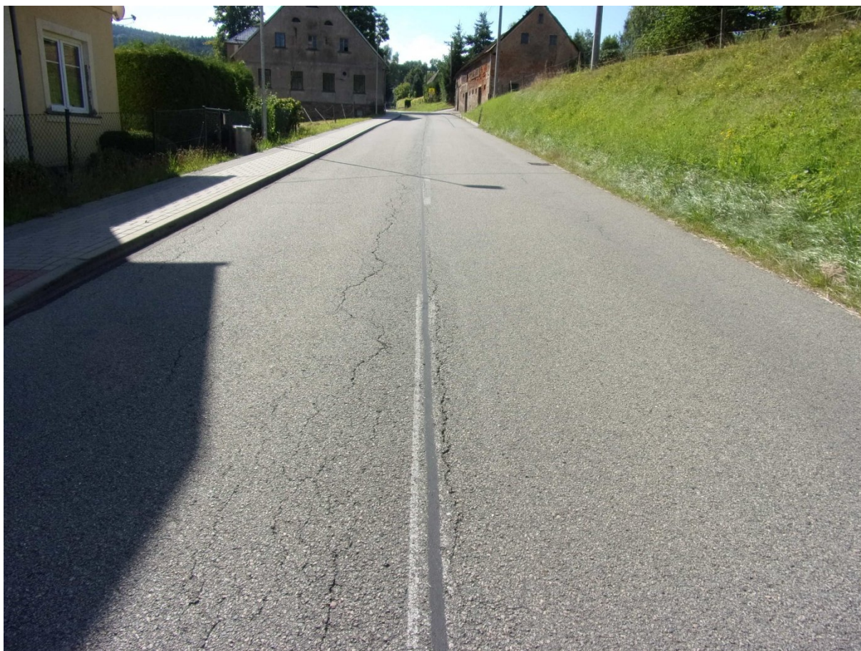
km 47,610+ Mozaikové a podélné rozvětvené trhliny; intravilán Těchonín.
