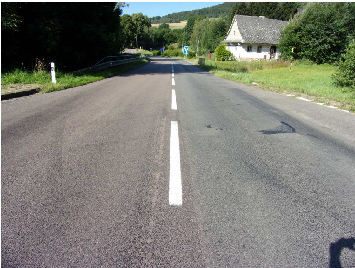
km 45,510+ Ztráta asfaltového tmelu; intravilán Těchonín Celné.
