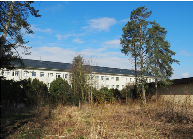
19 - Pohled k budově M
