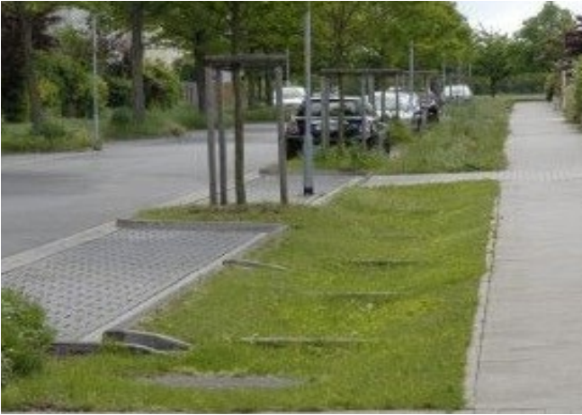
Zatrávněná vsakovací rýha s technickými prvky zpomalujícími proudění vody
