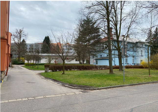
4 - Nástupní plocha do areálu mezi budovami A, B a I
