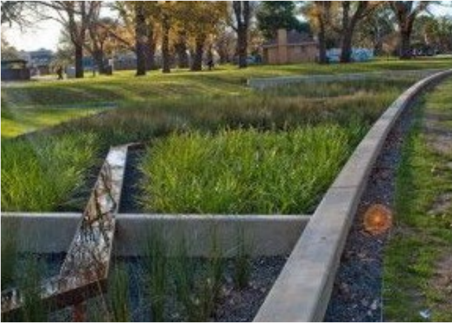
Architektonizované pojetí prvku HDV
