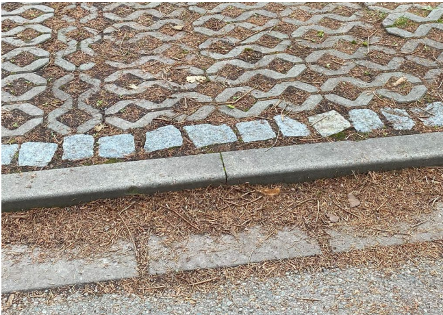
Zatrávňovací dlažba, žulová dlažební kostka, betonová obruba, betonová přídlažba, živičný povrch
