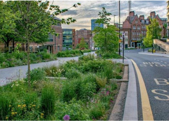
Dešťový záhon, v kterém je voda zasakována, zpomalena, odpařována
