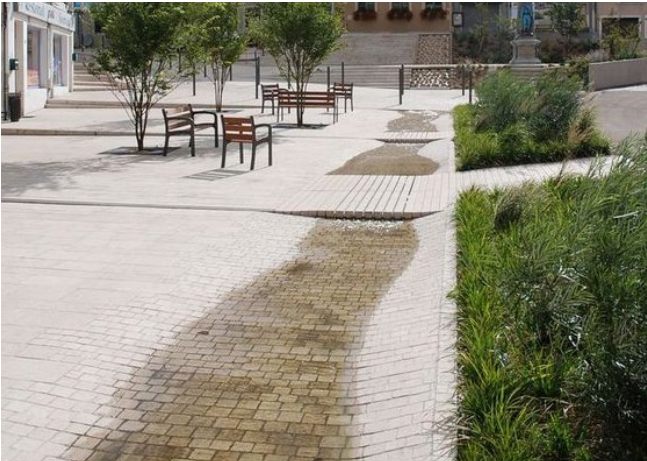
Srážková voda je vedena po zpevněném povrchu, což ztraktivňuje prostor
