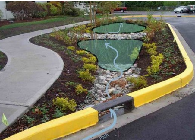
Ilustrativní napojení proipojení komunikace a retenčního/zasakovacího objektu
