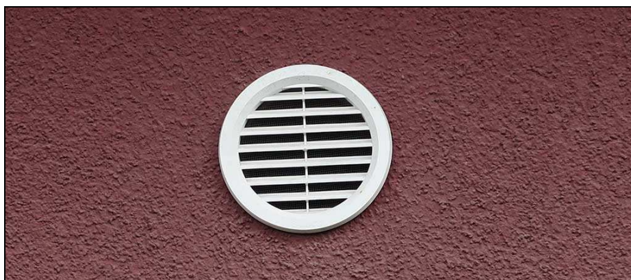
Zakrytí ventilač- ních otvorů plas- tovou mřížkou.
