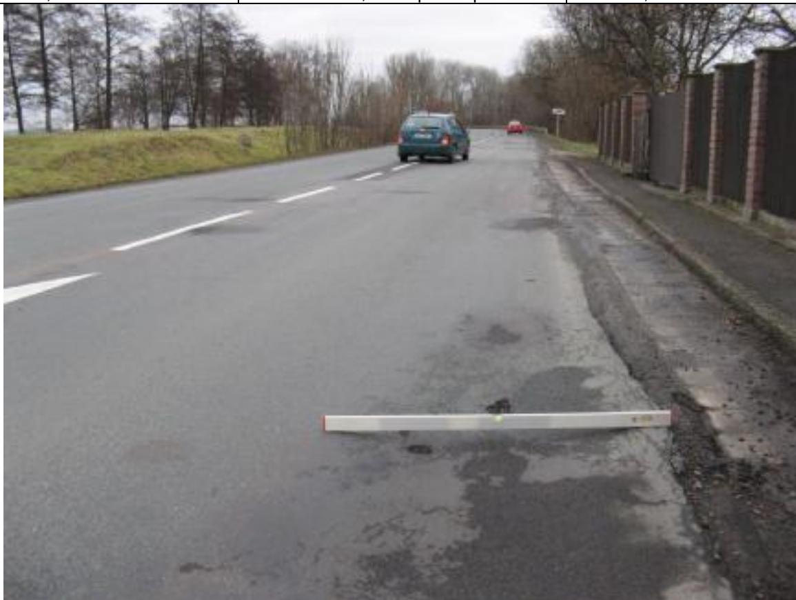
F34, km 34,770 Plošné deformace.
