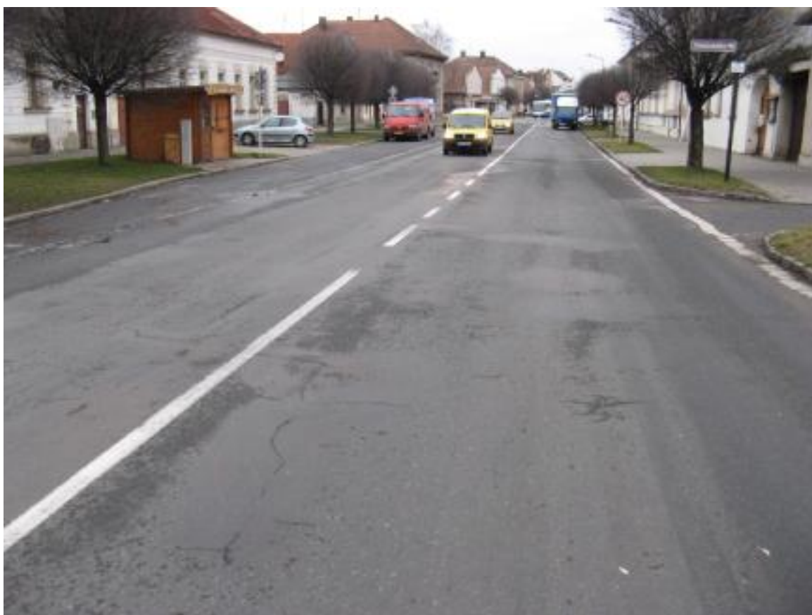
F04, km 34,210 Nepravidelné trhliny, koroze. Velvo odstavný pruh oddělený dlážděným dvojřádkem.
