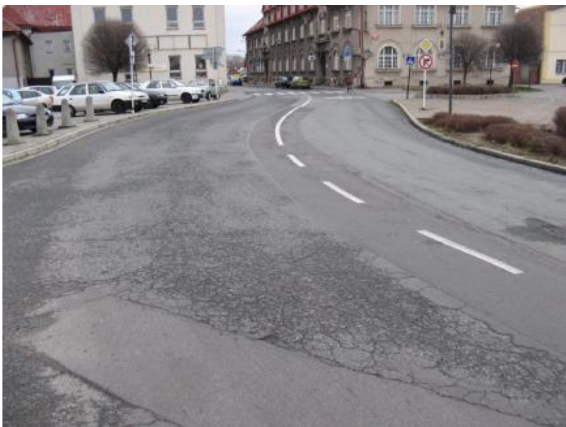
F20, km 34,440 Síťové trhliny, mozaikové trhliny, vysprávkky.
