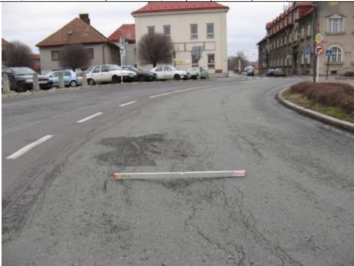
F18, km 34,430 Výrazné plošné deformace a síťové trhliny.
