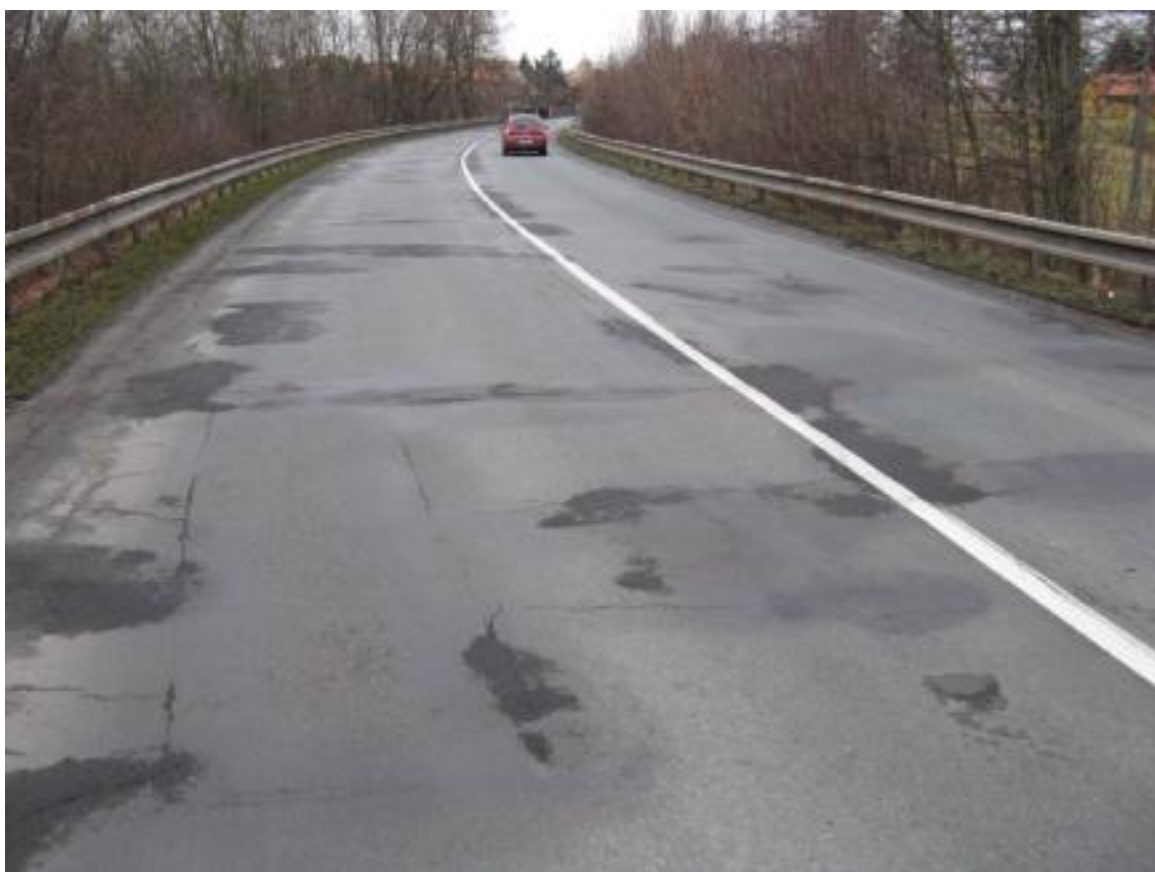
F39, km 35,000 Vysprávkvy, příčné trhliny, nepravidelné trhliny.
