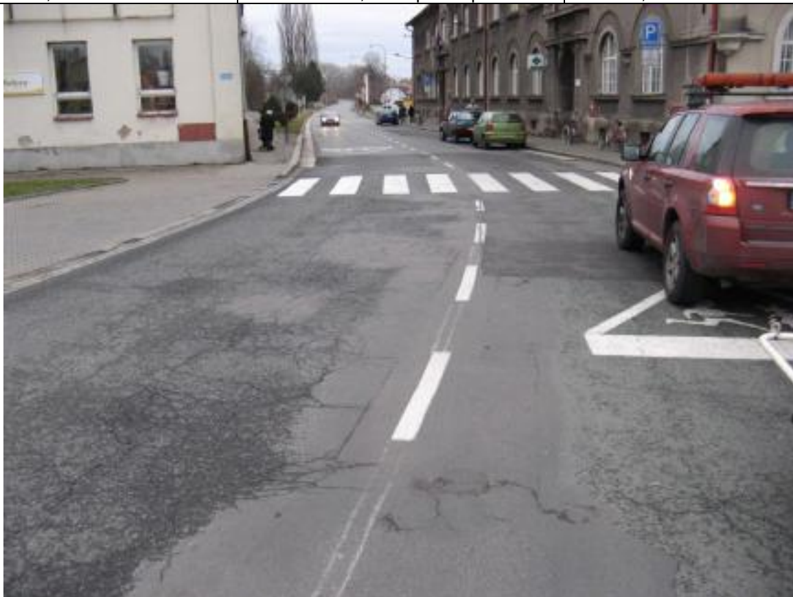
F22, km 34,460 Síťové trhliny, mozaikové trhliny, vysprávk.
