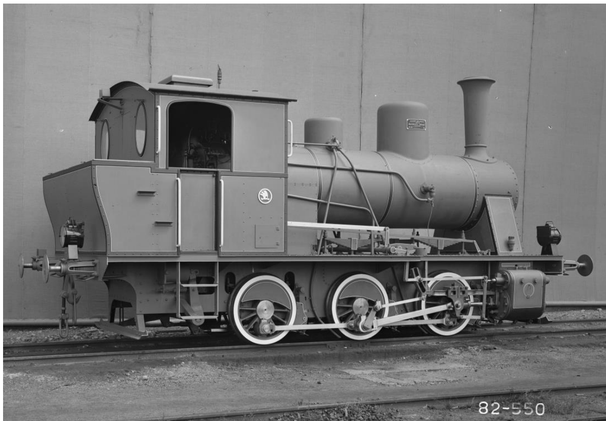
Obr. 2 Tovární snímek druhé vyrobené lokomotivy třínápravového typu Cs10, tov. č. 363/1926. (SOA Plzeň-jih, fond Škodovy závody)
