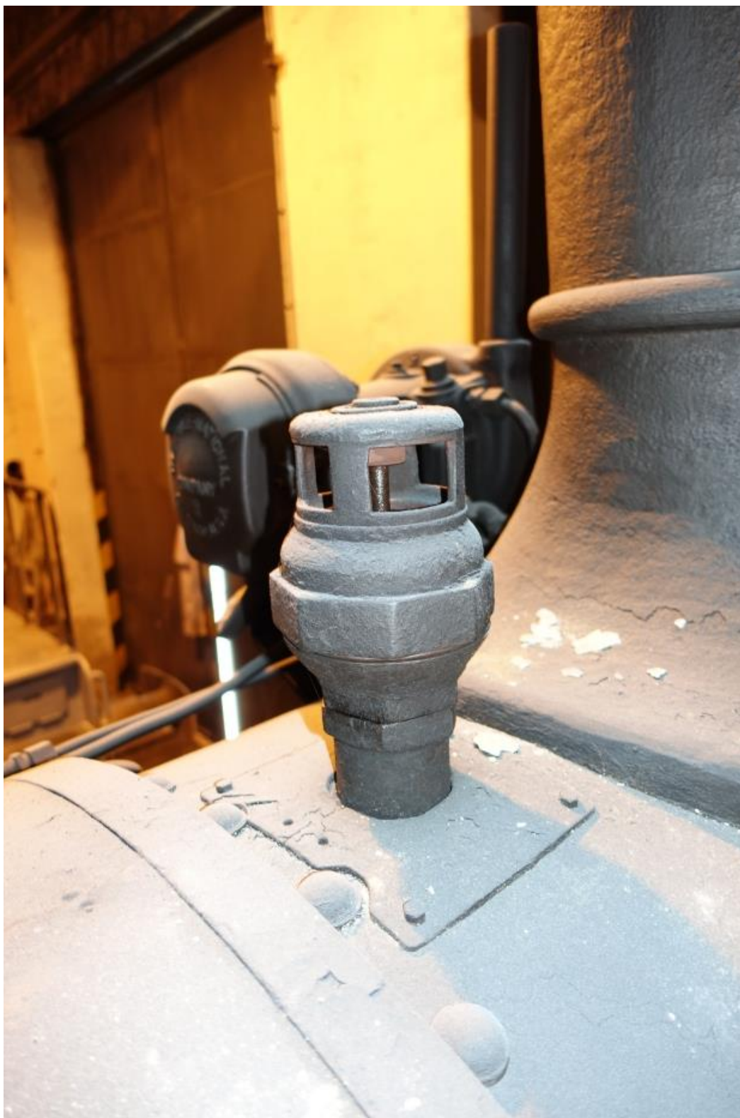
Obr. 7.3. - 9 Nasávací záklopka přehříváče na temenu dýmnice se vyčistí a zkontroluje se její bezvadná funkce (těsnost kuželky).
