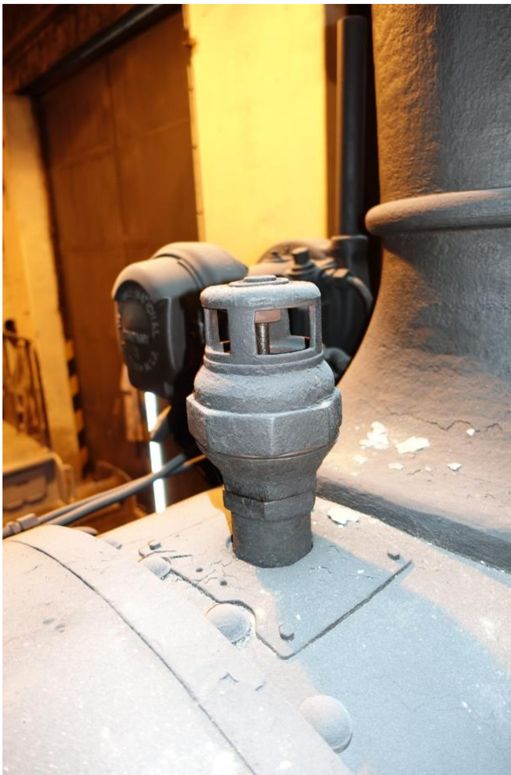
Obr. 7.3. - 9 Nasávací záklopka přehřívače na temenu dýmnice se vyčistí a zkontroluje se její bezvadná funkce (těsnost kuželky).
