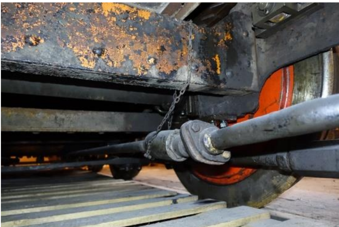
Obr. 7.3. - 16 Pod rámem vedou vodní potrubí k nyní již odmontovaným nesacím injektorům. Obě trubky se odstraní a příruby na dně vodojemu se zaslepí.
