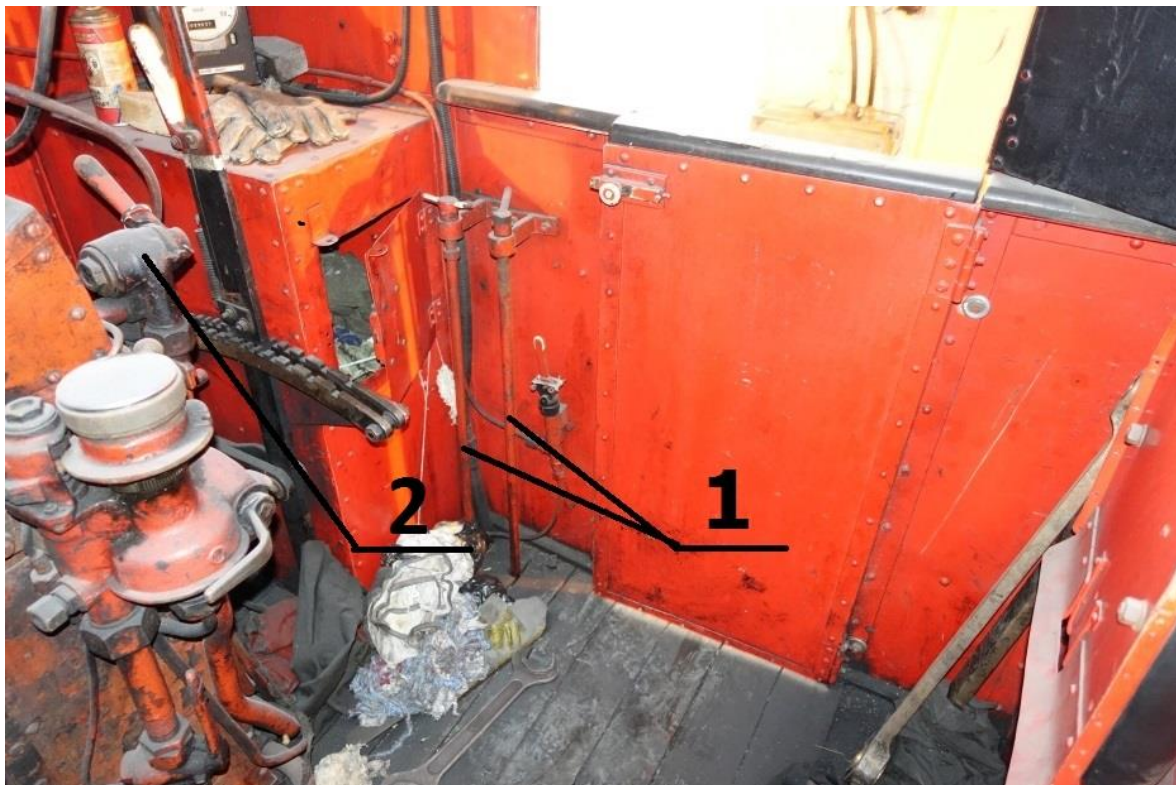
Obr. 7.3. - 41 Po demontáži ovládacích vřeten (1) zbylých po pravém napaječi se na boku budky uvolní místo pro přemístění kohoutu přidavné brzdy (2).
