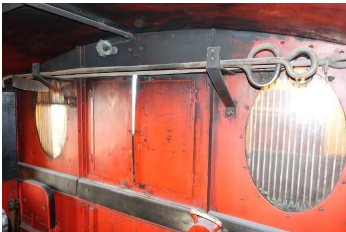
Obr. 7.3. - 38 Hlavním problémem plexisklových výplní zadních oken je špatná průhlednost, a proto se nahradí bezpečnostním sklem. Mřížové ochrany oken musejí být zachovány. S ohledem na potřebu udržovat okna z vnější strany čistá, doporučuji mřížky řešit jako odklopné.
