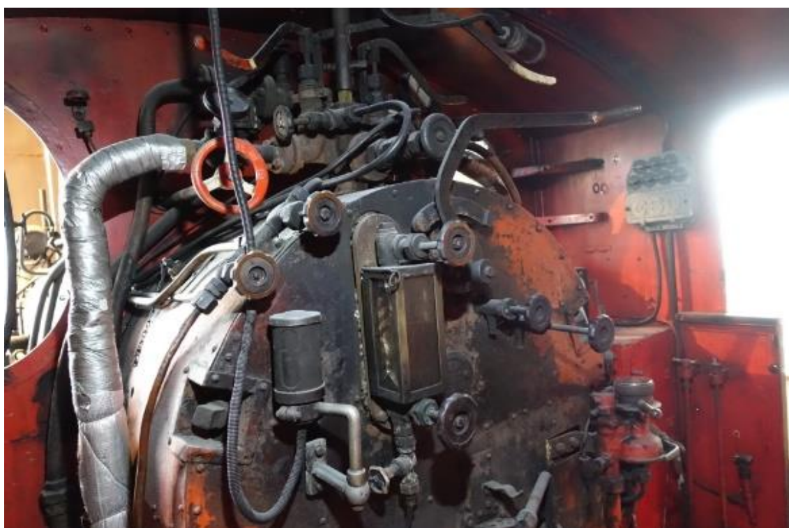
Obr. 7.3. - 12 Vodoznak se opraví a doplní novým profukovacím ventilem. K prubírům se vyrobí společný sběrný žlab. Páče regulátoru bude dán kultivovaný tvar a její hřídel se upraví tak, aby páka byla správně vedena svým segmentem (nyní mimo dorazy).
