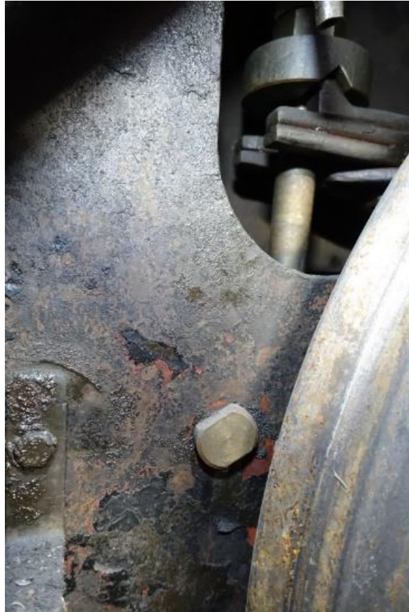
Obr. 7.3. - 23 Detail upevnění kozlíku z předchozího snímku na vnější straně rámu lokomotivy. Šroub není lícovaný a jeho hlava není pojištěna proti pootočení.
