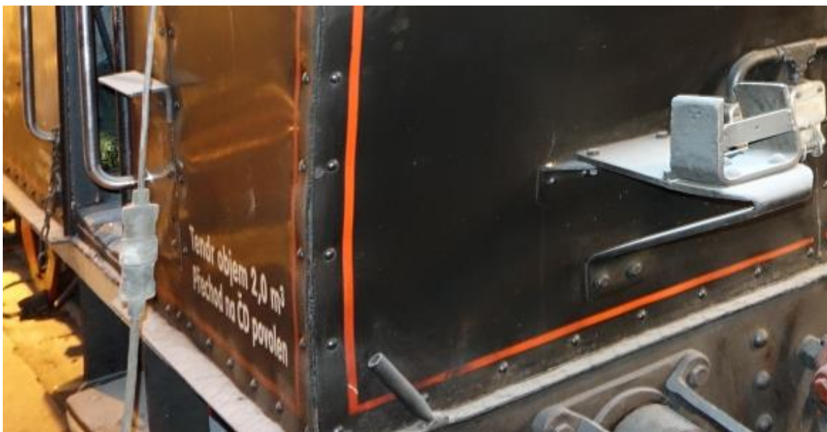
Obr. 7.3. - 34 Kromě výše zmíněného držáky vlaječky je na snímku dobře vidět i zvlnění nýtového spoje na hraně uhláku v důsledku bobtnání korozních produktů mezi plechem a spojovacím úhelníkem.
