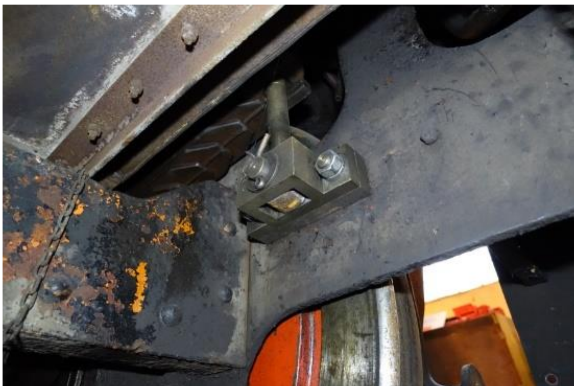
Obr. 7.3. - 22 Nově vyrobené kozlíky závěsek u nápravy S 2 bude třeba zkontrolovat a zajistit tak, aby se nemohla opakovat situace, která v roce 2011 vedla k vážné nehodě lokomotivy.
