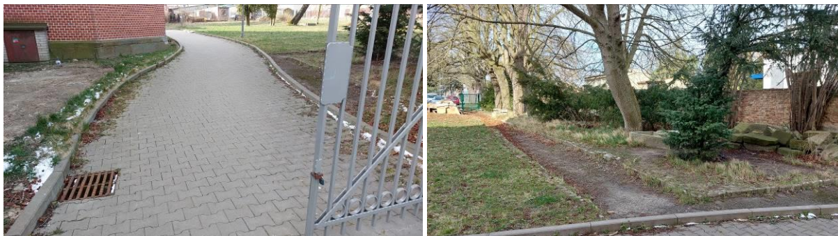
Stávající příjezdová komunikace pro hasiče se zámkovou betonovou dlažbou / Zbytky původního chodníku
