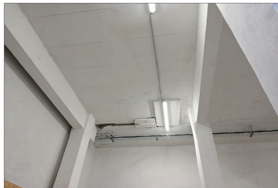
Detail stropu ve střední části se zachovaným vstupem technologie
