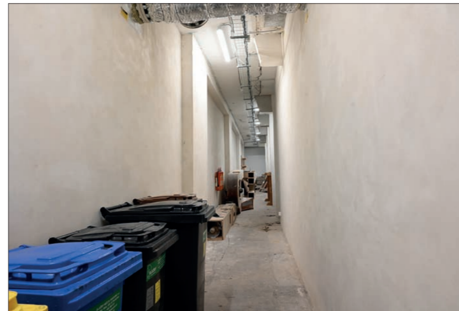
Pohled na koridor vymezený nově vloženou zdí prostoru tobogánového skladu
