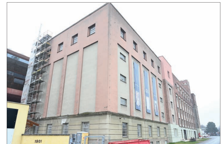
Celkový pohled na část moučného síla od severozápadu
