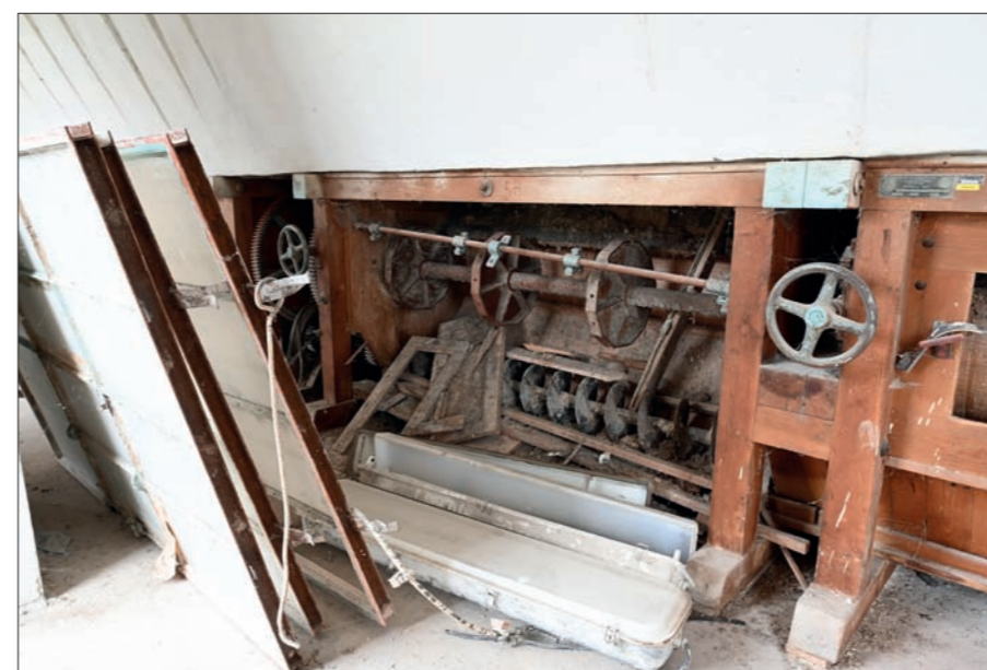
Detail odkryté, demontované části výsypky
