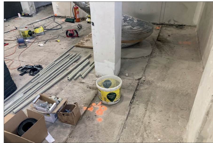
Detail podlahy severní části
