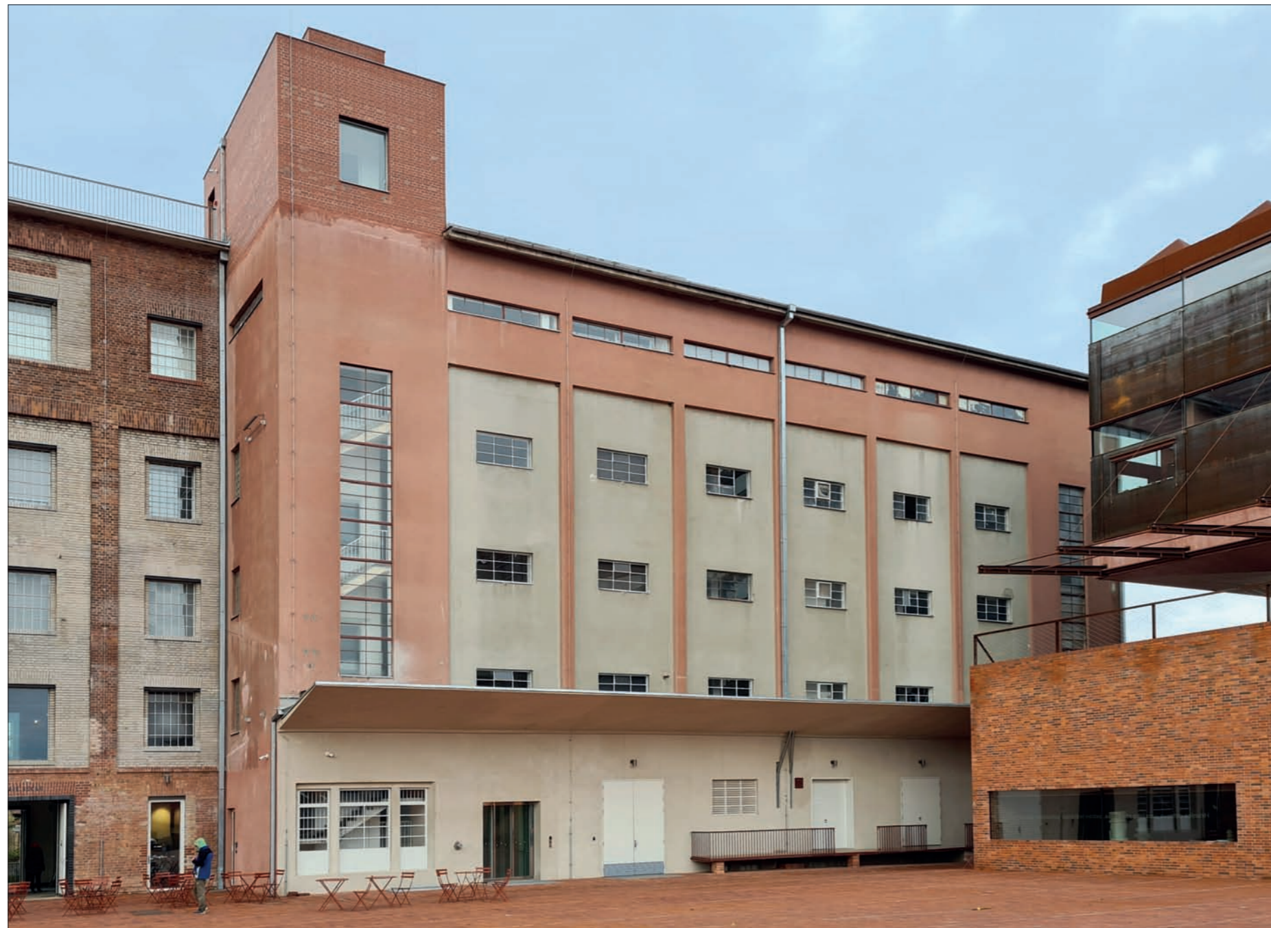
Celkový pohled na východní průčelí
