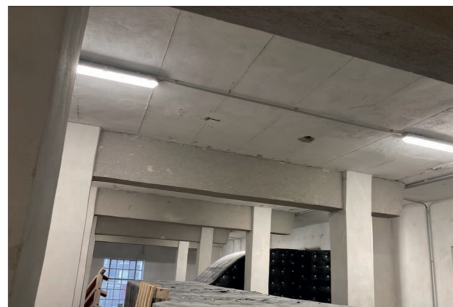
Pohled na strop severní části skladu od jihu
