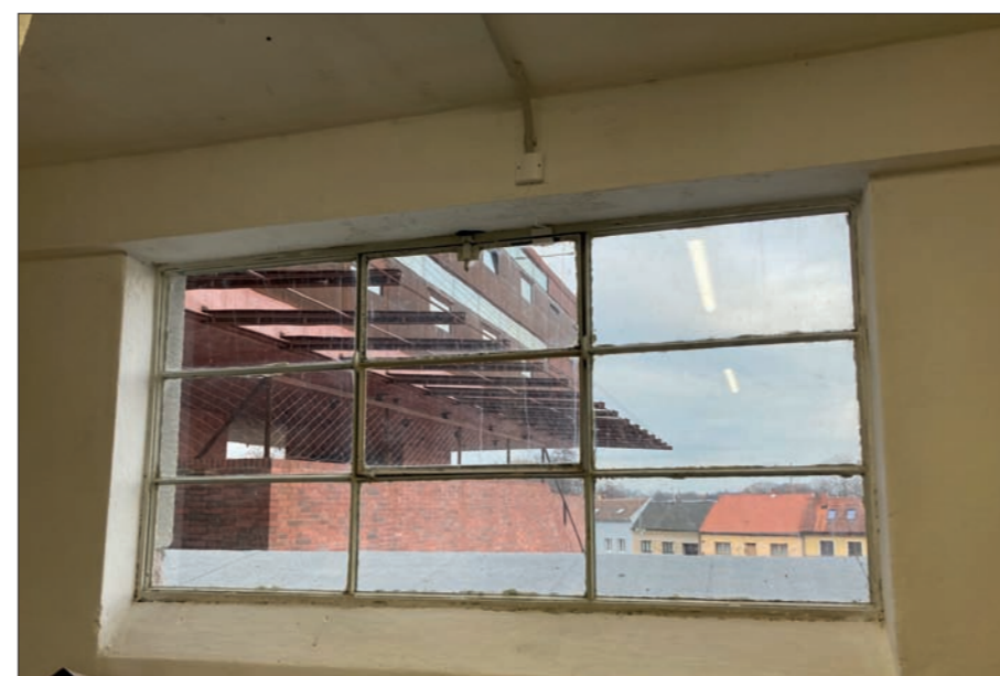
Detail okna ve východní stěně
