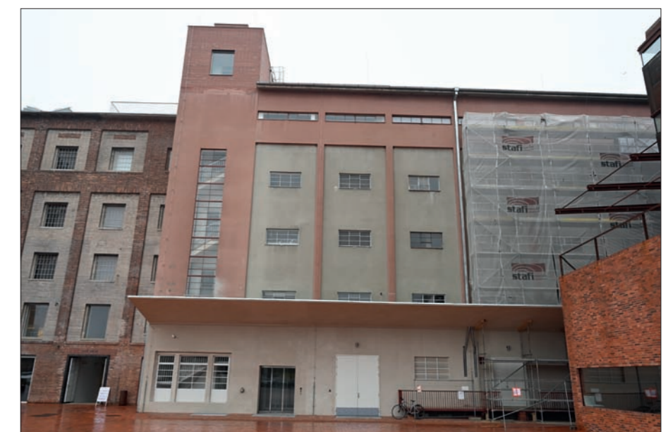
Pohled na jižní část průčelí
