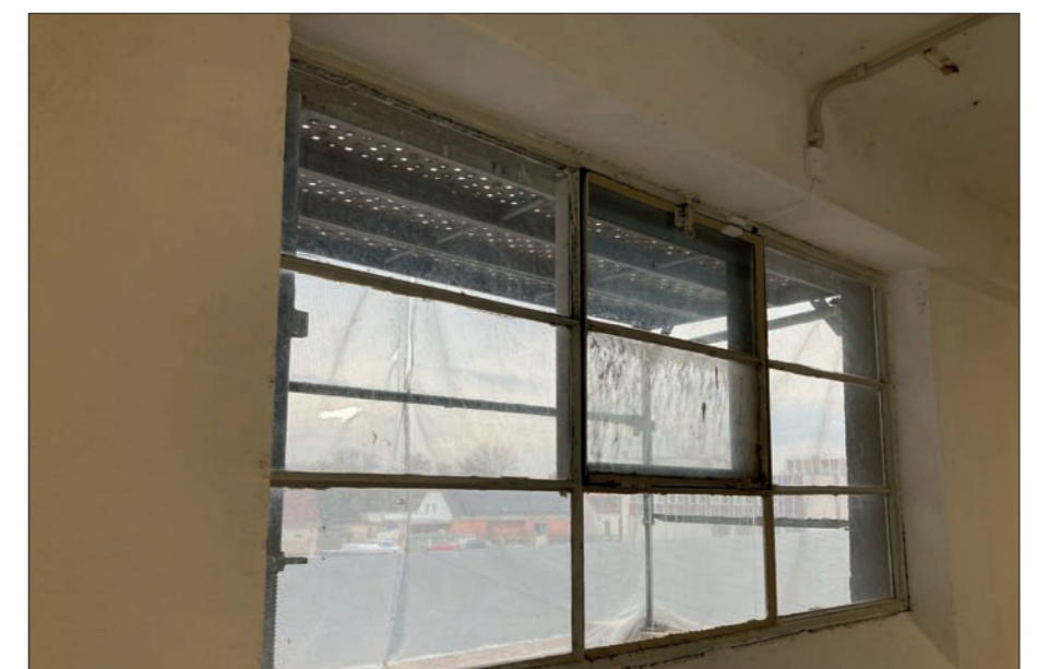
Detail okna ve východní stěně
