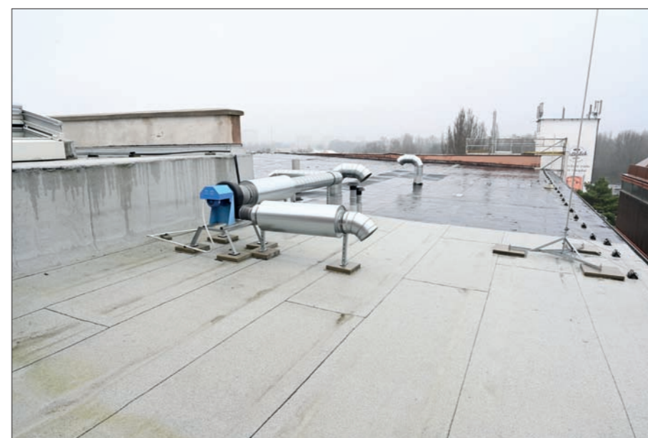
Pohled na východní část střechy od jihu
