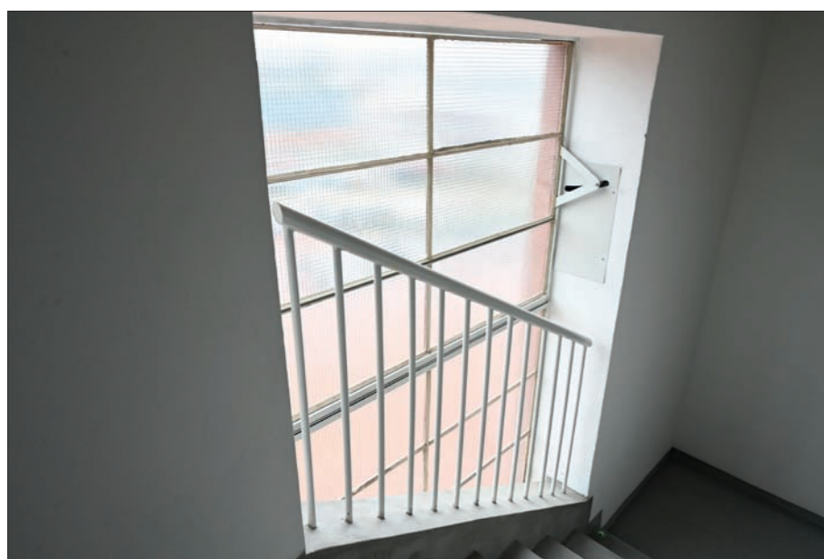
Detail okna zábradlí schodiště
