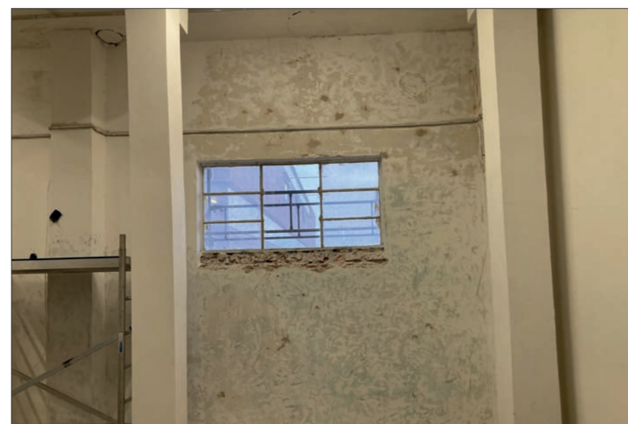
Detail okna ve východní stěně
