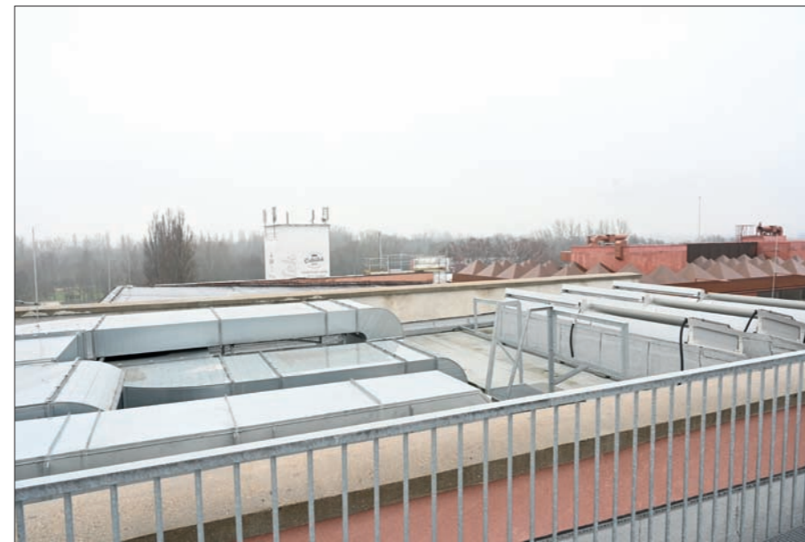
Celkový pohled na střechu nad nadestavěným skladištěm
