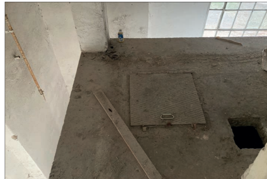
Pohled do prostoru nad silu severozápadním nárožím
