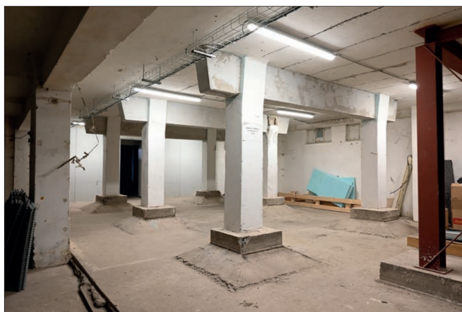
Pohled do severní části suterénu tobogánového skladu od jihu
