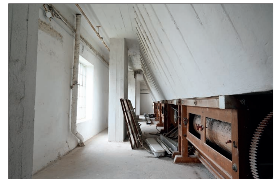
Celkový pohled do západní části sila od jihu
