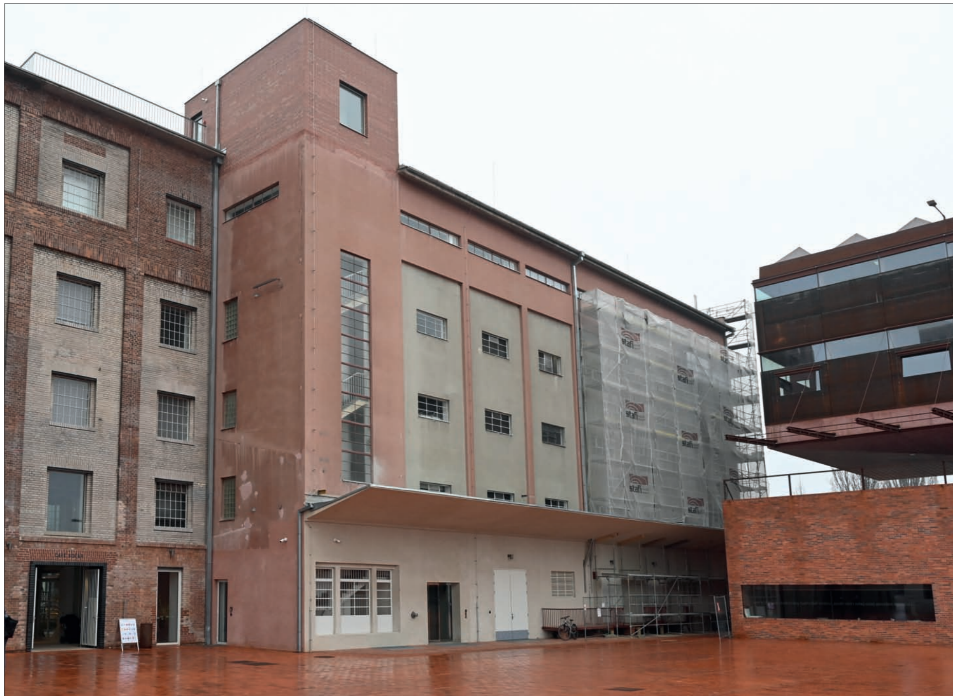
Pohled na jižní průčelí od jihovýchodu
