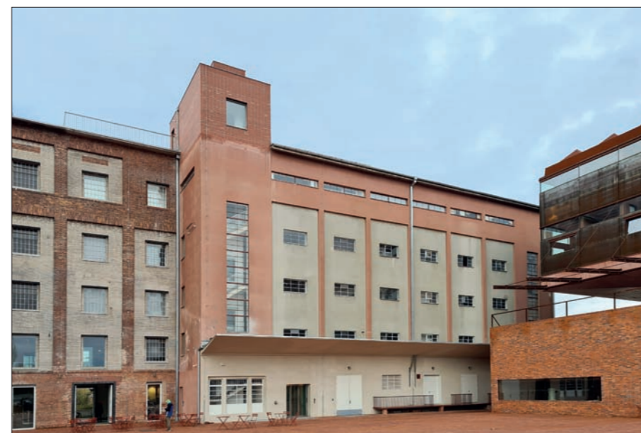
Celkový pohled na část moučného síla od jihovýchodu
