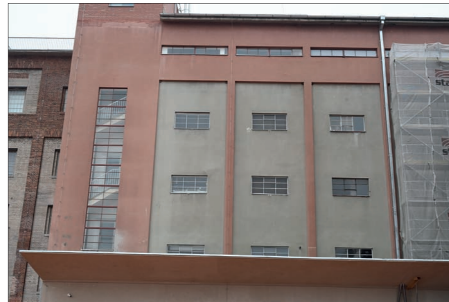
Pohled na jižní část průčelí
