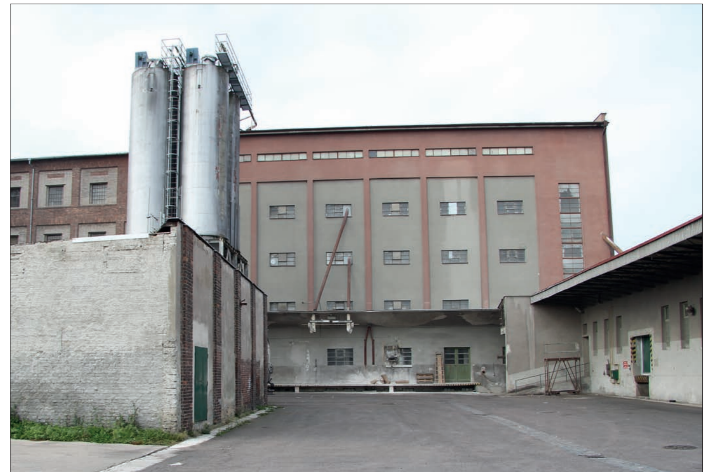
66. Pohled na moučné silo z mlýnského dvora od východu, stav k roku 2012
