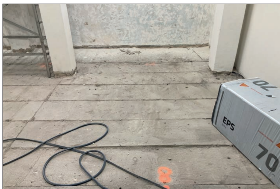
Detail podlahy po odkrytí mazaniny - systémové desky 60. let 20. století
