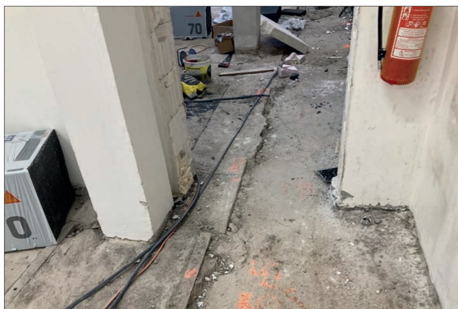
Detail podlahy severní části
