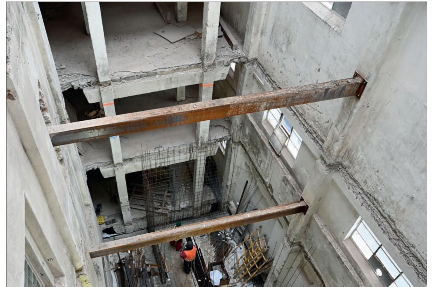
70. Pohled do interiéru moučného síla od jihu, stav k roku 2020
