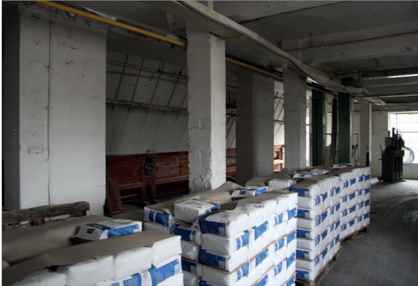
67. Pohled do interiéru přízemí moučného síla od jihu, stav k roku 2012
