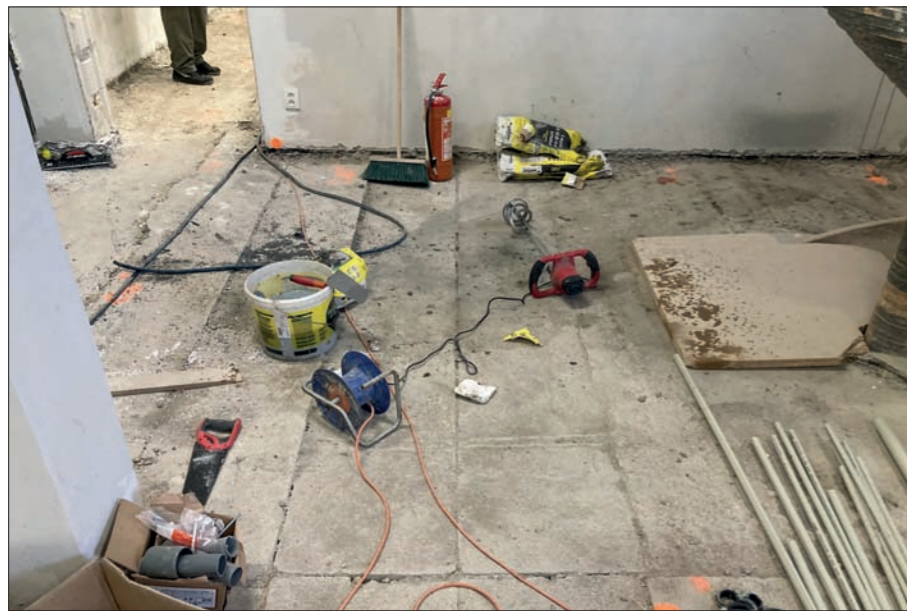
Detail podlahy severní části
