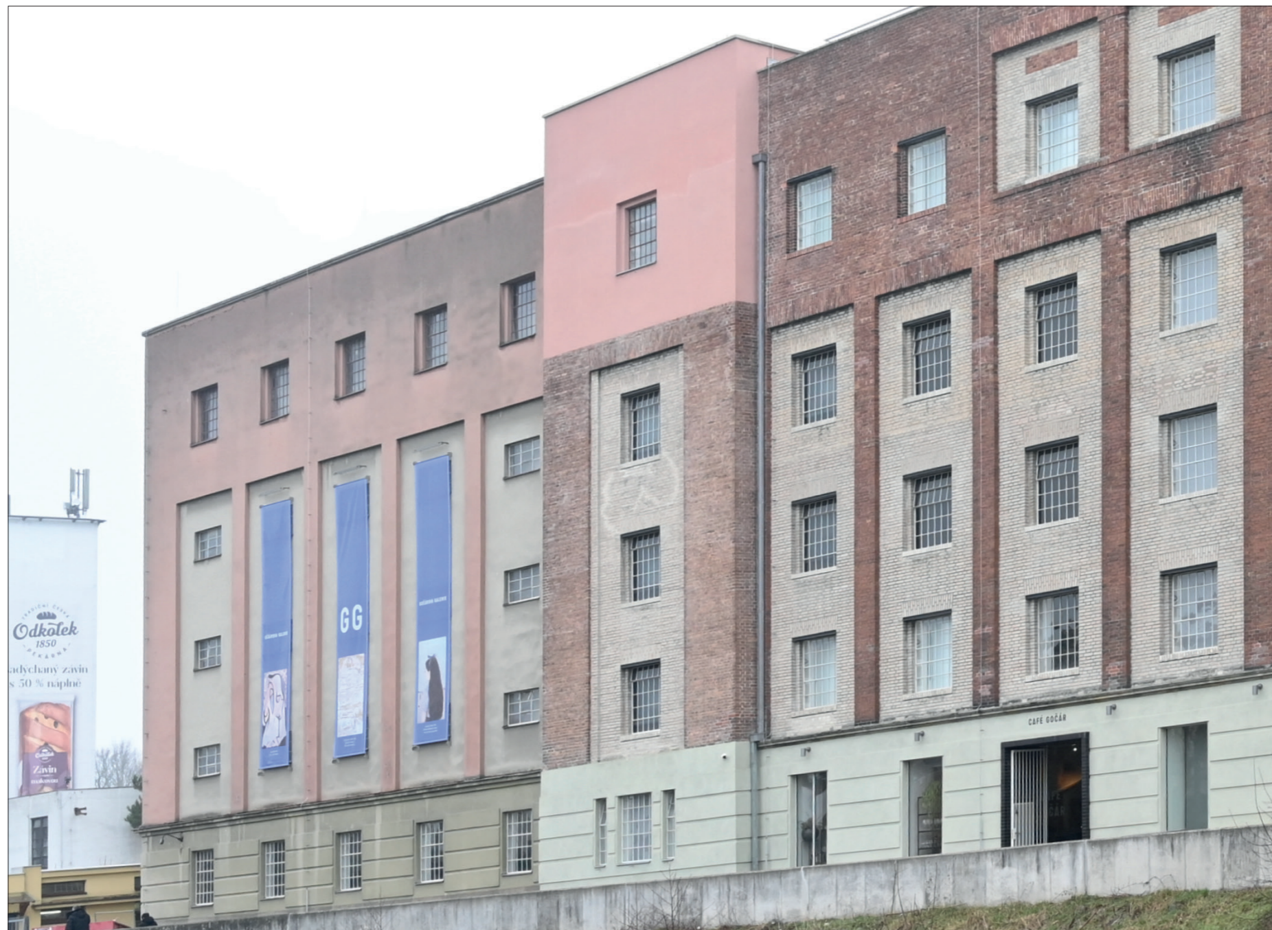
Celkový pohled na západní průčelí
