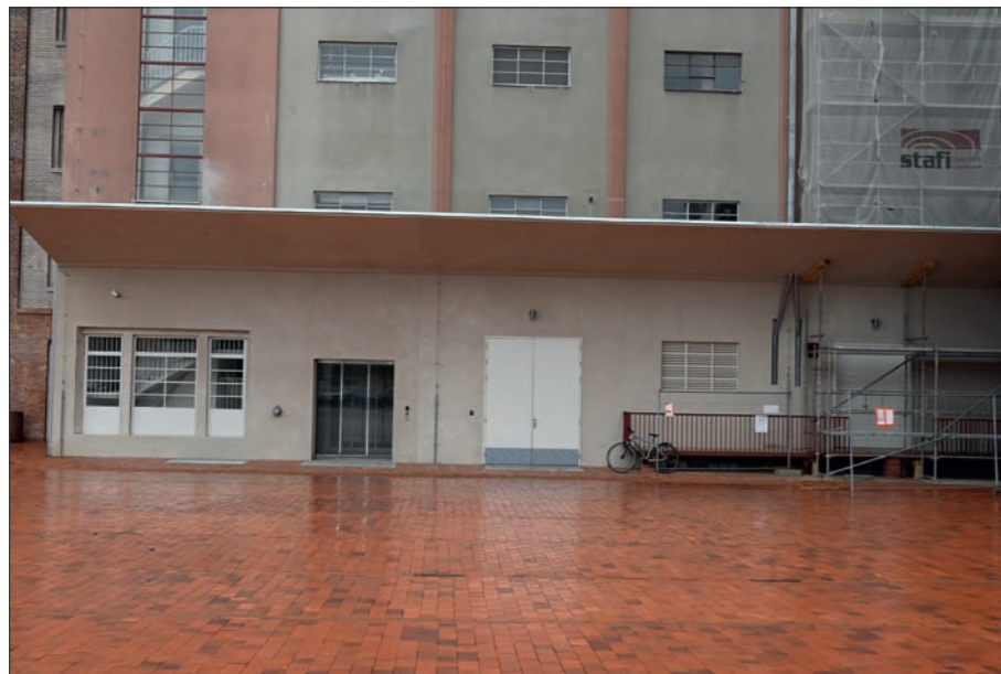
Pohled na parter průčelí
