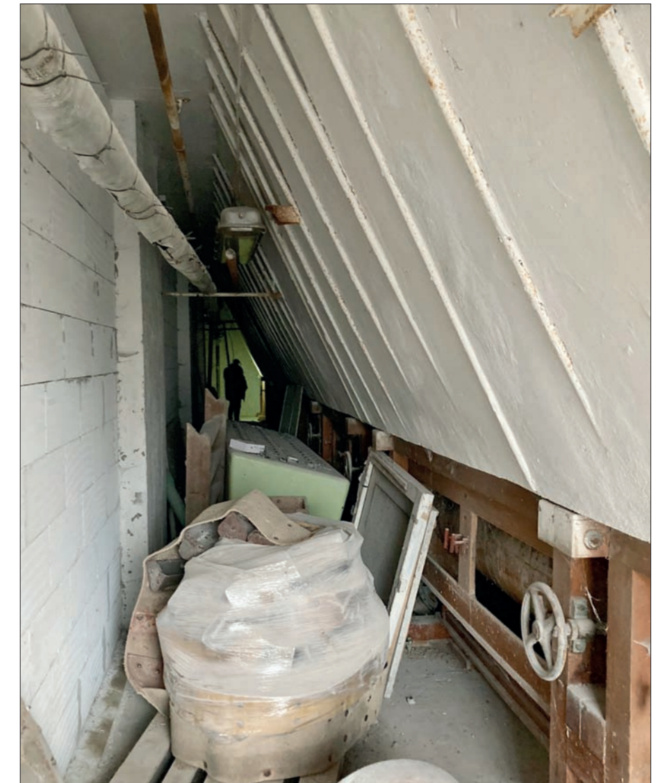
Pohled do východní chodbičky novými výplňovými zdmi mezi pilíři
