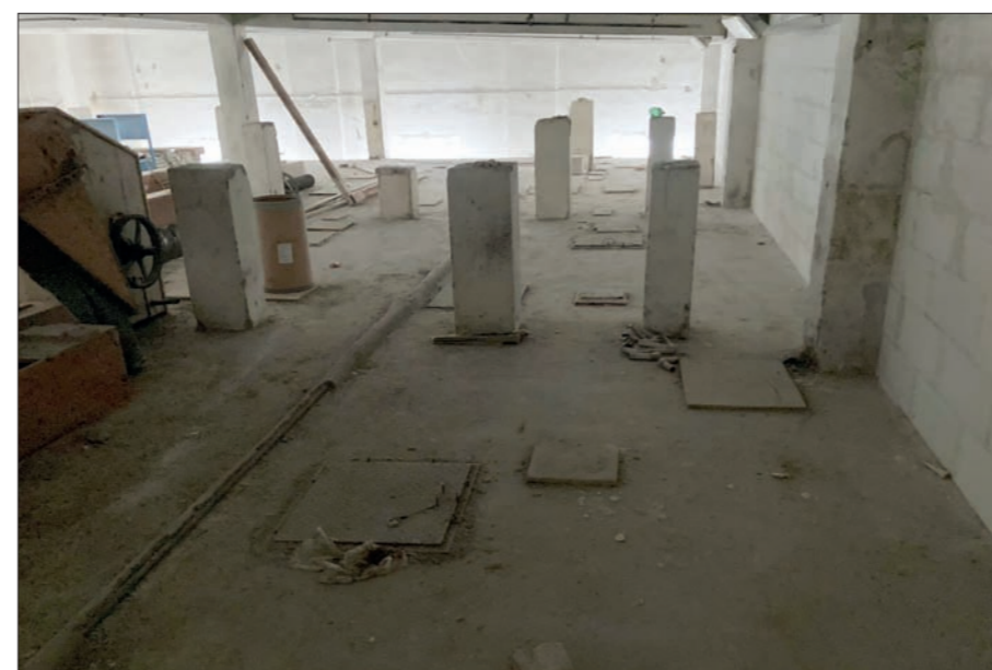
Pohled do prostoru nad silu od jihu - východní část
