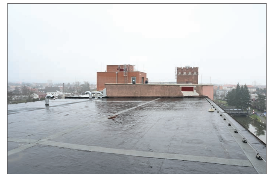
Celkový pohled na střechu od severu
