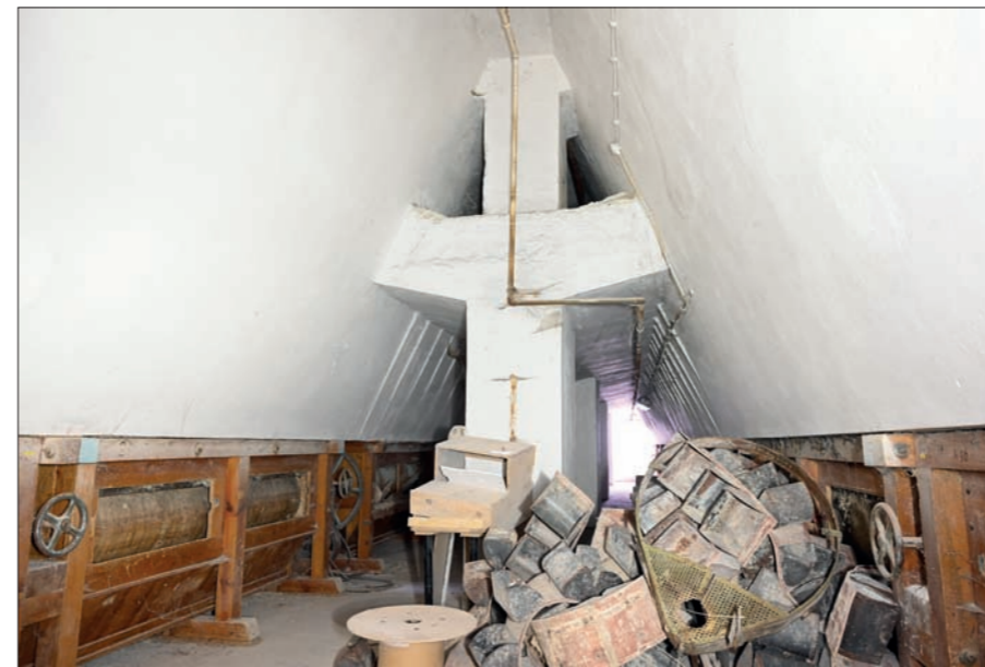
Pohled na konstrukci středních pilířů sil od jihu
