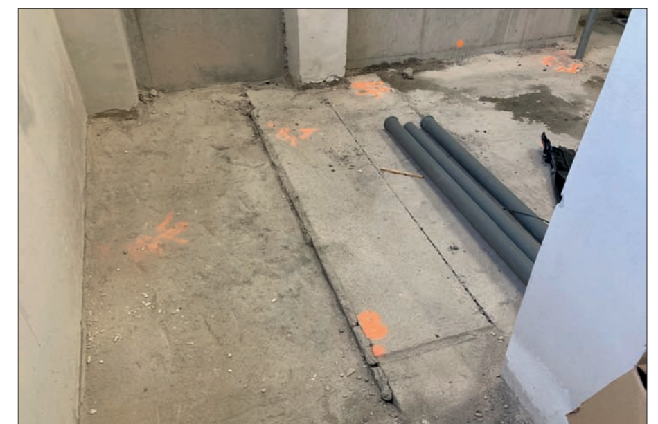
Detail podlahy severní části
