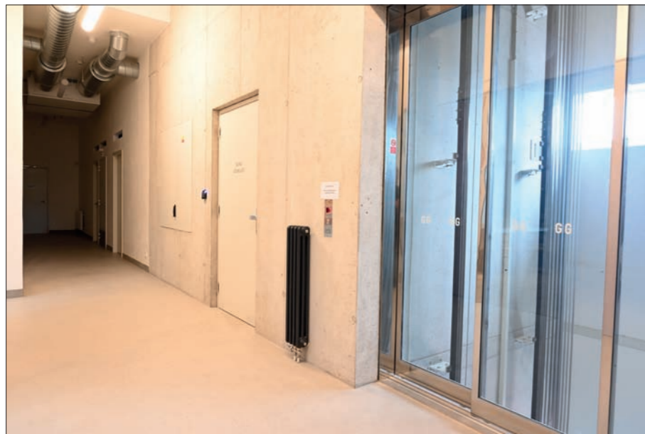
Pohled do přístupové chodby jižní části východního traktu
