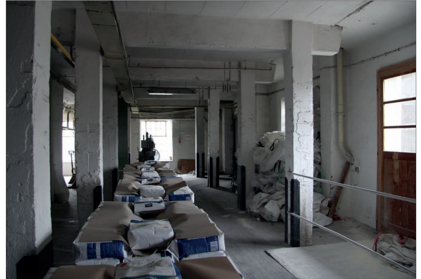
69. Pohled do interiéru přízemí moučného síla od jihu, stav k roku 2012
