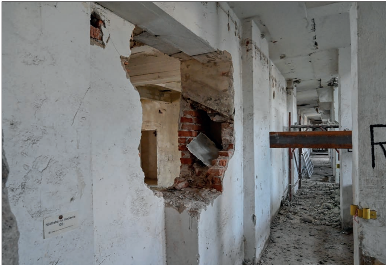
68. Pohled do interiéru moučného síla od jihu, stav k roku 2020
