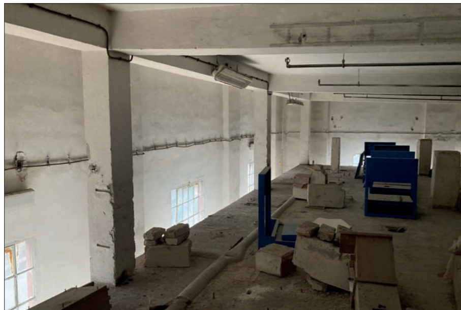
Pohled do prostoru nad silu severozápadním nárožím od jihu
