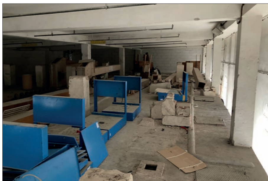
Pohled do prostoru nad silu od severu
