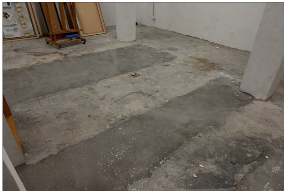
Detail podlahy severní části
