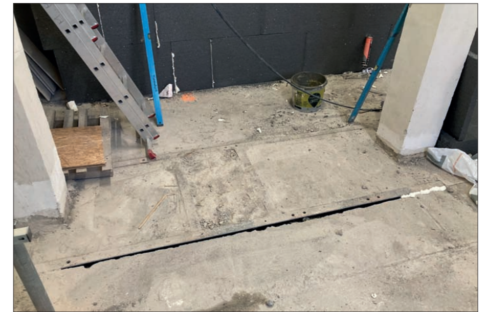
Detail podlahy severní části
