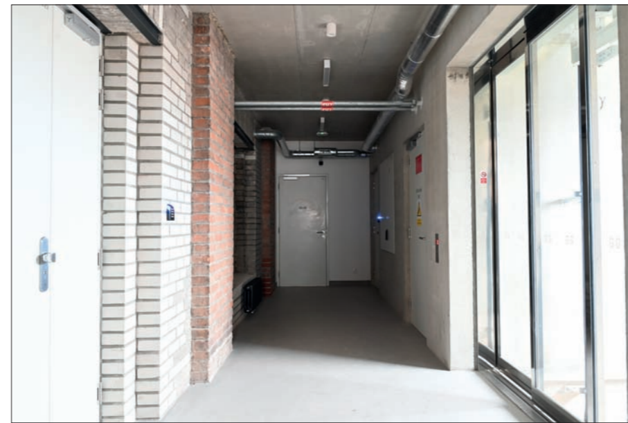
Pohled od jihu do přístupové chodby vydělené nově jižní části východního traktu
