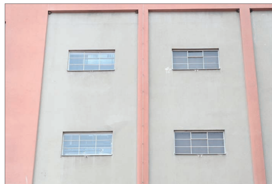
Pohled na okna vyšších podlaží
