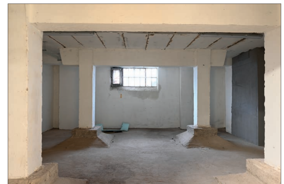
Pohled na východní stěnu suterénu tobogánového skladu
