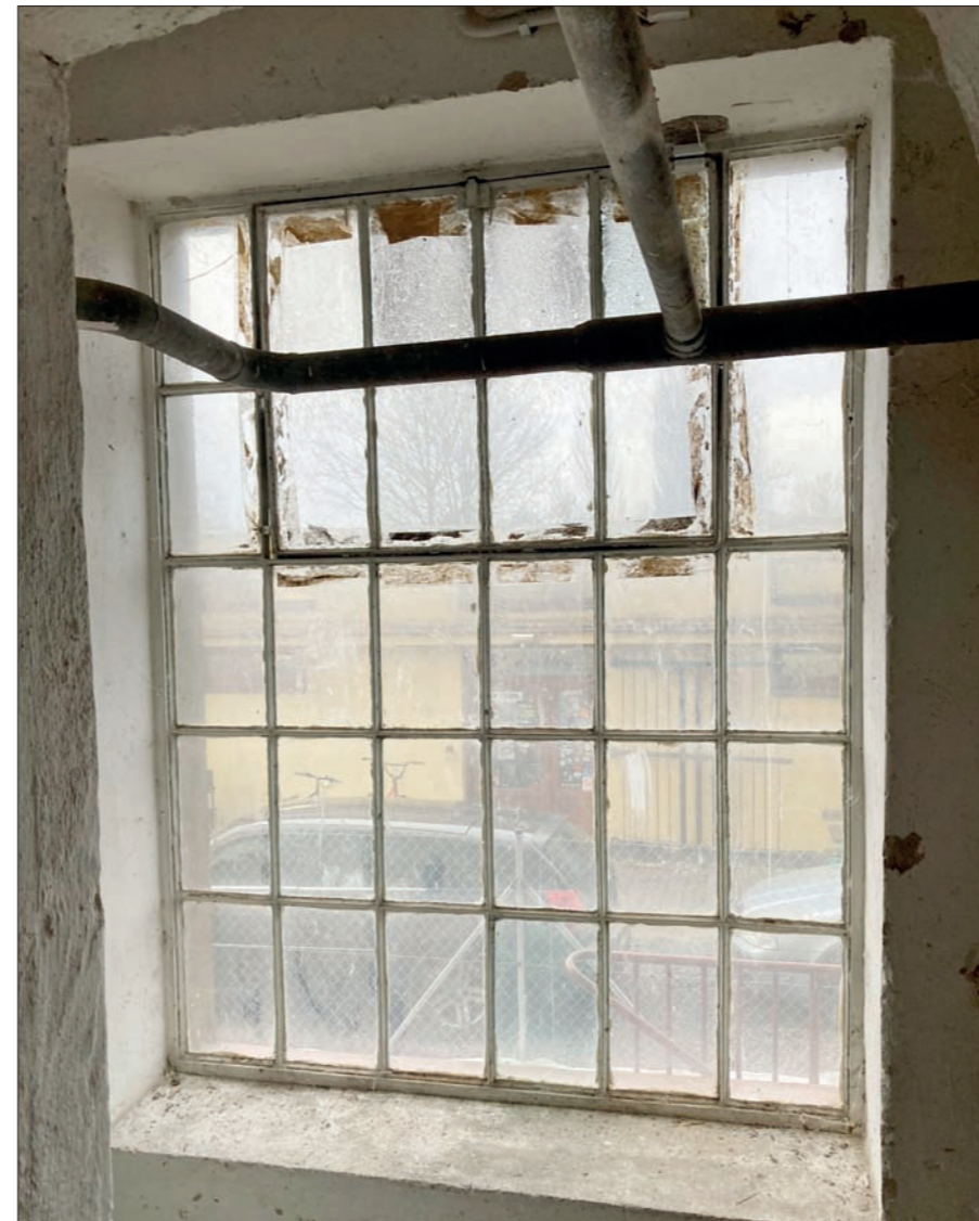
Detail okna severní stěně
