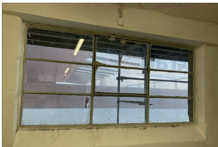
Detail okna ve východní stěně
