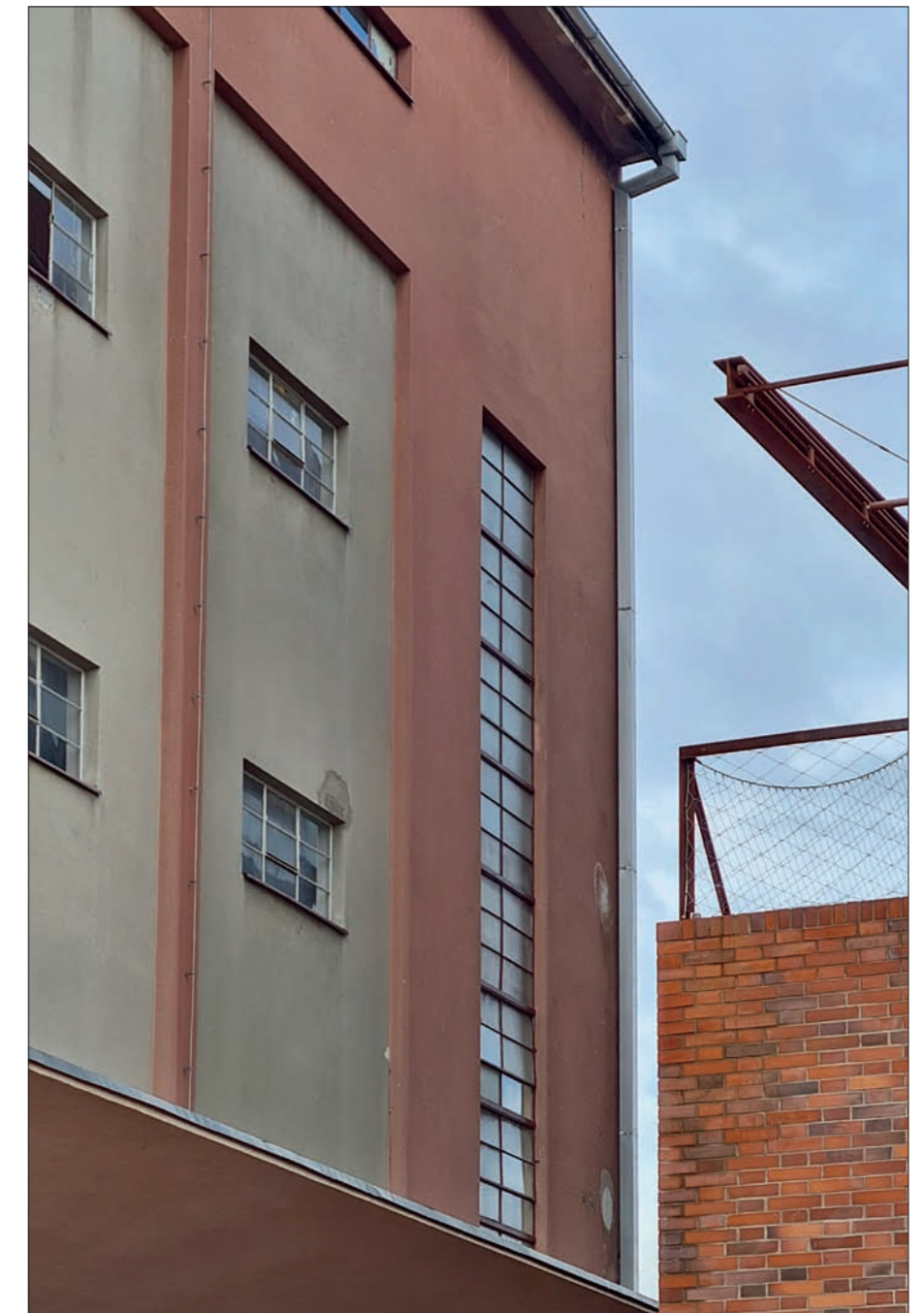
Pohled na severní část průčelí
