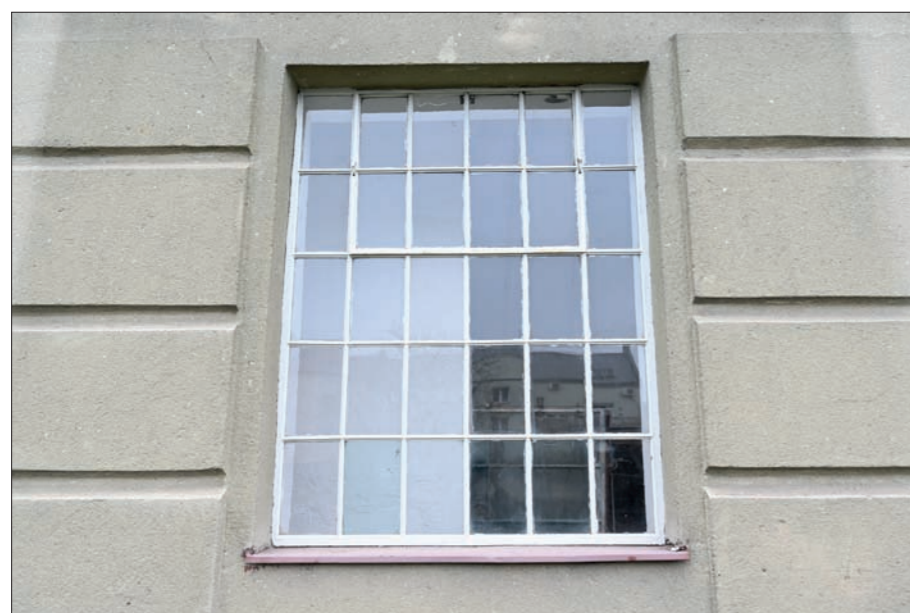
Detail okna přízemí (cca 1960)
