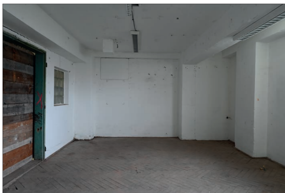
Místnost vydělená severozápadním nárožím suterénu
