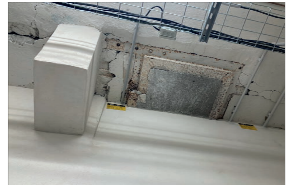
Detail stropu ve střední části se zachovaným prostupem technologie
