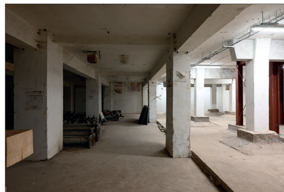
Pohled na předěl mezi suterénem pod silem skaldem od jihu
