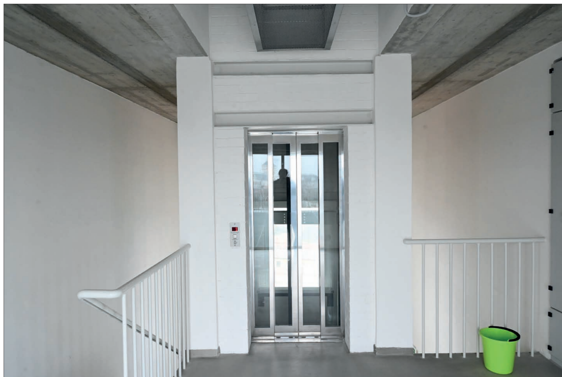
Pohled do interiéru nové nástavby výtahovou šachtou schodištěm
