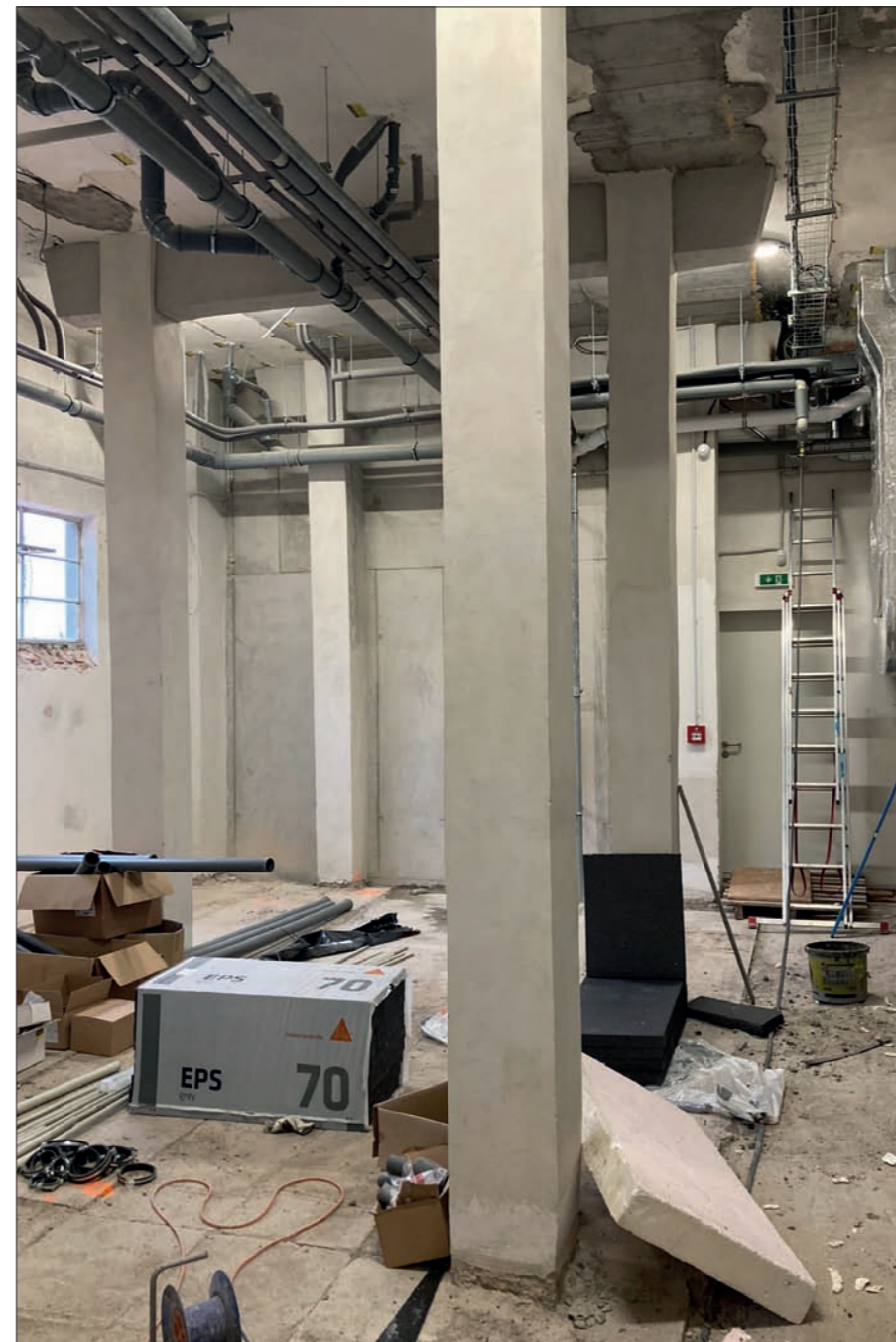
Pohled do střední části tobogánového skladu od severu
