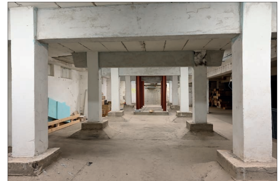
Pohled do suterénu tobogánového skladu od severu
