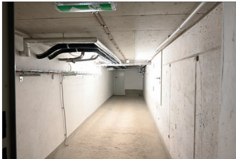
Pohled do přístupové chodby pod východním traktem od severu
