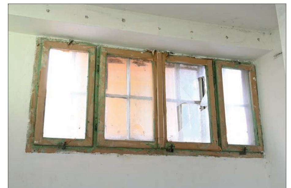
Detail vnitřního okna západní stěně suterénu
