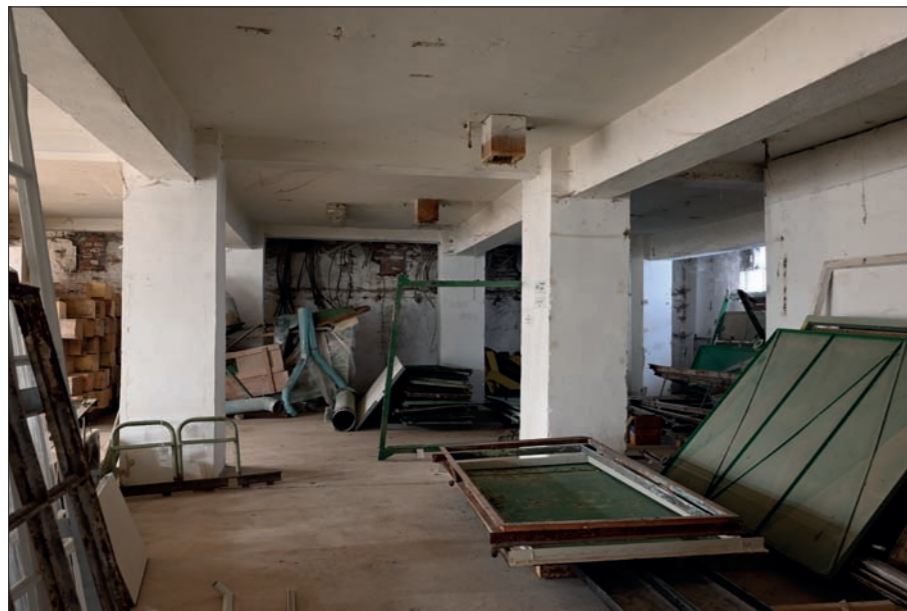
Celkový pohled do prostoru pod hlubinnými sily od severu
