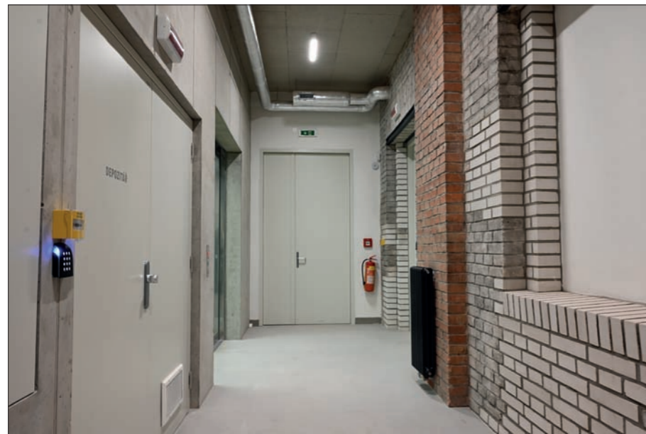
Pohled do přístupové chodby od severu. Vlevo nově vestavěné konstrukce, vpravo původní průčelí mlýna.
