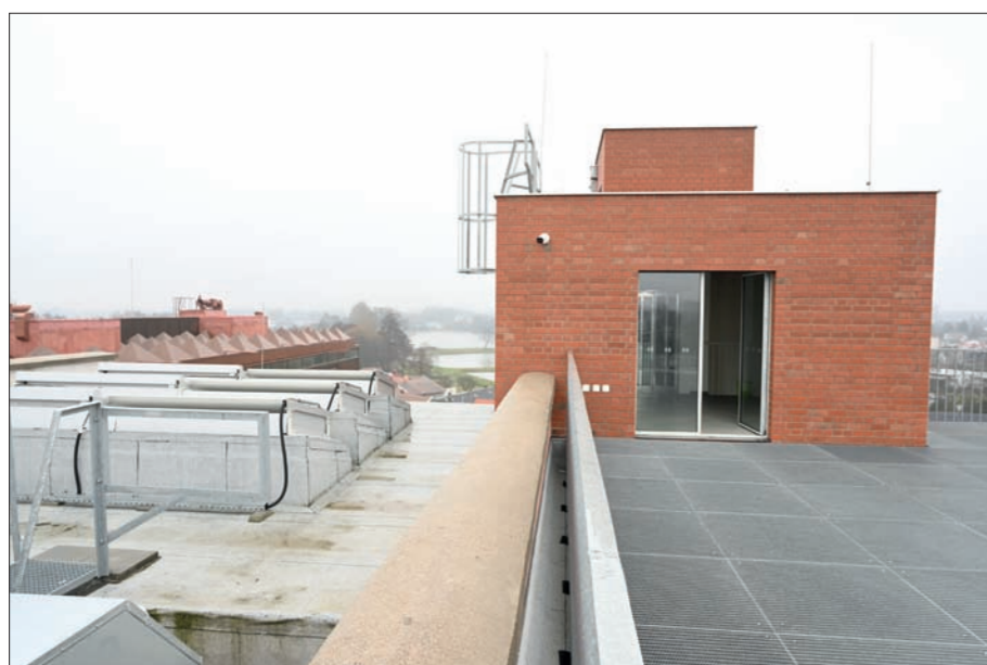
Pohled na vztah mezi nástavbou výtahové šachty střechy nad bývalým skladištěm
