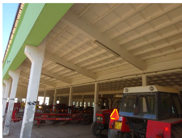
Objekt H - Střešní konstrukce (částečně dřevěný rošt, na který je uložena plechová krytina)
