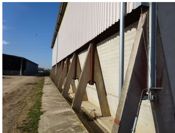
Objekt G - Spodní část konstrukce – řešena v železobetonu
