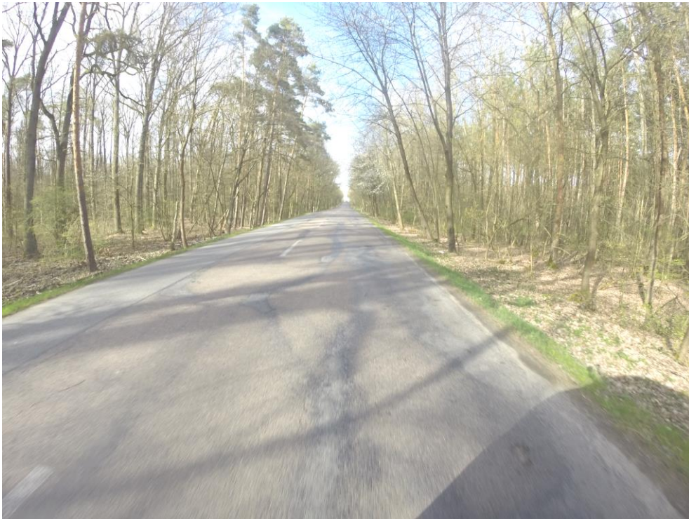
Obr. 11 – Silnice II/323 – extravilán, lesní úsek (km 4,150).
