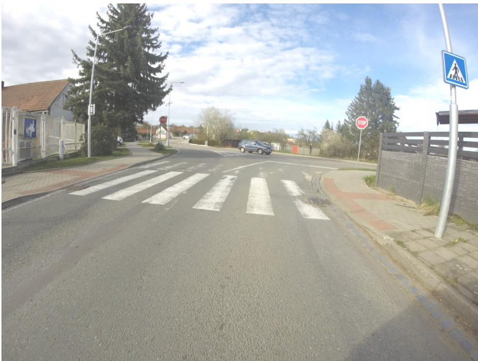
Obr. 15 – Silnice II/323 – intravilán obce Rohovládova Bělá, křižovatka se silnicí II/211 konec úseku (km 5,400).
