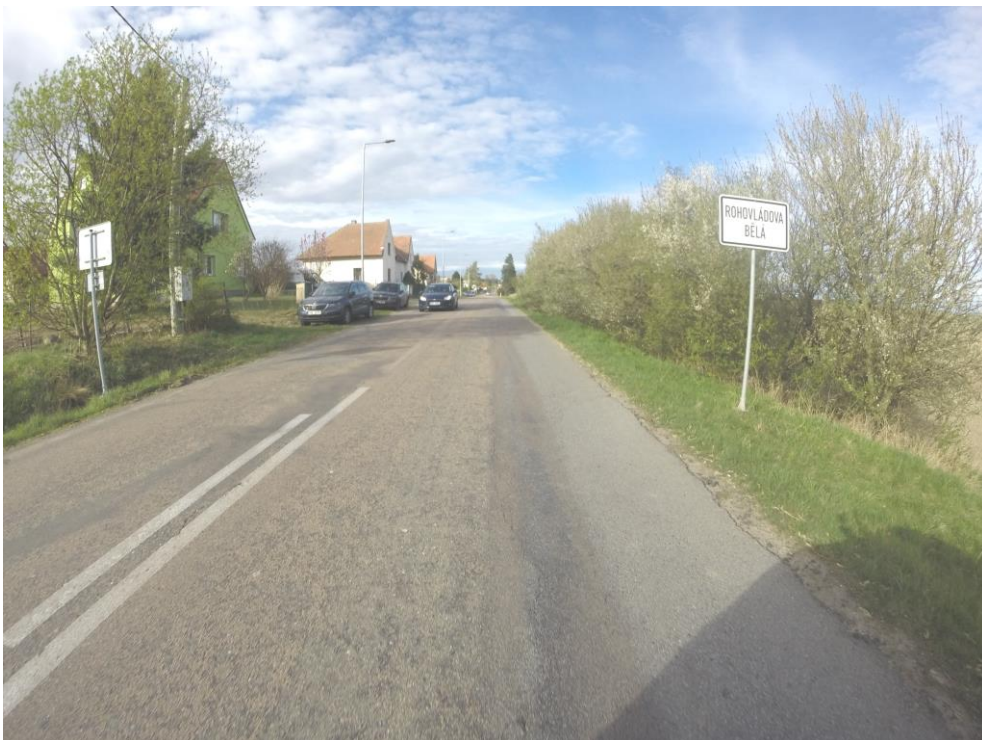
Obr. 12 – Silnice II/323 – vjezd do obce Rohovládova Bělá (km 5,000).
