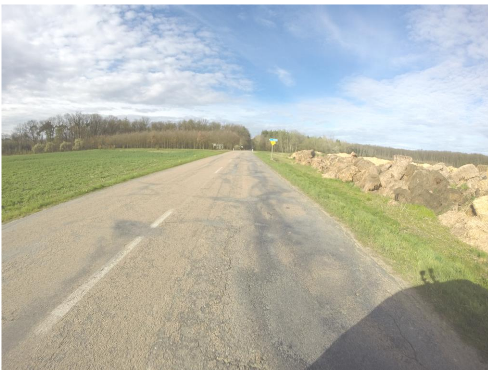
Obr. 10 – Silnice II/323 – extravilán, před křižovatkou se silnicí III/3233 (km 3,800).
