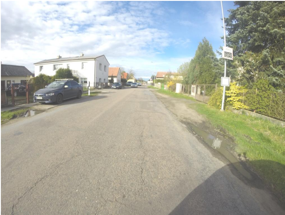
Obr. 13 – Silnice II/323 – intravilán obce Rohovládova Bělá (km 5,250).
