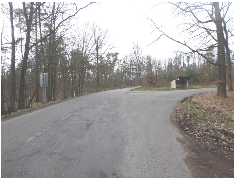
Obr. 1 – Silnice II/323 – začátek úseku, křižovatka se silnicí III/0361 (km 0,000).
