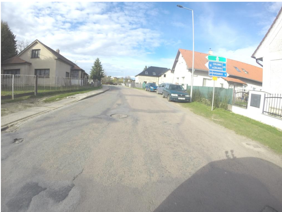
Obr. 14 – Silnice II/323 – intravilán obce Rohovládova Bělá (km 5,350).
