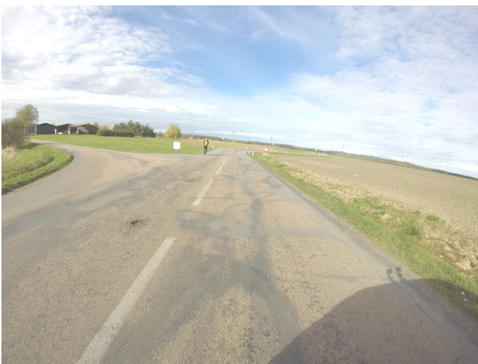
Obr. 6 – Silnice II/323 – křižovatka se silnicí III/3232 u obce Vlčí Habřina (km 2,600).
