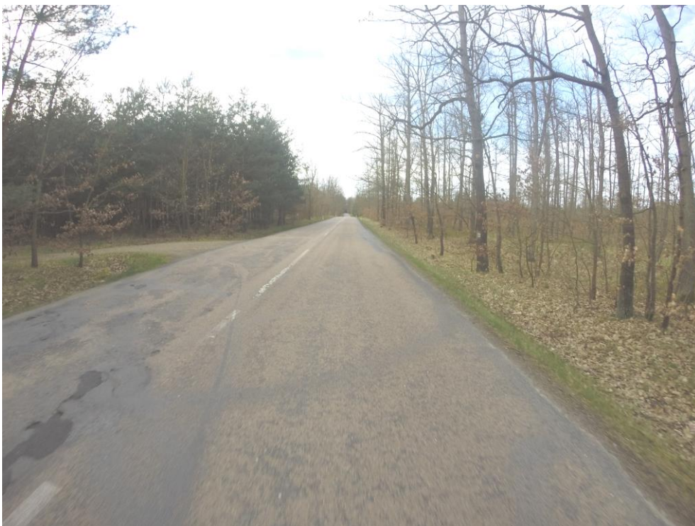
Obr. 2 – Silnice II/323 – lesní úsek (km 0,500).
