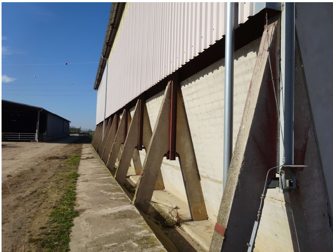
Spodní část konstrukce – řešena v železobetonu
