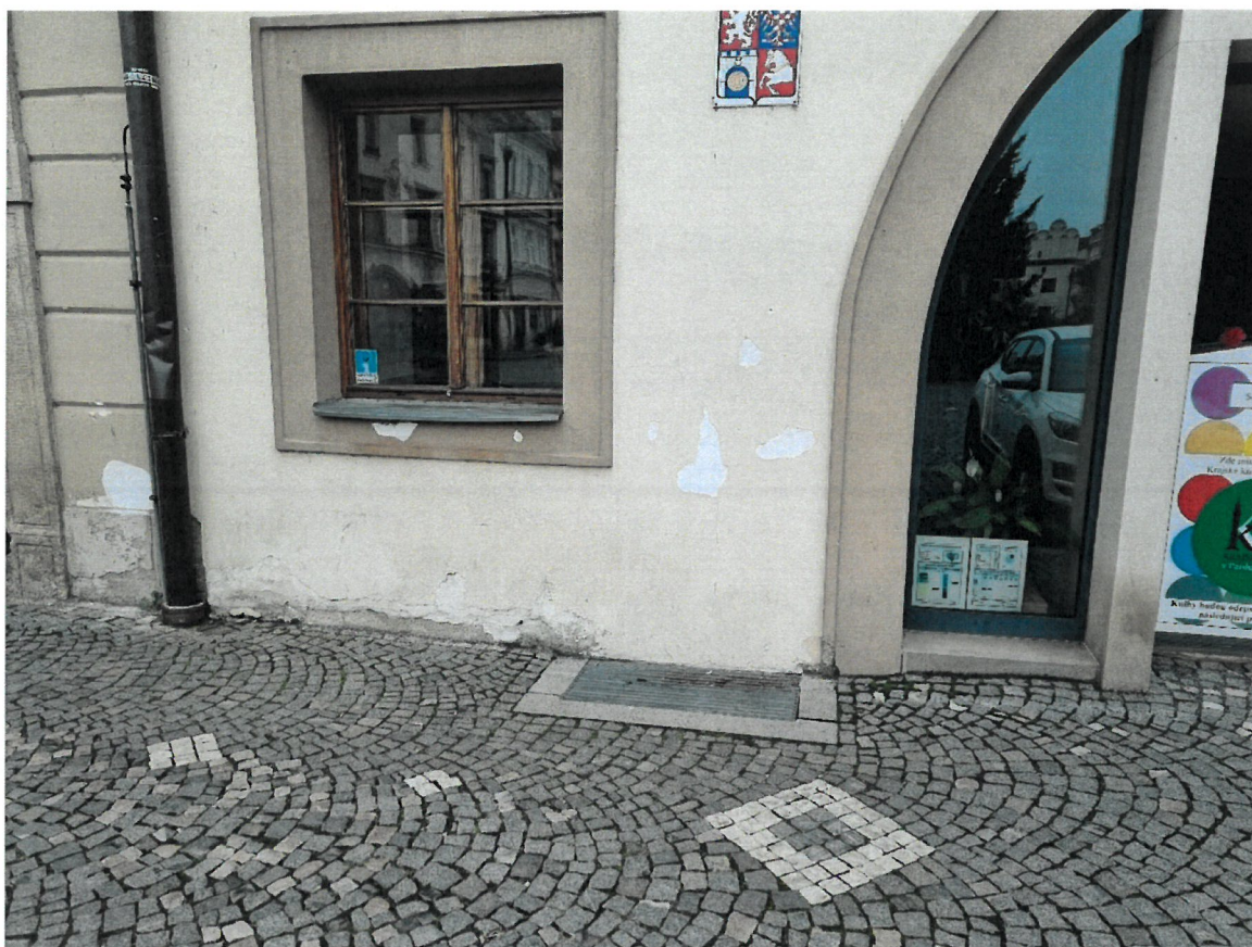
Obrázek 6: Odlupování fasádní barvy i se štukem vlivem vlhkosti a zasolení.
