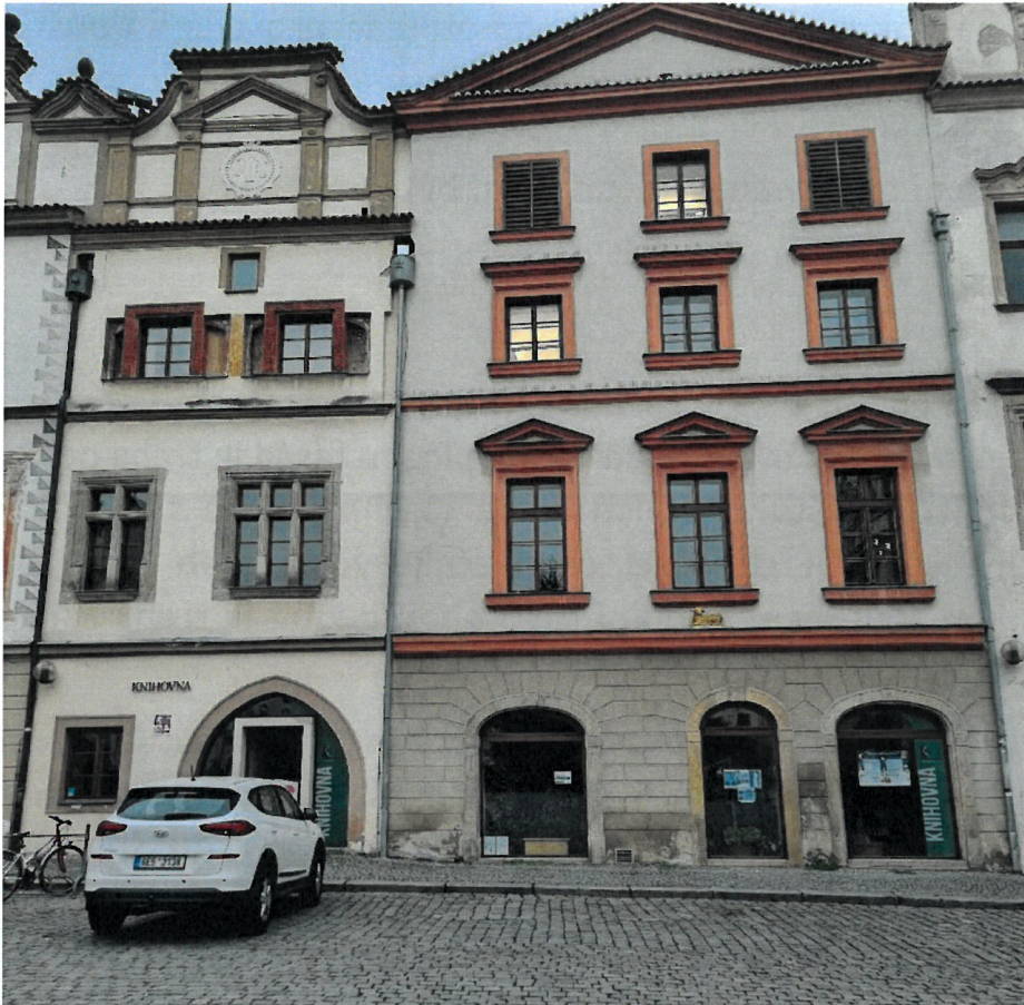
Obrázek 2: Celkový pohled na domy čp. 78 (vlevo) a čp. 79 (vpravo)
