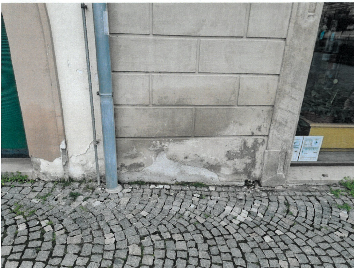
Obrázek 7: Odlupování fasádní barvy i se štukem vlivem vlhkosti a zasolení.
