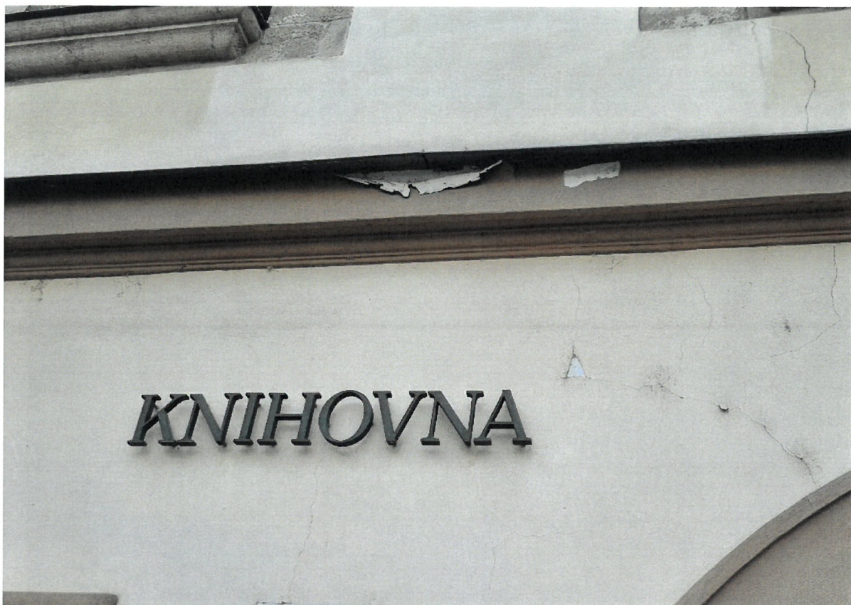
Obrázek 4: Odlupování barvy pod římsou
