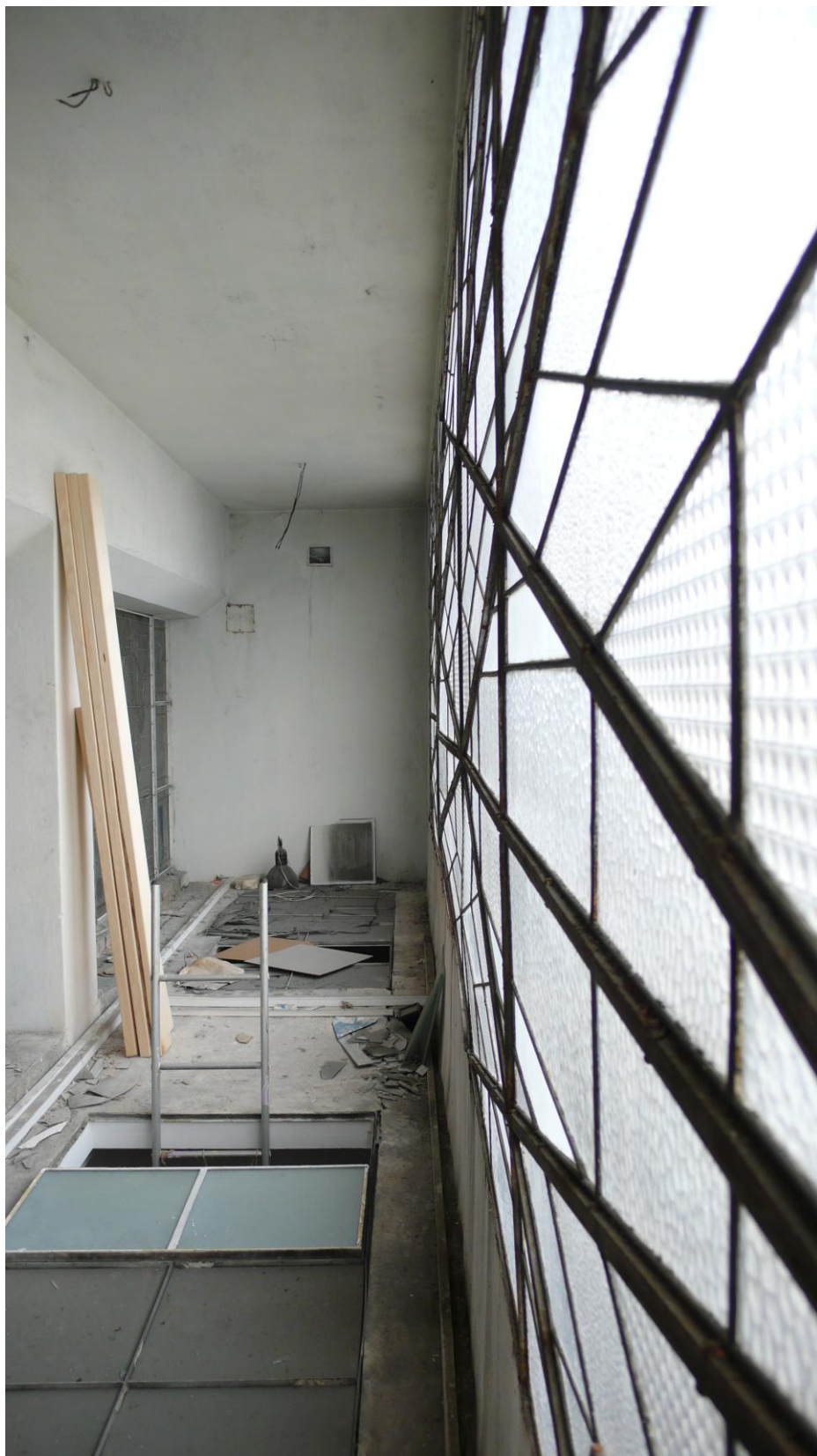
deformace kovového rámu v ploše
