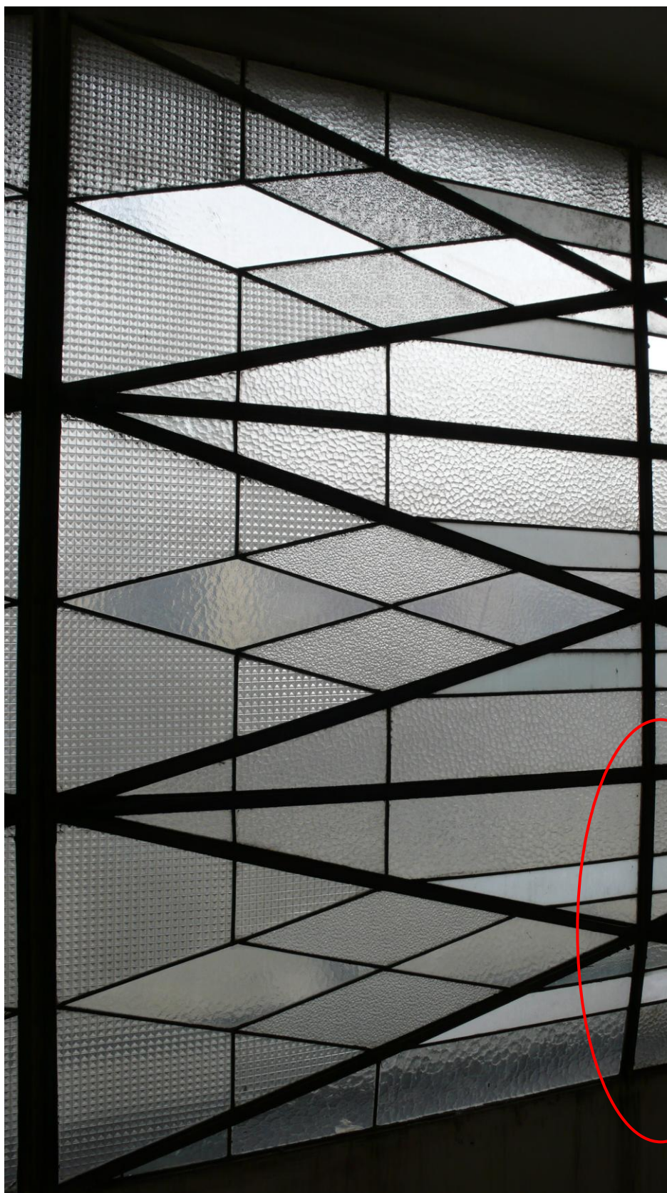
detail deformace kovového rámu v ploše
