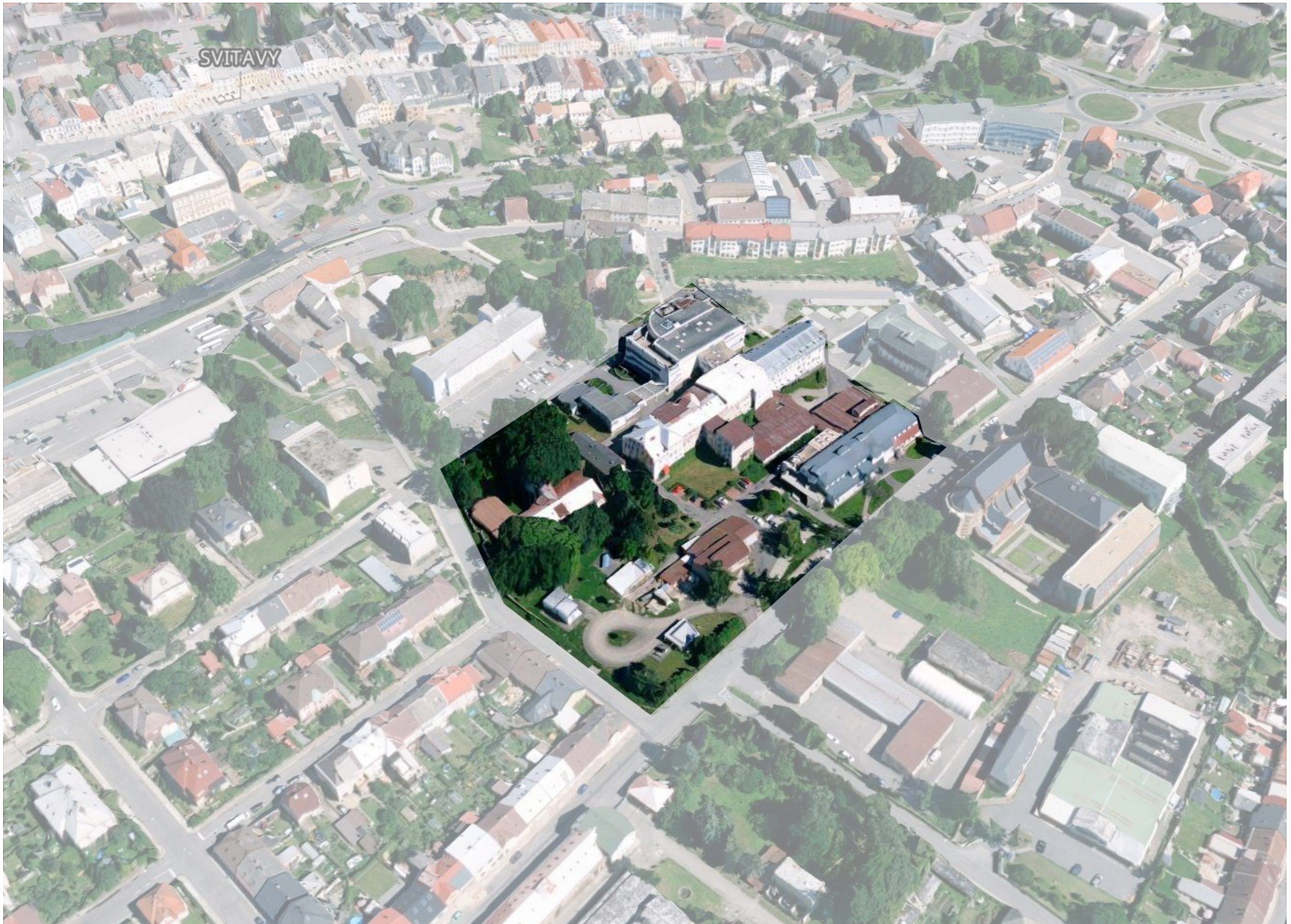
SVITAVSKÁ NEMOCNICE | AREÁL NADHLED
