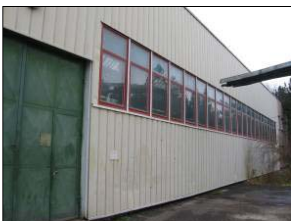
Zateplená stěna dílen + rek. okna
