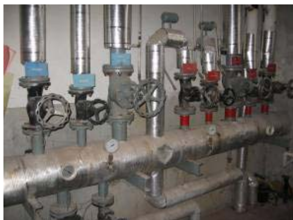
Rozdělovač topení pro objekty
