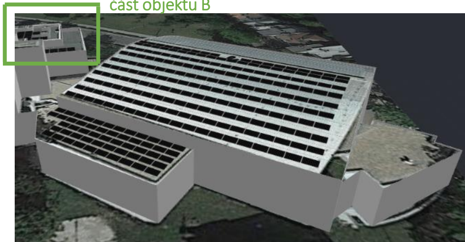
část objektu B
