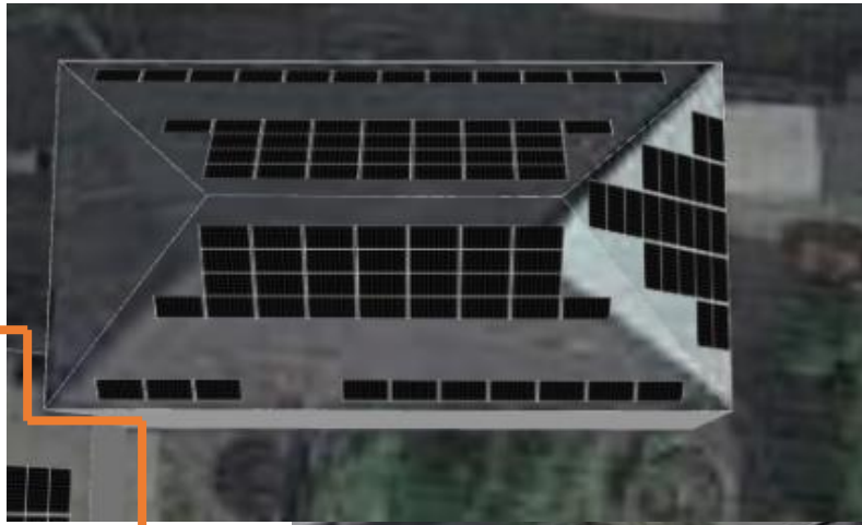
část objektu D
