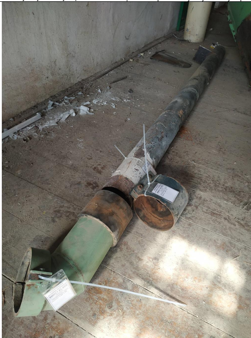
Pohled na demontovaný prvek XM017.01.02 A, B, C, oštitkovaný, připravený k uložení. Prvky uloženy: XM017.01.02A+C – sklad VČG v 1.PP, prvek XM017.01.02B – 1.NP, 1.38
