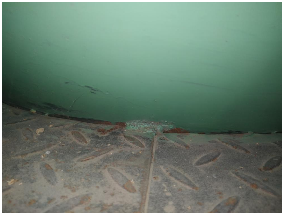
Detail přivaření tělesa XM017.01.01A
