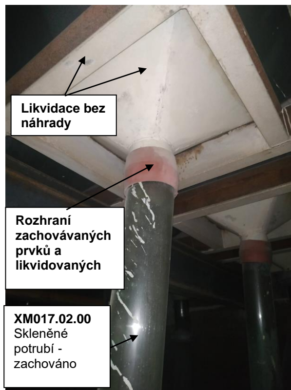
Detail ukončení skleněného potrubí v místě napojení na násypkovou plochu v prostoru 3.NP
