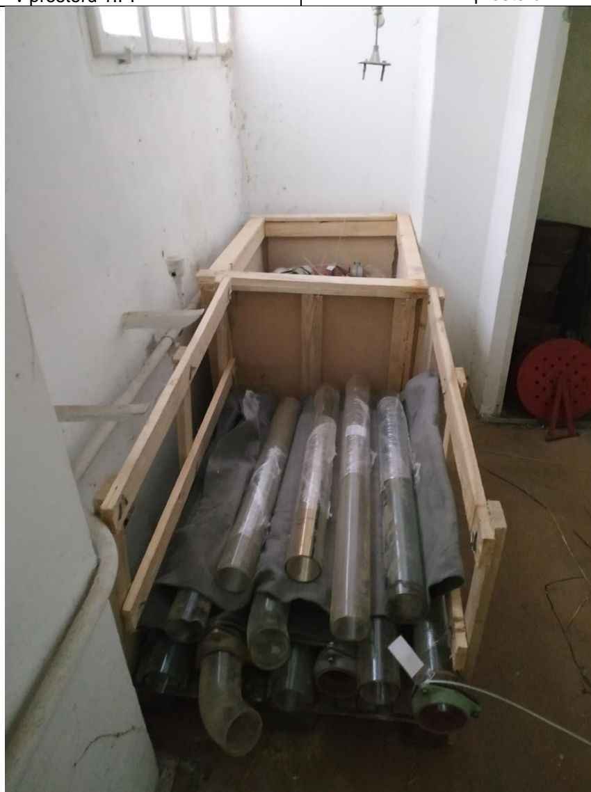
Všechny skleněné prvky trubic XM017.02 byly uloženy v bedně v uzamčené místnosti skladu VČG v prostoru 1.PP. Skleněné trubice byly proloženy geotextilií, aby nebylo poškození či prasknutí.
