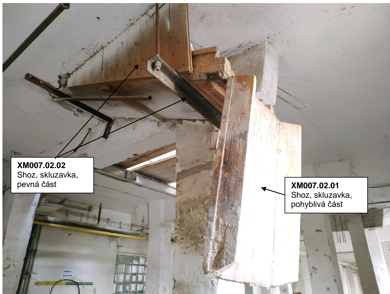
Pohled na shoz prvku XM007 v prostoru 1.NP, označený XM007.02.01 a XM007.02.02
