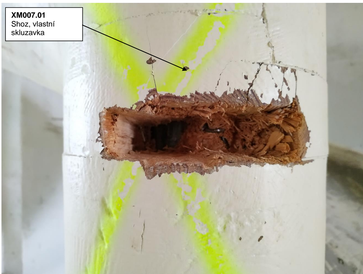
Pohled na prvek shozu XM007.01 – sonda – zachycena ocelová trubkovitá konstrukce
