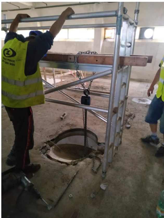
Vytvoření pevného bodu pro uchycení vrátku v prostoru 5.NP
