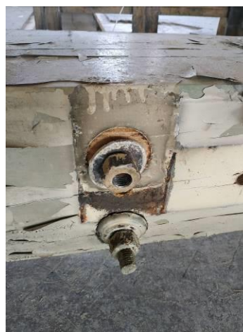
Kotevní táhla, ozdobné podložky i matky ponechány na samotných trámech XM014.04.02Č a Z
