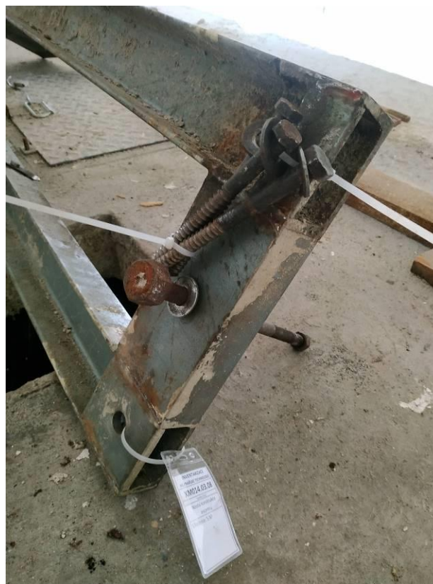
Prvek XM014.03.08 po demontáži s patrným přikotvením šroubů a vrutů
