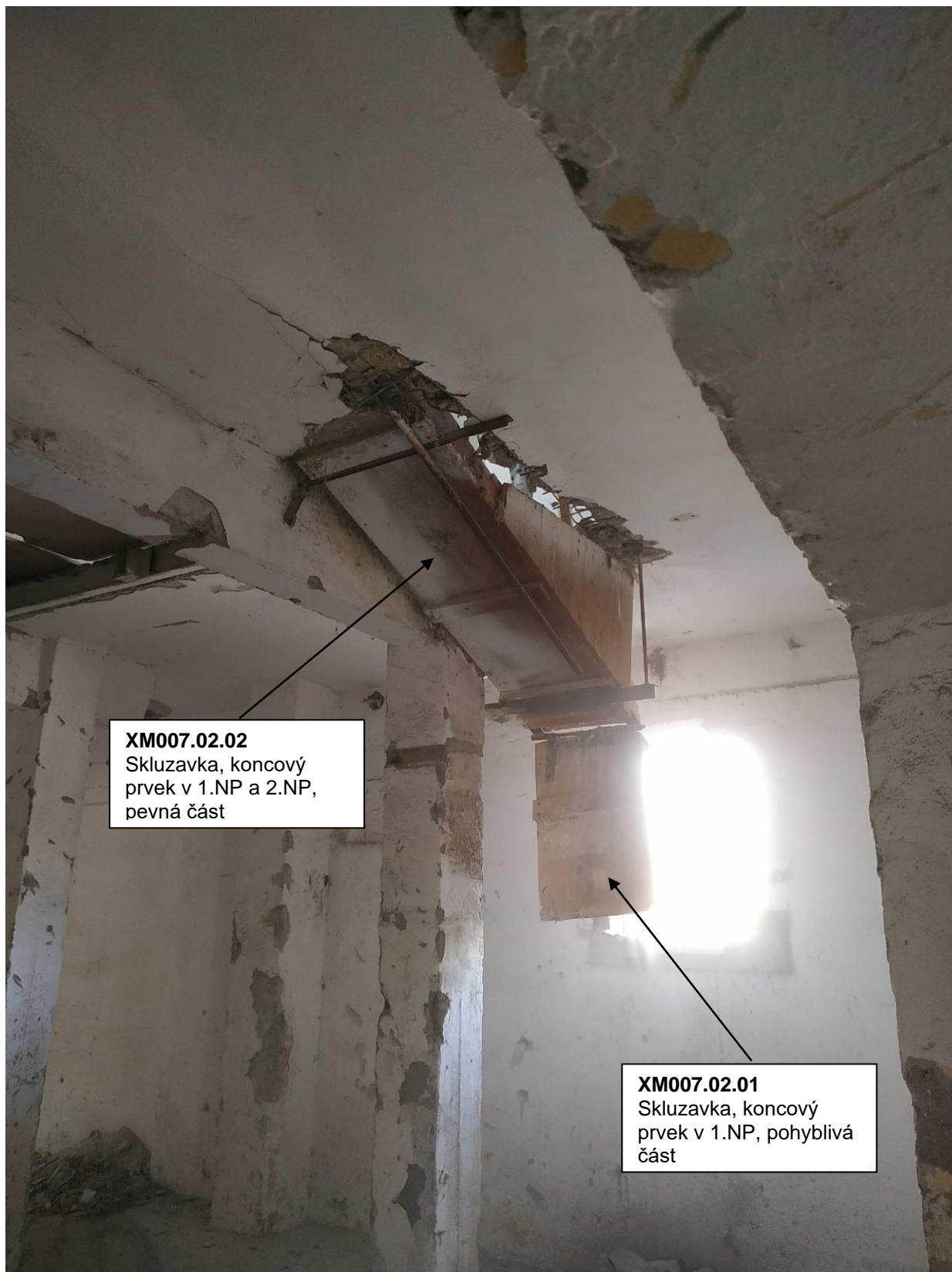
Pohled na koncový prvek shozu označený jako XM007.02.01 a XM007.02.02
