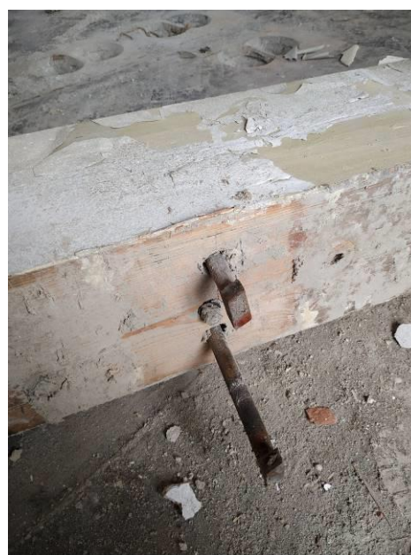
Detail kotevního prvku trámu do ocelového průvlaku
