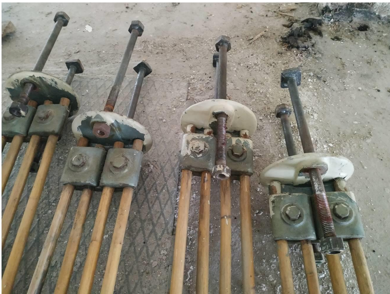
Detail demontovaných bambusových táhel XM014.04.01LČ, PČ, LZ, PZ
