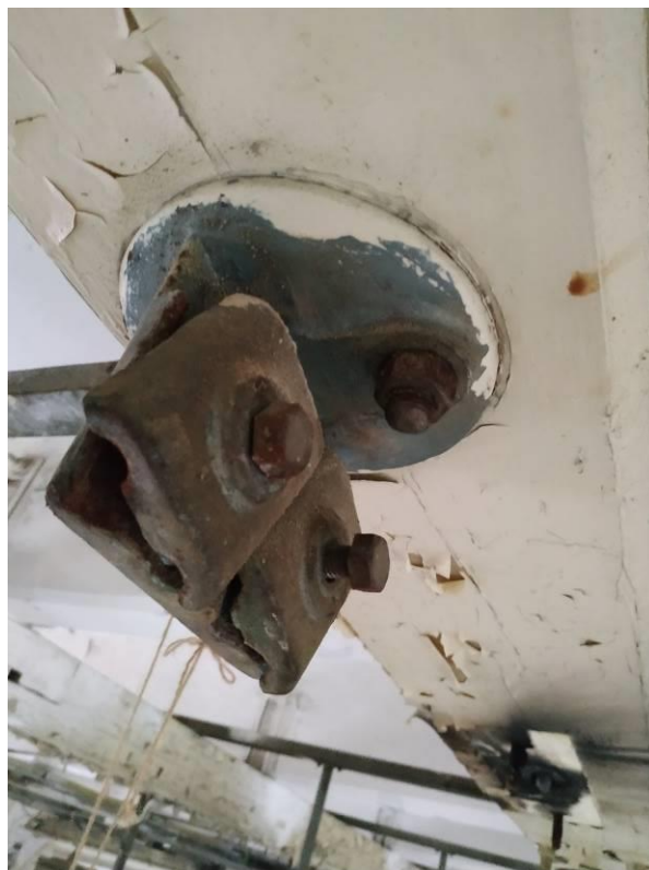
Detail ukotvení hlavy bambusových táhel – prvků XM014.04.01 k trámům XM014.04.02 (vyfocen nezachovávaný prvek před demontáží)
