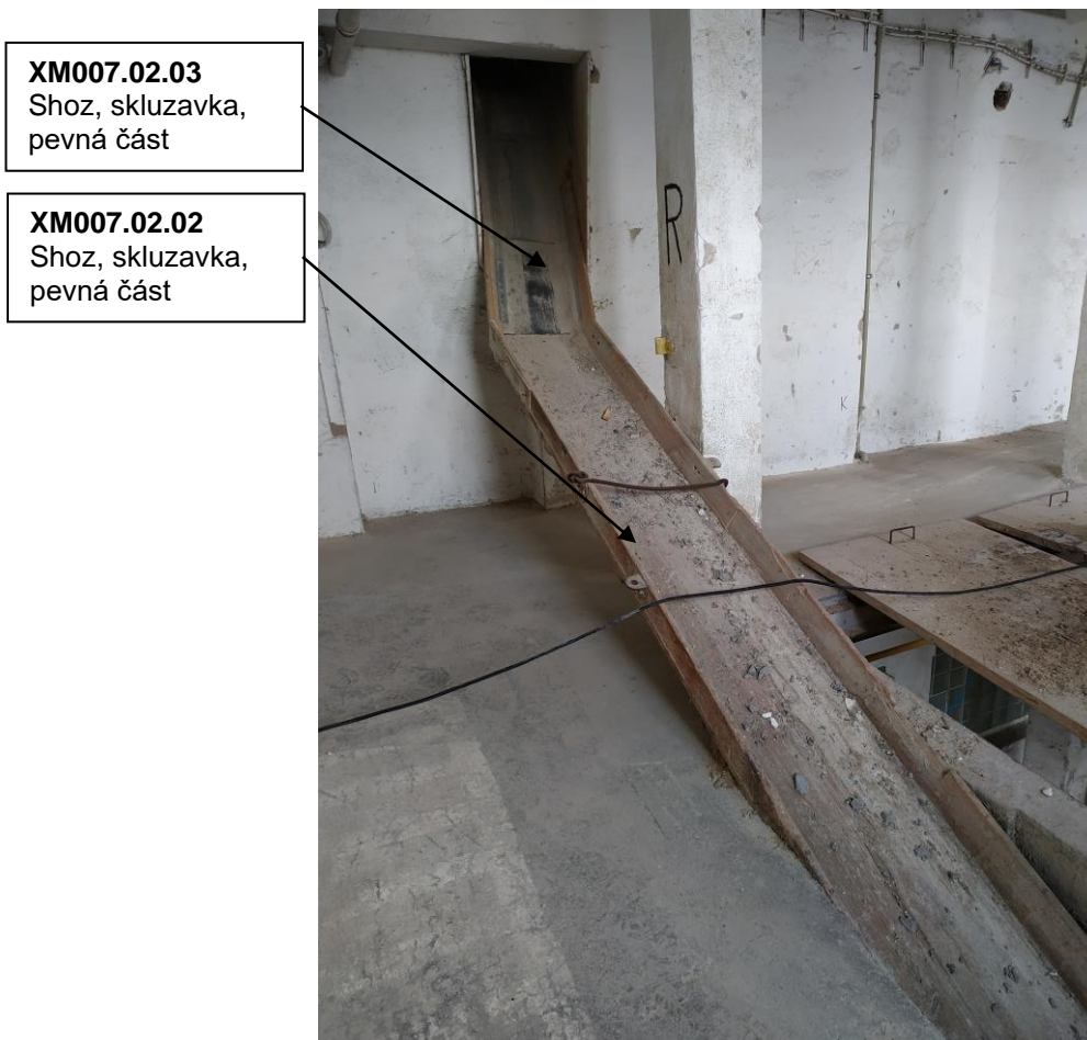
Pohled na shoz prvku XM007 v prostoru 2.NP, označený XM007.02.02 a XM007.02.03
