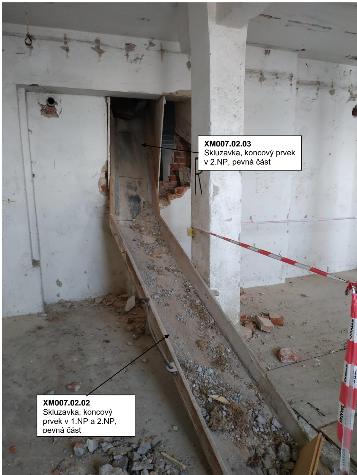
Pohled na koncový prvek shozu, skluzavku v prostoru 2.NP, rozděleno na části XM007.02.02 a XM007.02.03
