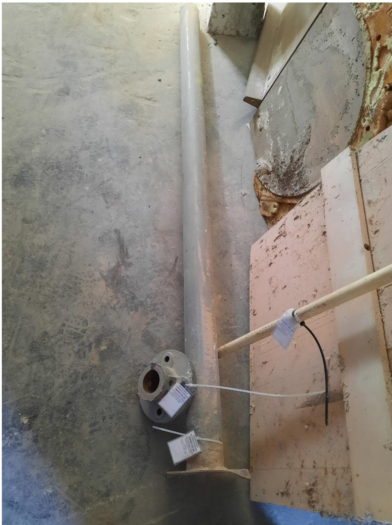
Pohled na demontované, oštitkované a uložené prvky ocelového sloupu XM007.02.04 a ocelové patky XM007.02.05 v prostoru 1.NP, místnost č.1.38
