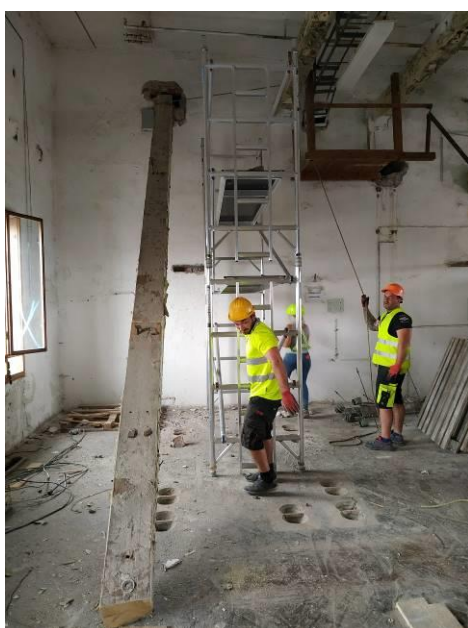
Snesení demontovaného trámu XM014.04.02Z
