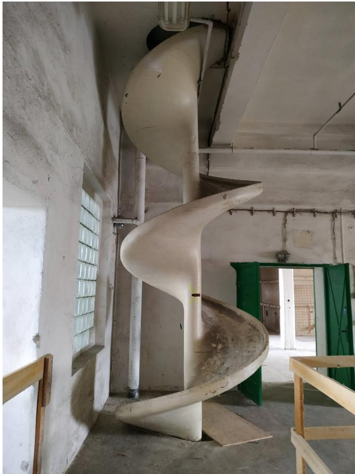
Pohled na prvek shozu XM007 v prostoru 4.NP před zahájením demontáže
