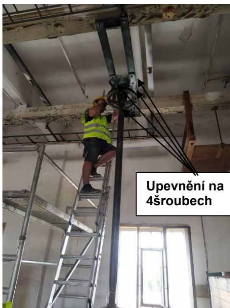
Uvolnění hřídele XM014.03.07 od prvku 08
