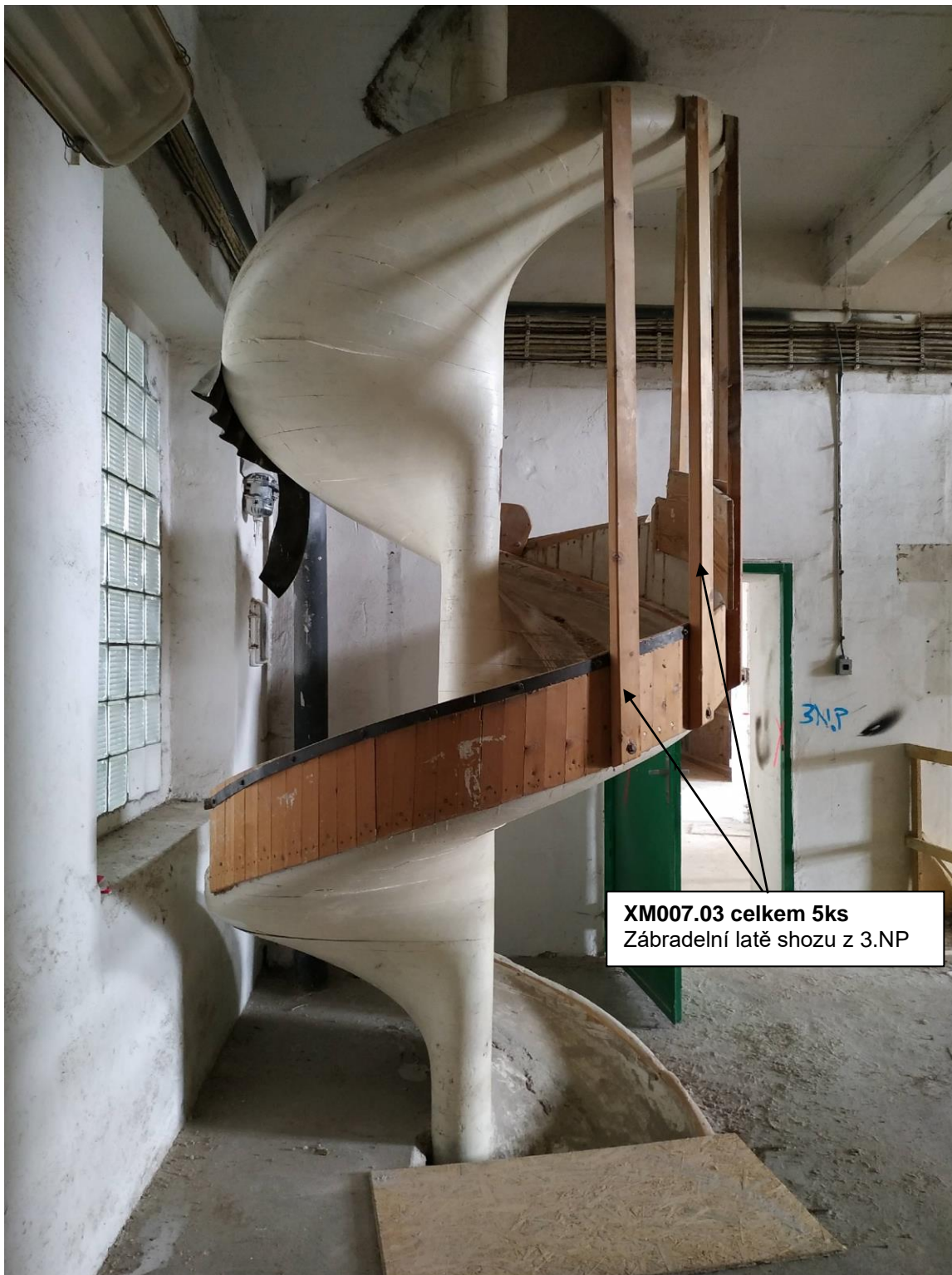
Pohled na prvek XM007 v prostoru 3.NP s vyznačením demontovaných latí, které byly označeny jako XM007.03, celkem 5ks a uloženy v 1.38
