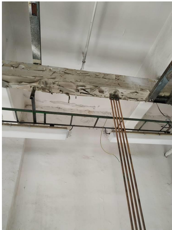
Detail uložení bambusových závěsů (XM014.04) – viditelná povrchová úprava nosných trámů
