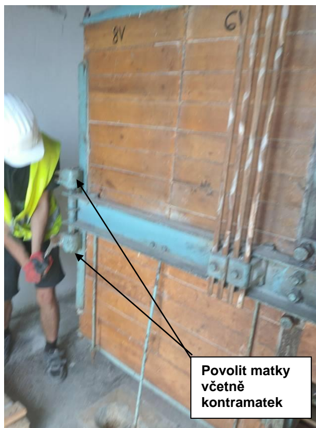
Demontáž prvku XM014.03.09A,B,C,D
