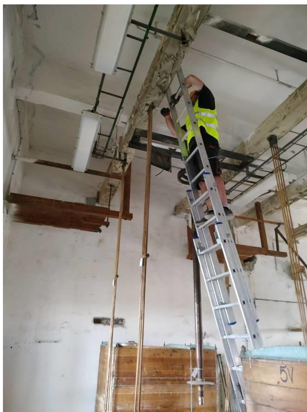
Demontáž bambusových táhel XM014.04.01LČ, PČ, LZ, PZ
