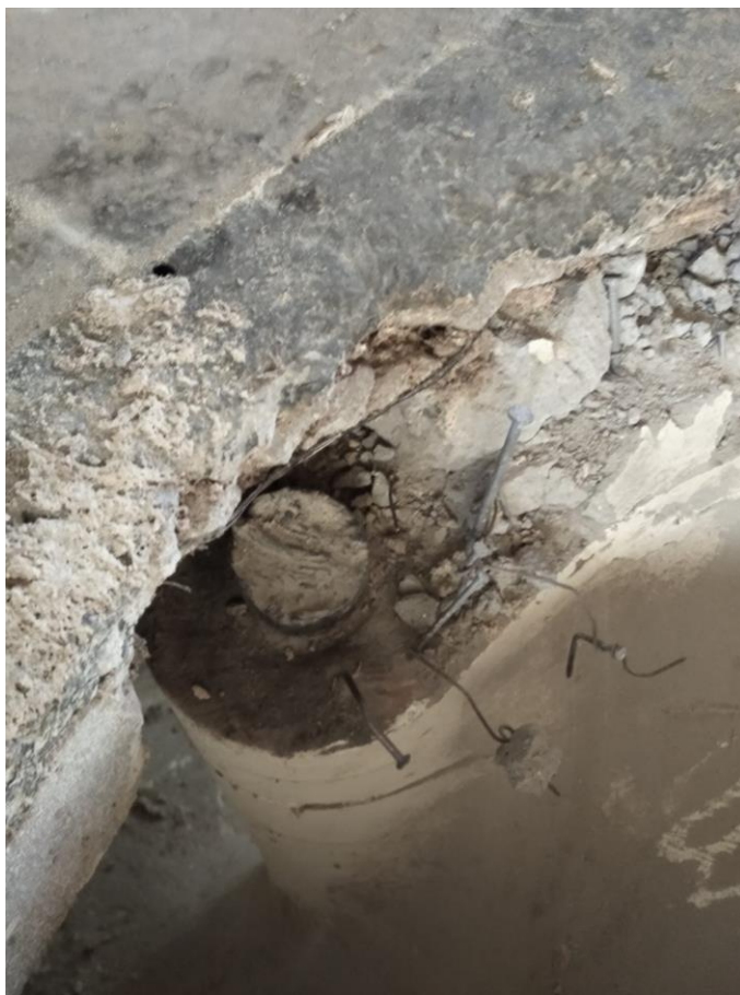
Pohled na shoz XM007.01 z prostoru 5.NP po provedené sondě uložení vřetene do stropu
