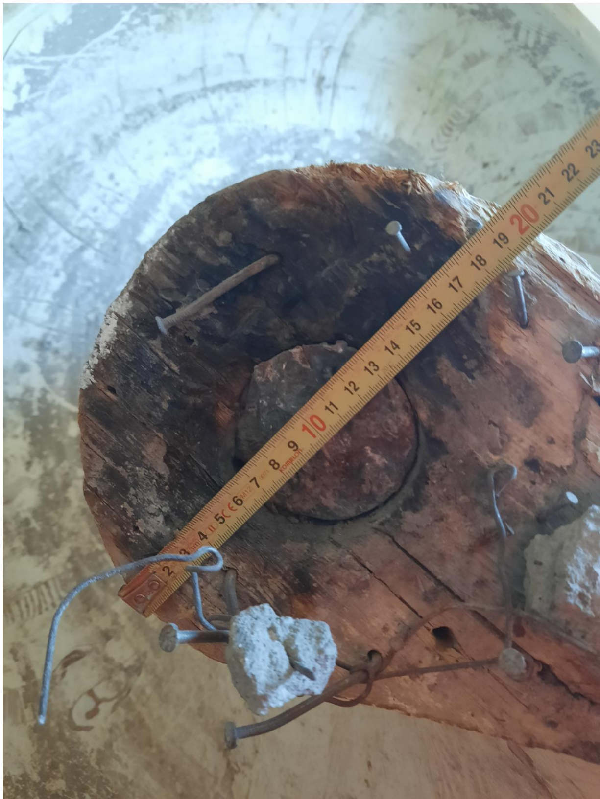
Pohled na dimenzi ocelového a dřevěného vřetene prvku skluzavky XM007.01
