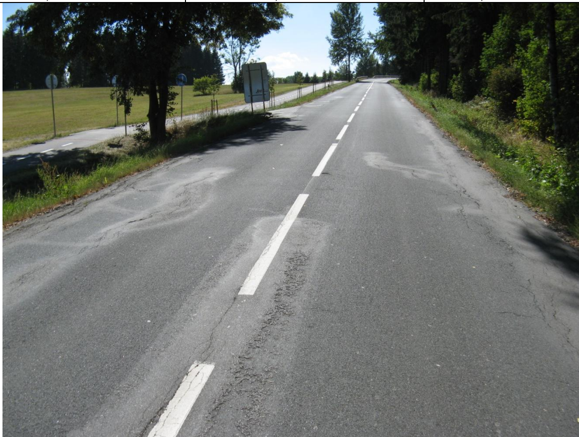
F05, km 50,910+ Síťové trhliny podél okrajů vozovky.
