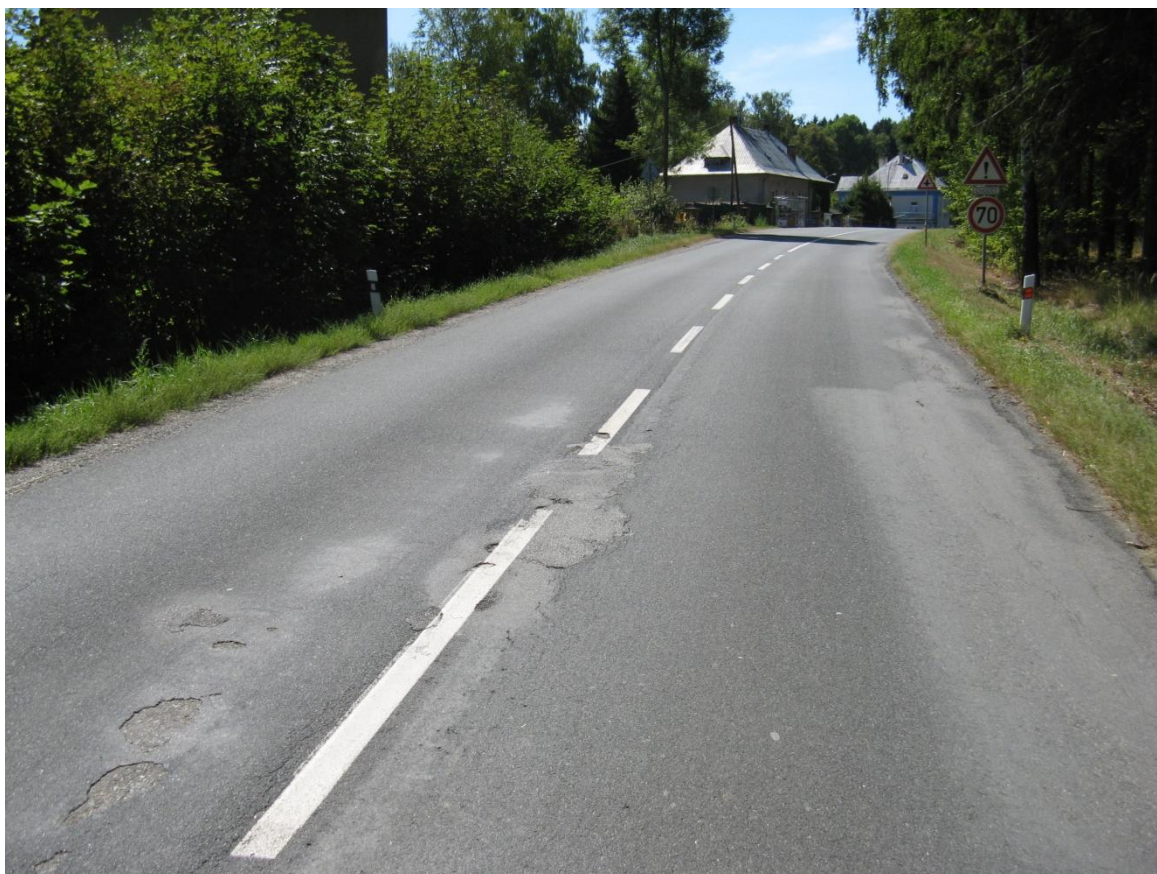
F20, km 52,110+ Koroze EKZ ošetřená tryskovou metodou.
