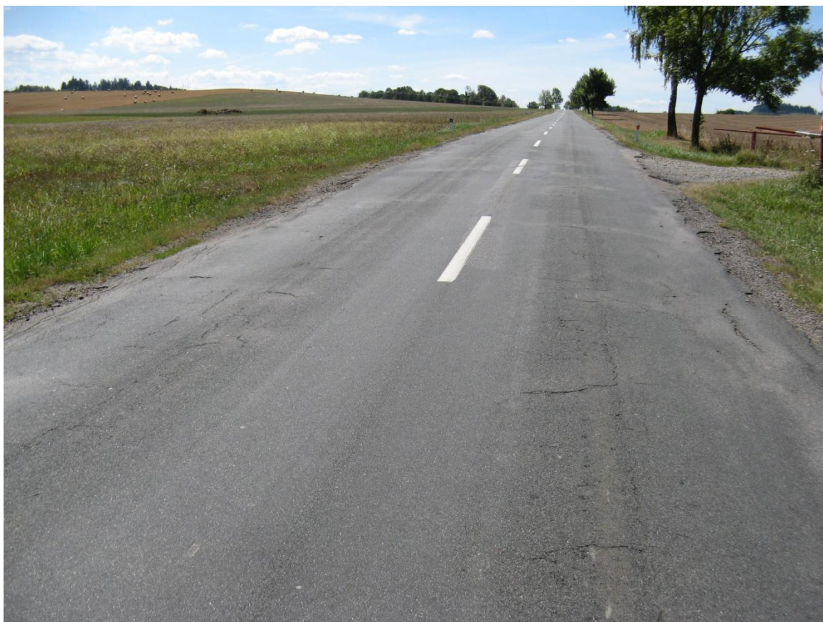
F37, km 53,410+ Olamování okraje vozovky a deformace podél okrajů.
