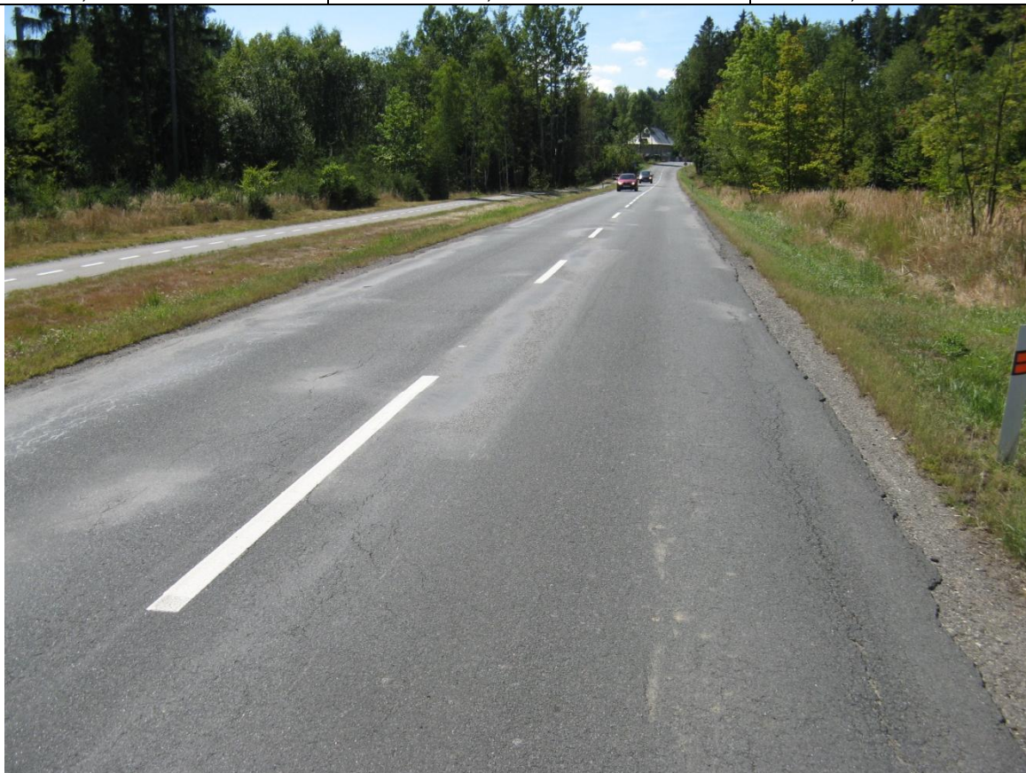
F18, km 52,910+ Olamování okrajů vozovky a mozaikové trhliny.
