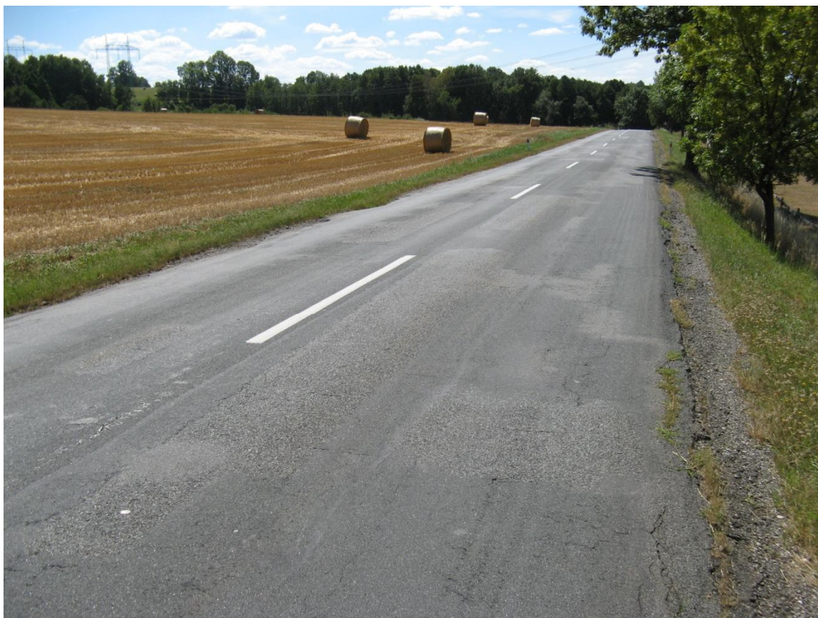
F49, km 54,310+ Koroze EKZ, olamování okrajů vozovky, vlevo deformace podél okraje.
