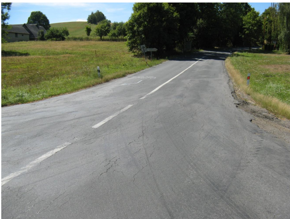
F62, km 55,120+ Plošné deformace.
