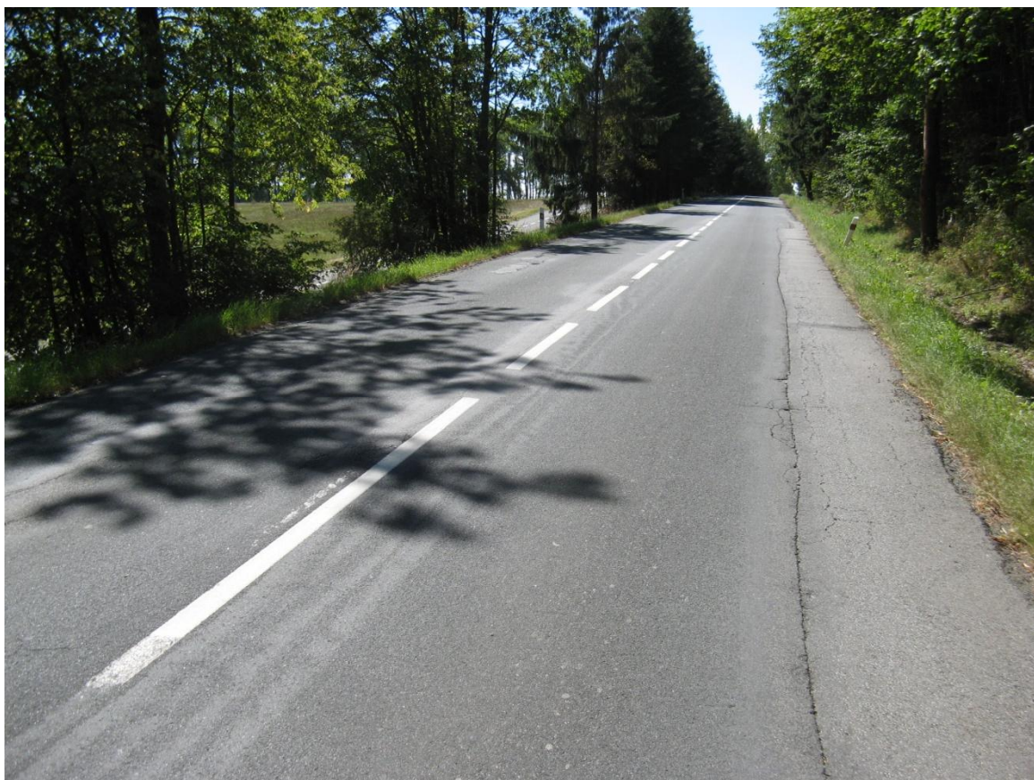
F09, km 51,310+ Vysprávký se síťovými trhlinami podél okrajů vozovky.
