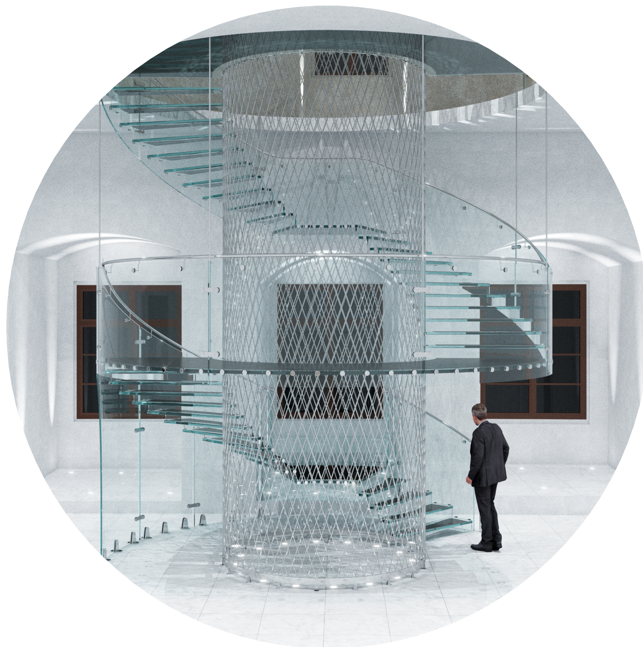
SCHODIŠTĚ A FOYER
