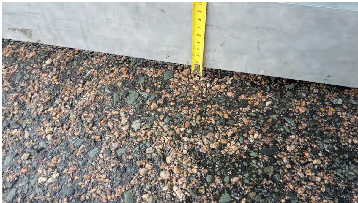
Obr. 8 Vyjetá kolej v levém jízdním pruhu, km 18,215 (cca 10 mm)
