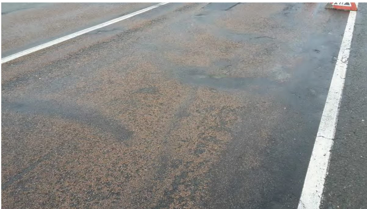
Obr. 3: Ztráta kameniva asfaltového nátěru
