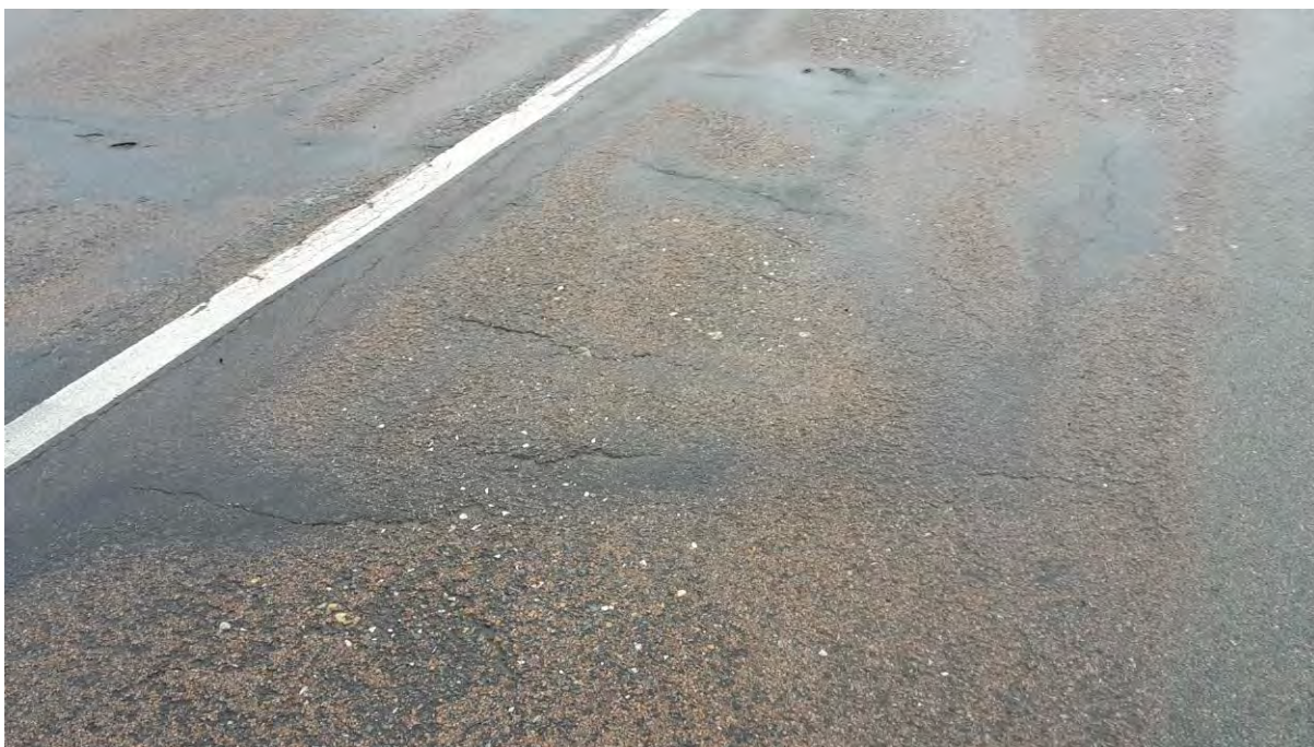
Obr. 7 Nepravidelné trhliny
