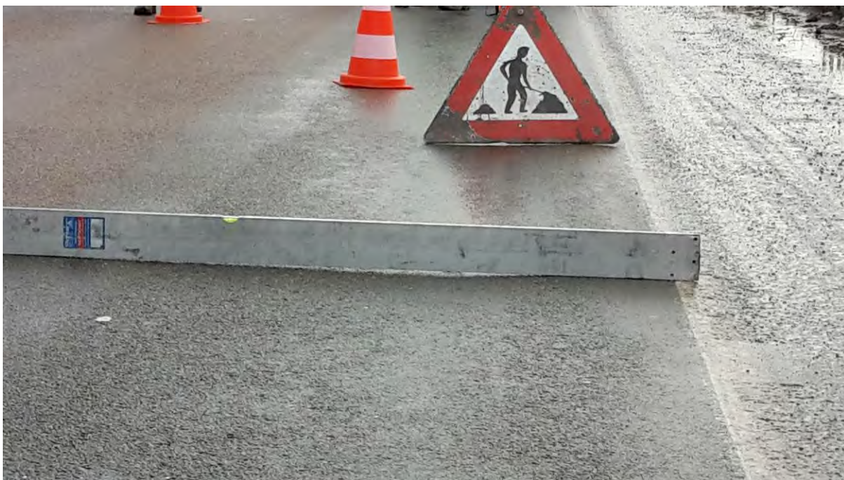
Obr. 8 Vyjetá kolej v pravém jízdním pruhu, km 18,110
