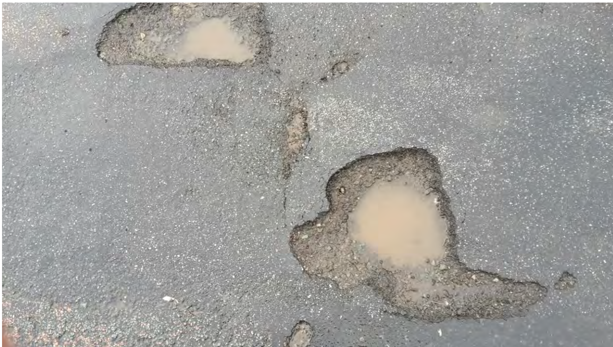
Obr. 5 Výtluky v obrusné vrstvě, oprava tryskovou metodou
