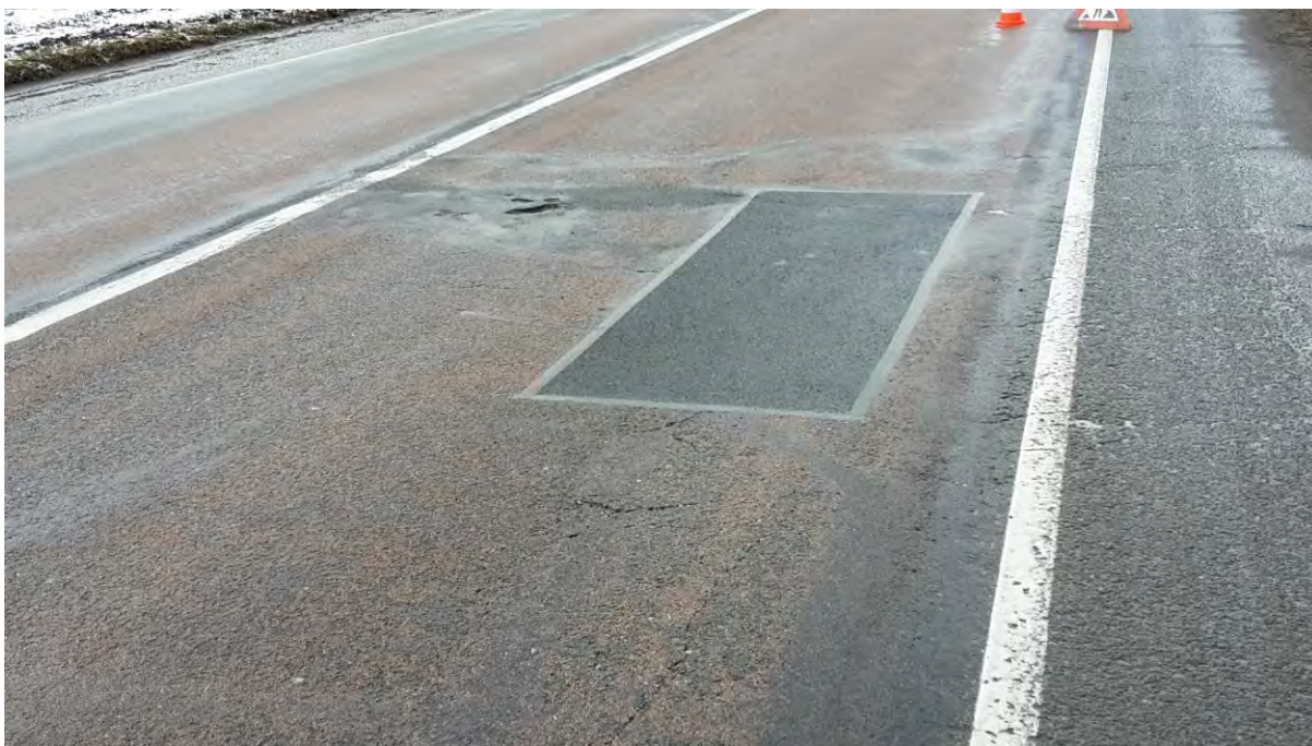
Obr. 6 Plošné vysprávkování obrusné vrstvy, výtluky
