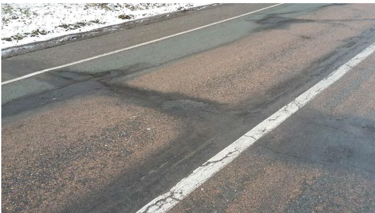
Obr. 4: Příčná rozvětvená trhlina opravená tryskovou metodou
