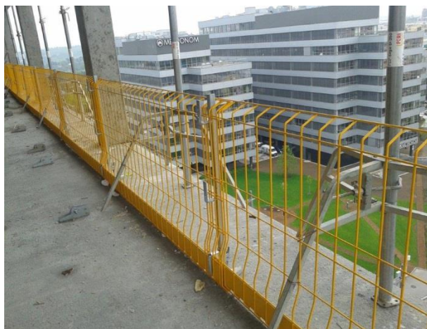
Boční patka PSF Pro montáž k desce, stěně nebo schodišťovému rámu
