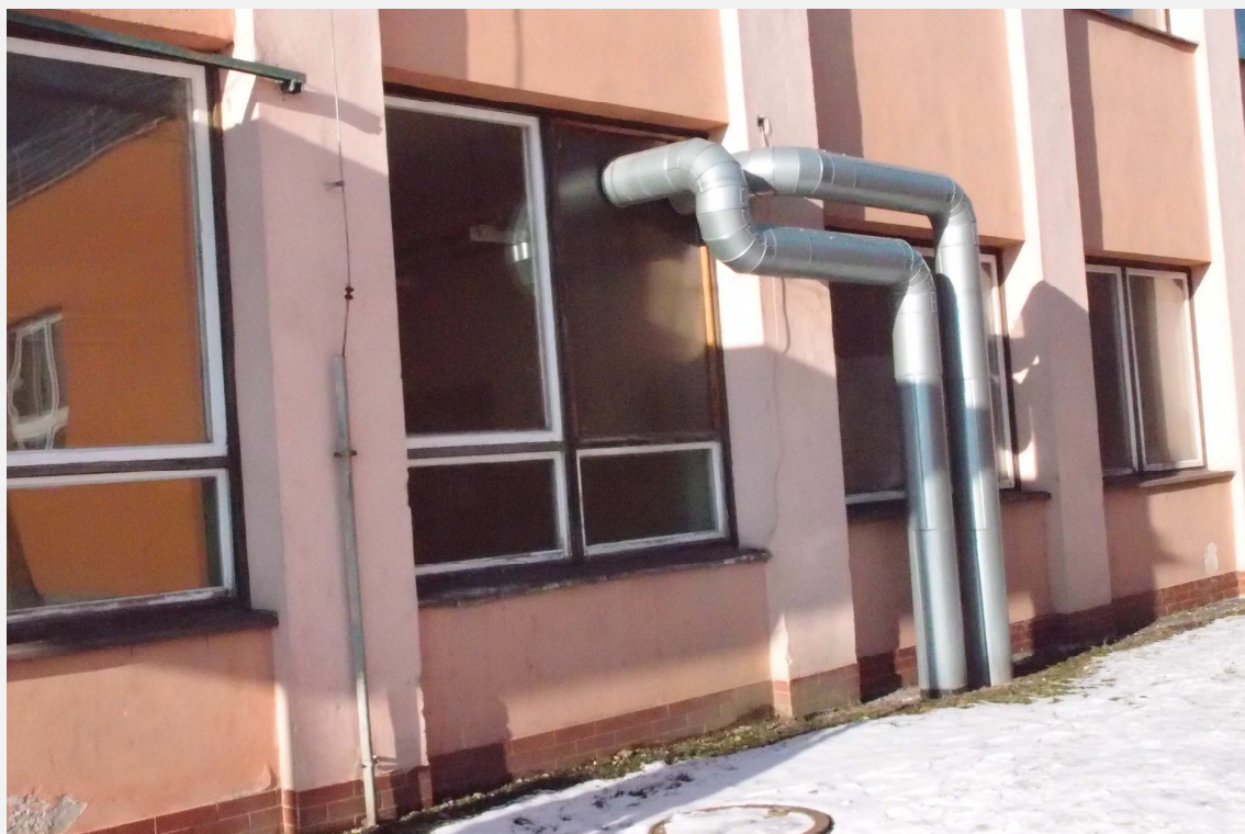
Přívod tepovodu do budovy
