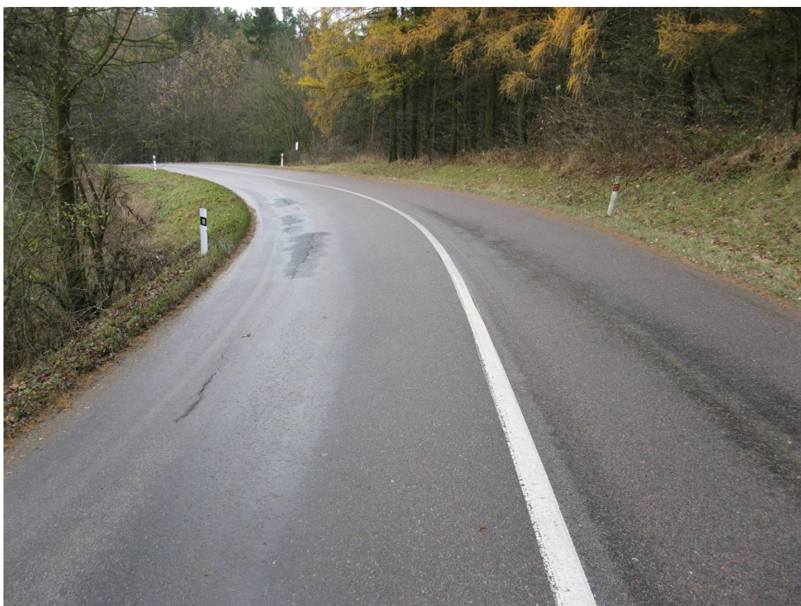
F107, km 38,660+ Podélné trhliny široké. Podél okraje vozovky.
