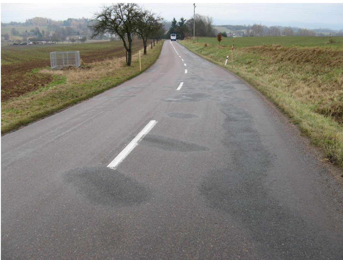
F48, km 35,710+ Mozaikové a nepravidelné trhliny ošetřené tryskovou metodou.
