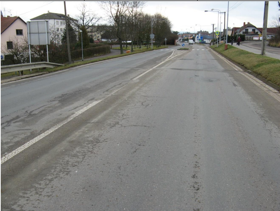
F181, km 42,110+ (Lanškroun) Koroze, mozaikové trhliny, příčné trhliny.
