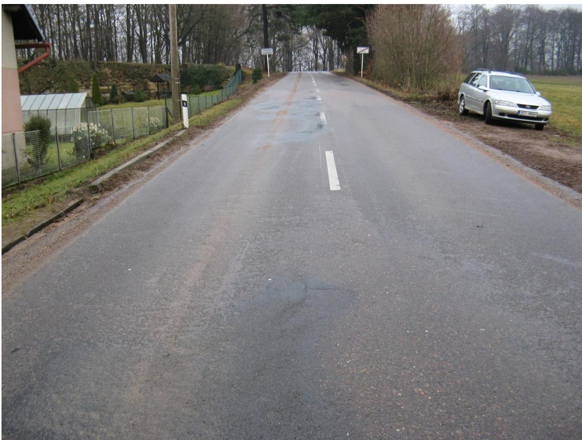
F07, km 33,810+ (Skuhrov) Nepravidelné a mozaikové trhliny, hloubková koroze.
