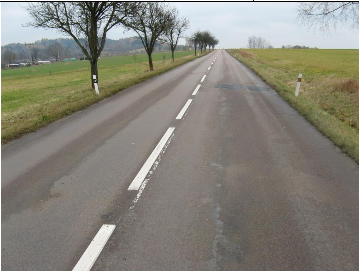
F81, km 37,310+ Vyjeté koleje do 18 mm, lokální vysprávkky.
