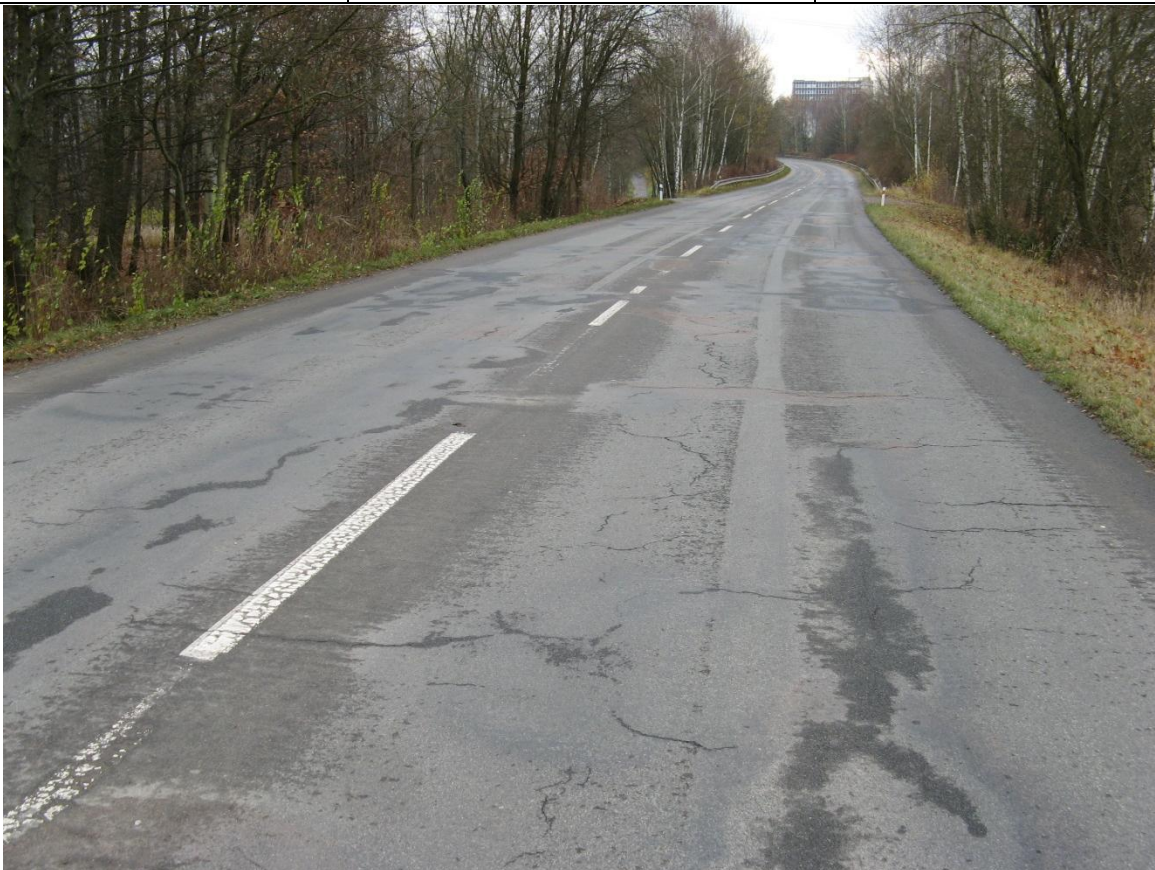
F161, km 41,110+ Nepravidelné a mozaikové trhliny, vysprávký.
