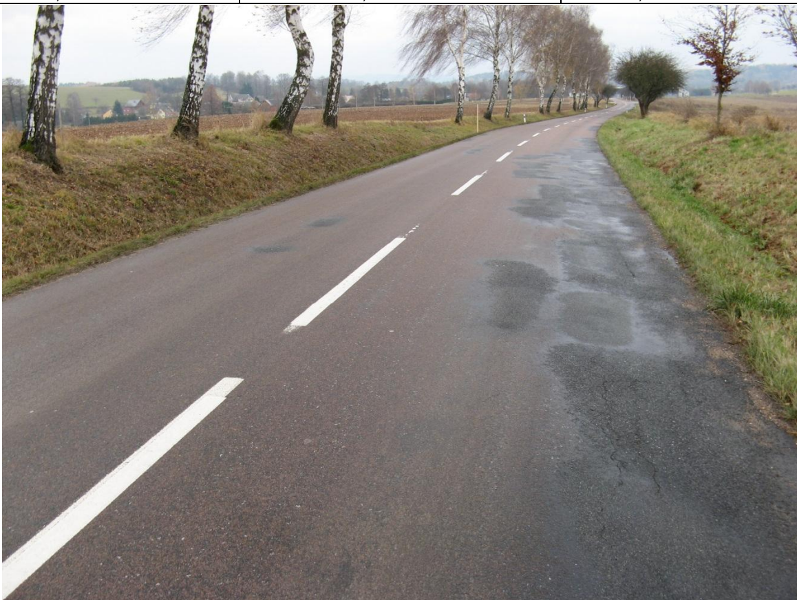
F56, km 36,110+ Síťové trhliny s plošnými deformacemi podél okraje.
