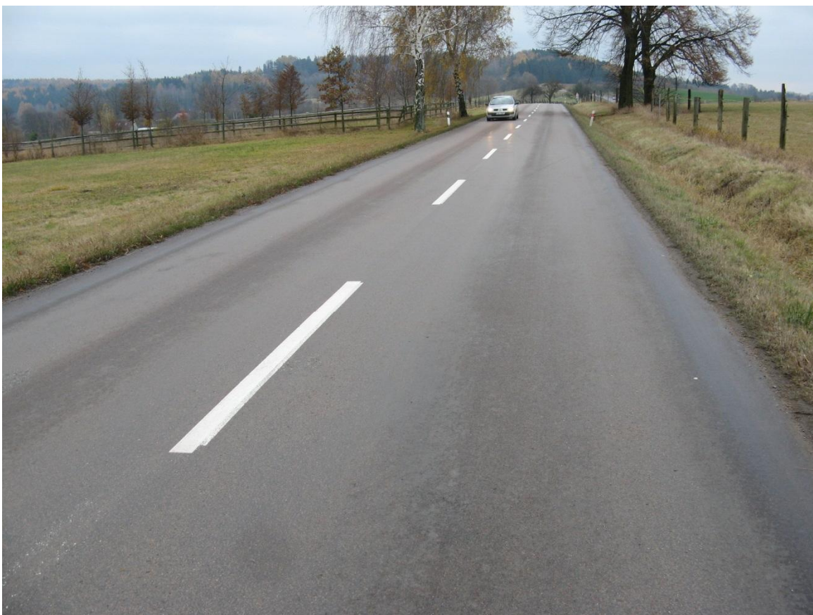
F89, km 37,710+ Vyjeté koleje do 22 mm, ztráta makrotextury v jízdních stopách.
