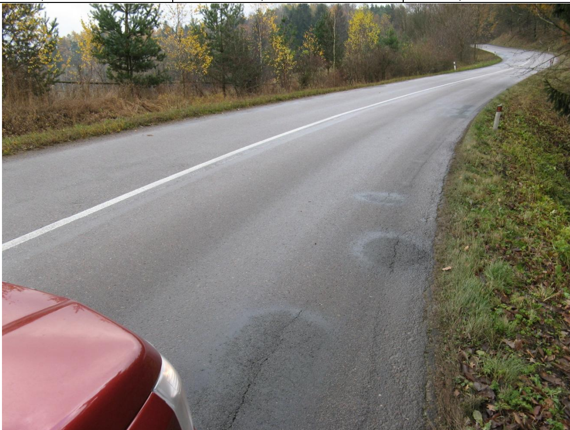
F105, km 38,510+ Podélné trhliny tenké.
