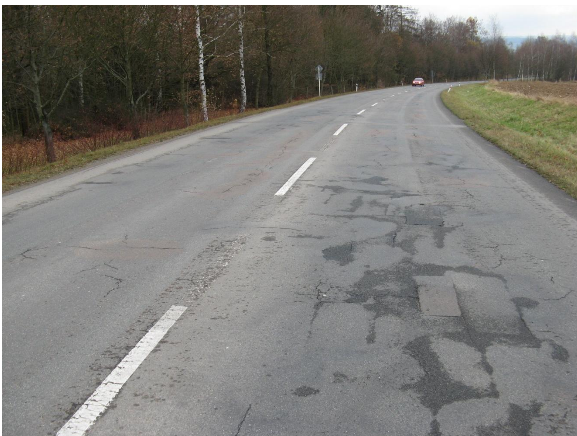
F157, km 40,910+ Nepravidelné a mozaikové trhliny, vysprávky, nepravidelné hrboly.
