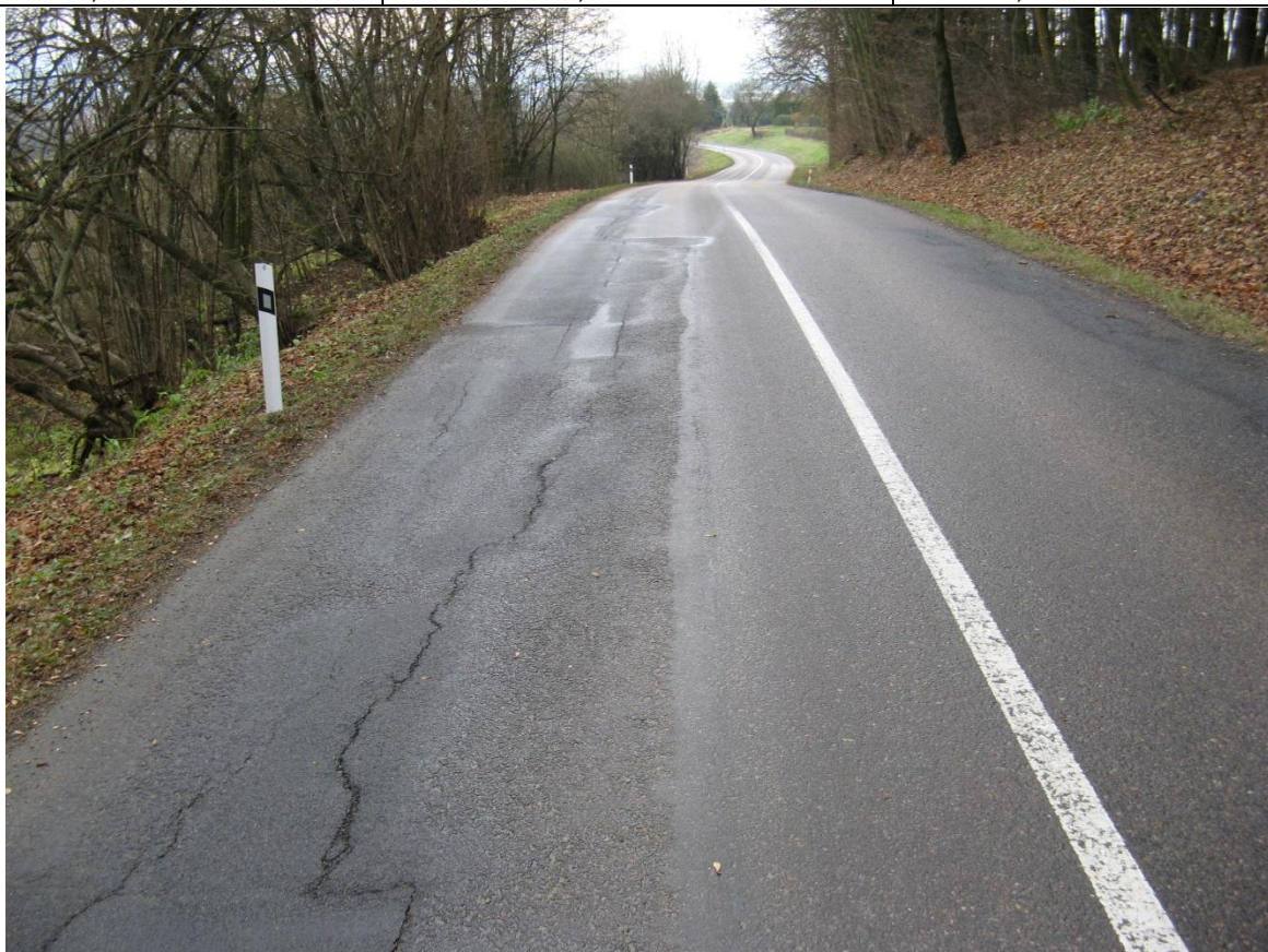
F142, km 40,310+ Podélné trhliny široké a vysprávky podél okraje vozovky.
