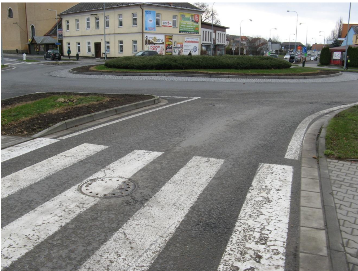
F186, km 42,410+ (Lanškroun) Novější povrch v okolí okružní křižovatky. Ztráta asfaltového tmelu, příčná trhlina rozvětvená.
