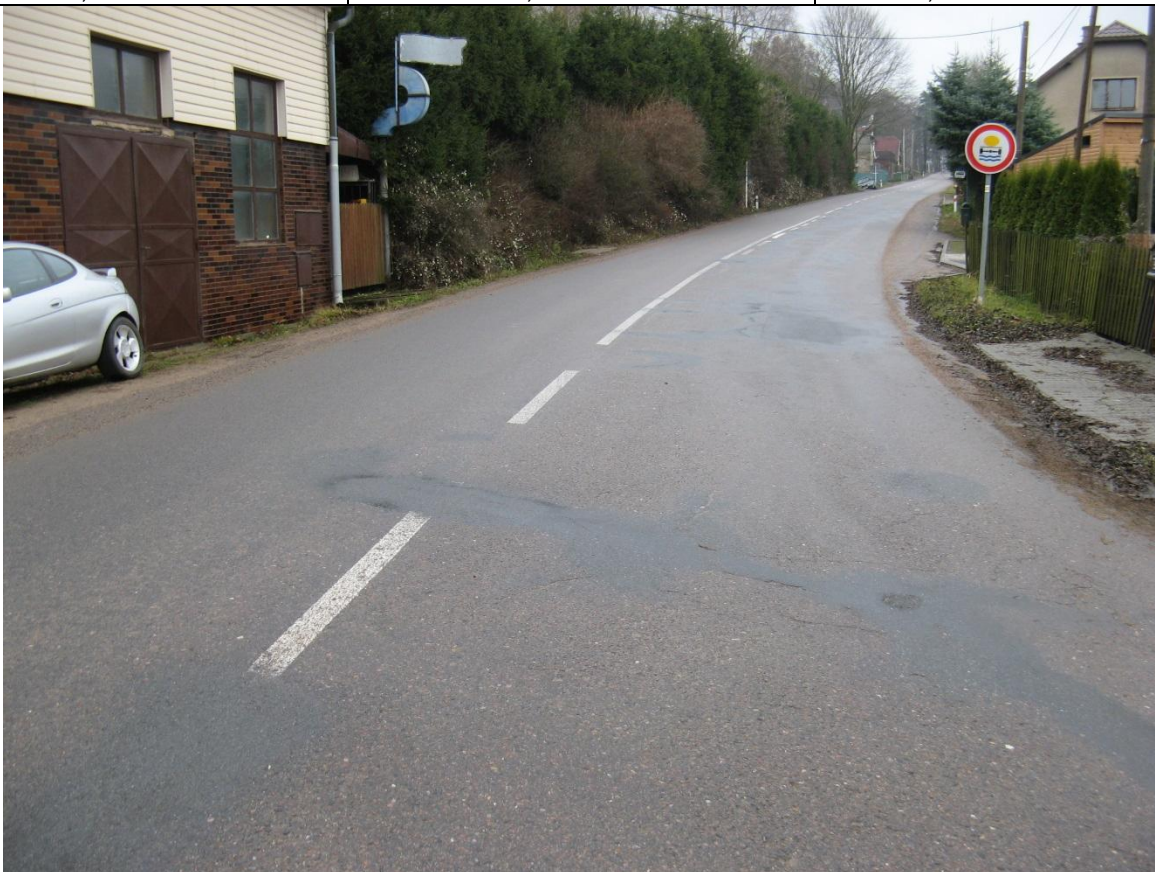
F03, km 33,610+ (Skuhrov) Příčná trhлина, mozaikové trhliny, ztráta asfaltového tmelu.
