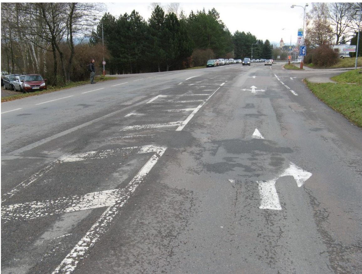
F175, km 41,810+ (Lanškroun) Koroze, nepravidelné a mozaikové trhliny, vysprávký.
